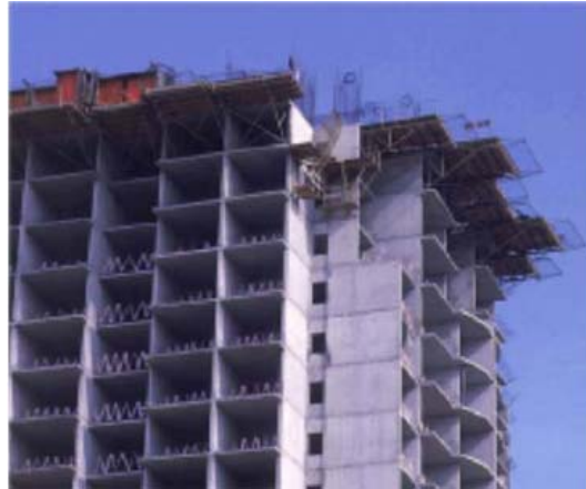
Şekil 1.1: Tünel kalıp sistemiyle inşa edilen bir bina
