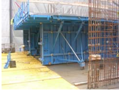
Şekil 2.2: Ek kalıp kullanımıyla konsol oluşturulması
