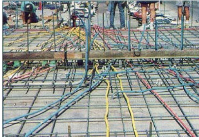
Şekil 2.10: Döşemedeki elektrik tesisatı boşluk rezervasyonları ve aks betonu kalıbı yerleşimi
