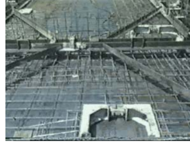
Şekil 2.10: Döşemedeki elektrik tesisatı boşluk rezervasyonları ve aks betonu kalıbı yerleşimi
