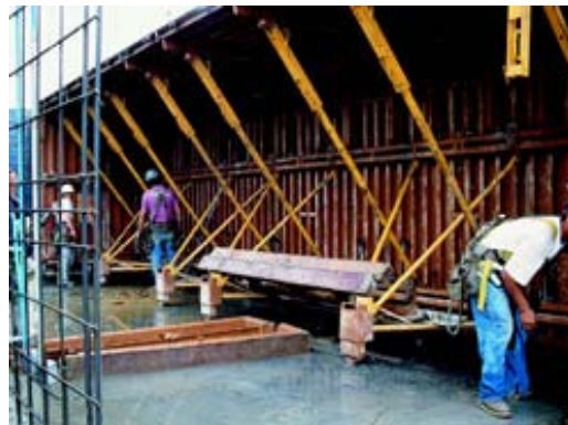
Şekil 2.6: Yarım tünel kalıp ve çapraz dikme çubukları [8]
