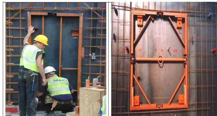
Şekil 2.3: Kapı ve pencere rezervasyon elemanları
