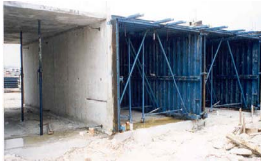
Şekil 2.11: Kalıbı alınan tünelin dikmelerle desteklenmesi (Resmin solunda)
