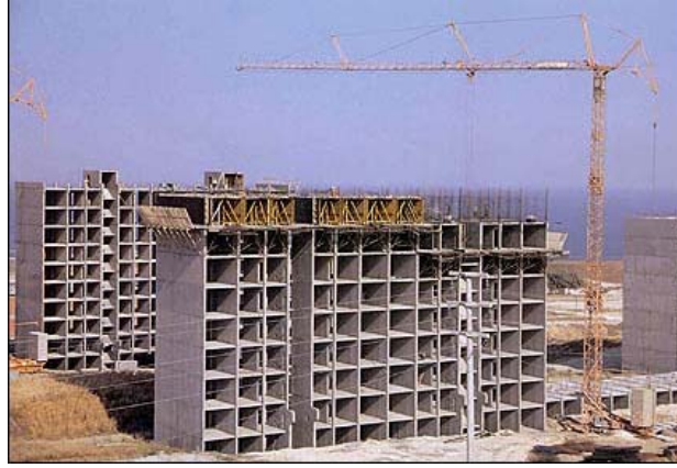
řekil 2.1: Kule vin ile ok katlı tnel kalıp uygulaması
