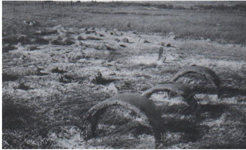
Şekil 2.10: Sülfat Etkisiyle Beton Elemanların Hasara Uğraması b) Sülfatlı Bir Zemine Bırakılan Beton Boruların Bozulması [55]
