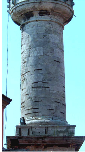
Şekil 3.9: Minarede güçlendirme
