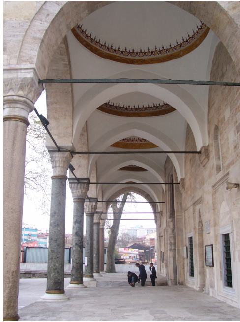
Şekil 4.4: Murat Paşa Camii son cemaat mahalli
