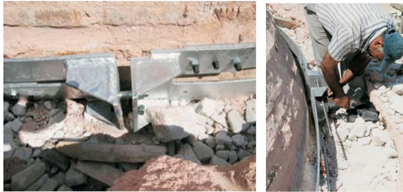
Şekil 3.12: Ahi Çelebi Camii kubbe eteğinde çekme çemberi oluşturulması [5]
