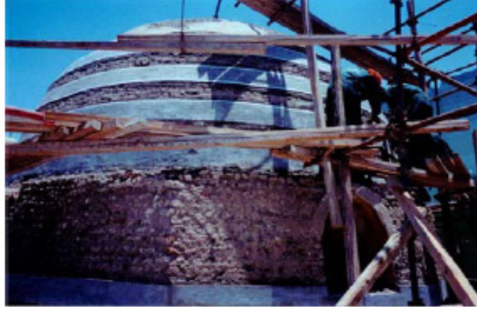
Şekil 3.16: Kubbede değişik seviyelerde CFRP uygulaması (El-Eini Kubbesi, Mısır) [16]
