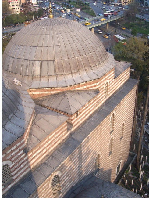
Şekil 4.2: Murat Paşa Camii minaresi'nden üst örtü sisteminin görünüşü
