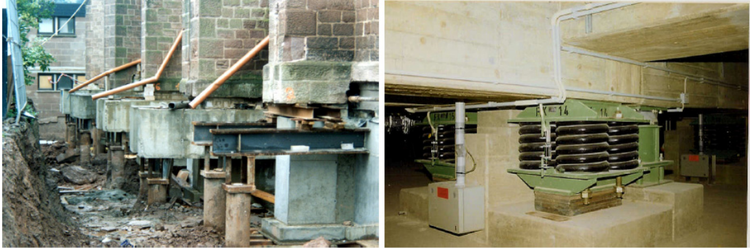
Şekil 3.20: Sismik yalıtım uygulaması [37]
