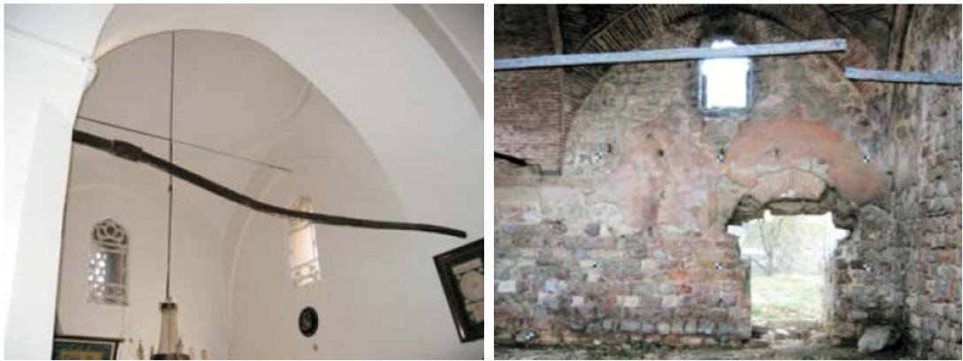
Şekil 2.12: Demir gergide hasar biçimleri a. Burkulma (Atik Ali Paşa Camisi) b. Kopma (Edirne sarayı mutfakları) [5]
