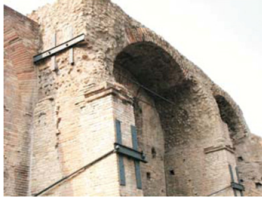
Şekil 3.10: Kemerlerde gergi düzenlemesi ve mesnetlerin sabitlenmesi (Roma Forumu'nda Yapı) [5]
