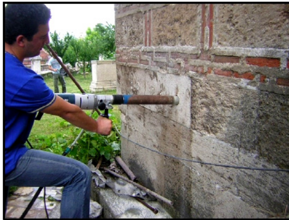
Şekil 2.24: Yapıdan numune alınması [36]
