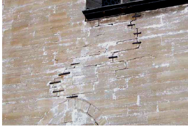
Şekil 3.3: Çatlak duvarın dikilerek onarılması
