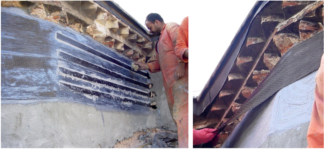
Şekil 3.15: Kubbe kasnağında FRP uygulaması (Küçük Ayasofya Camii, İstanbul) [13]
