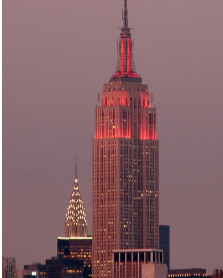
Şekil 2.4 : Empire State Building
