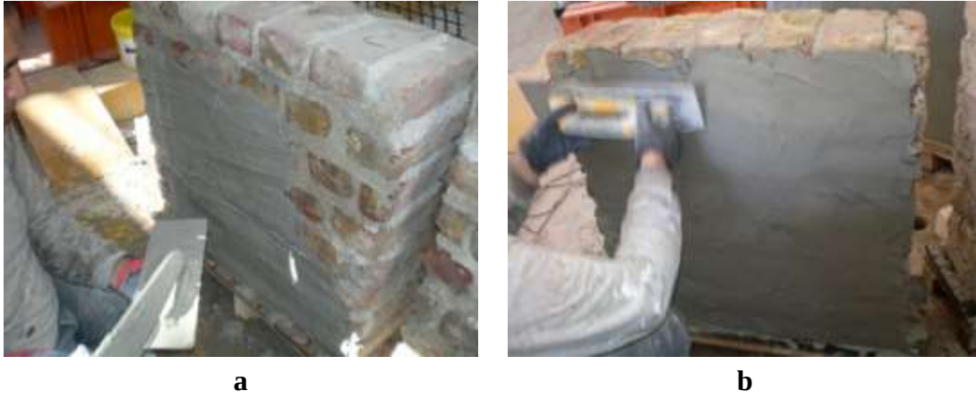
Şekil 4.2 : Duvar numunelerine sıva uygulanması.
