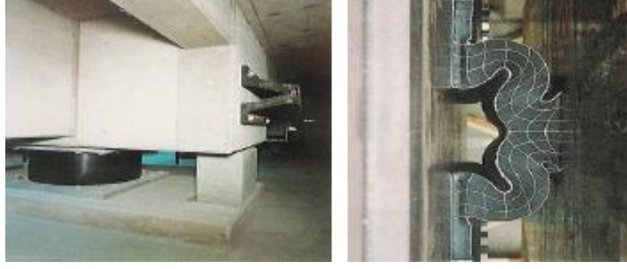
Şekil 2.16: Deprem esnasında yapının izolasyon katı seviyesinde maksimum deplasmanı yapması durumunda yapının zarar görmemesi için yerleştirilen kauçuk durdurucular (Doğan, 2007).
