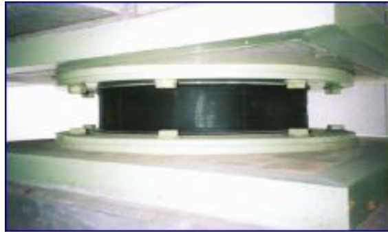
řekil 2.19: Yapı üzerine montajı tamamlanmıř bir yüksek sönümlü kauçuk mesnet örneęi (Yücesoy, 2005).
