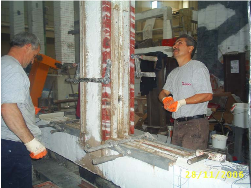
Şekil 5.3: Hasar görmüş tip 1 numunesine çelik elemanlarla güçlendirme uygulaması
