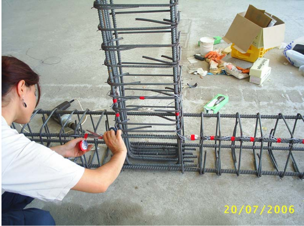
řekil 4.7: Deney numuneleri donatılarına řekil deęiřtirme ölçer yerleřimi
