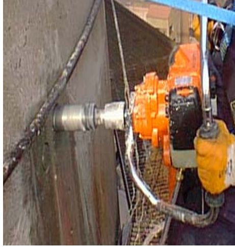
Şekil 1.1: Karot numune alınışı
