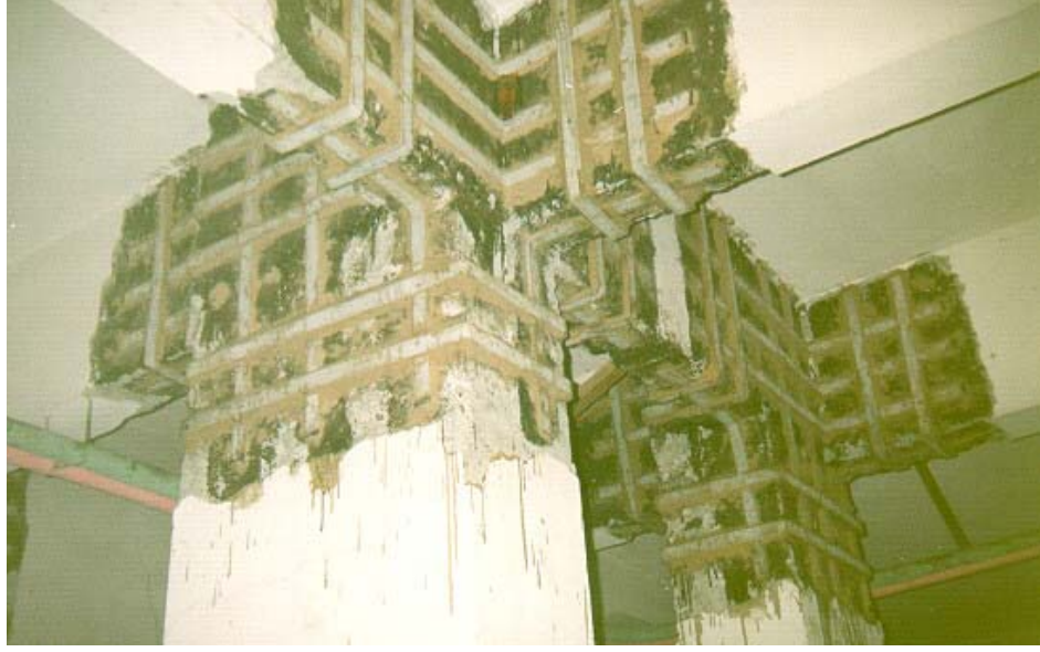
Şekil 2.4: Güçlendirilmiş düğüm bölgeleri
