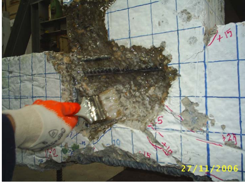
Şekil 3.4: Beton onarımı yapılacak yüzeye epoksi astar uygulaması
