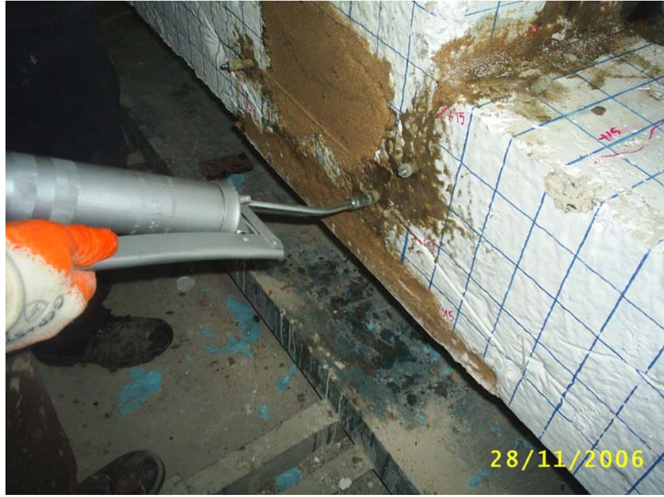
Şekil 3.6: Düğüm bölgesindeki çatlaklara epoksi enjeksiyonu uygulaması
