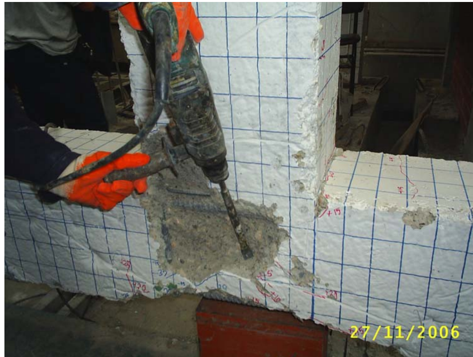
Şekil 3.3: Düğüm bölgesi beton onarım hazırlığı
