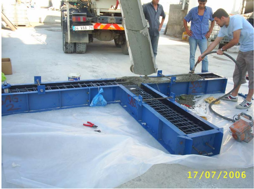
Şekil 4.8: Deney numuneleri çelik kalıplarına vibratörle uygun beton dökümü
