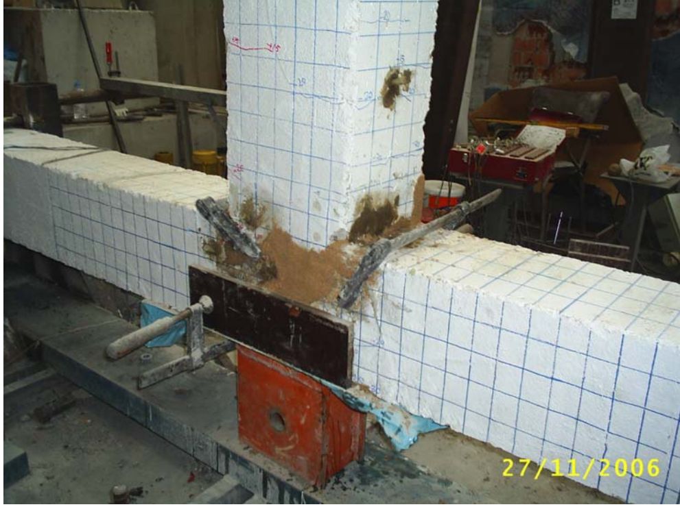
Şekil 5.2: Hasar görmüş tip 1 numunesine beton onarım uygulaması
