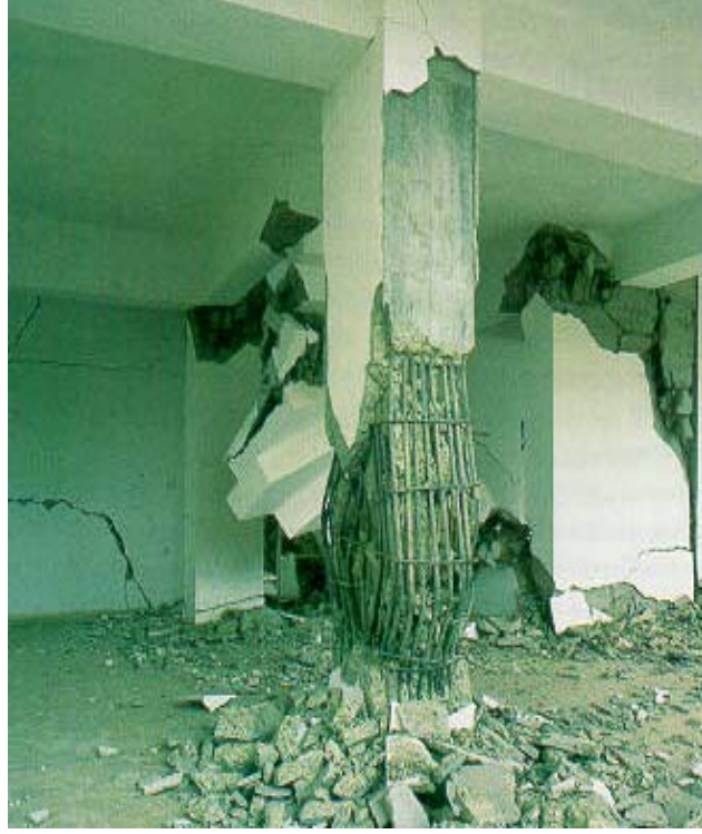
Şekil 2.2 : Basınç kırılması
