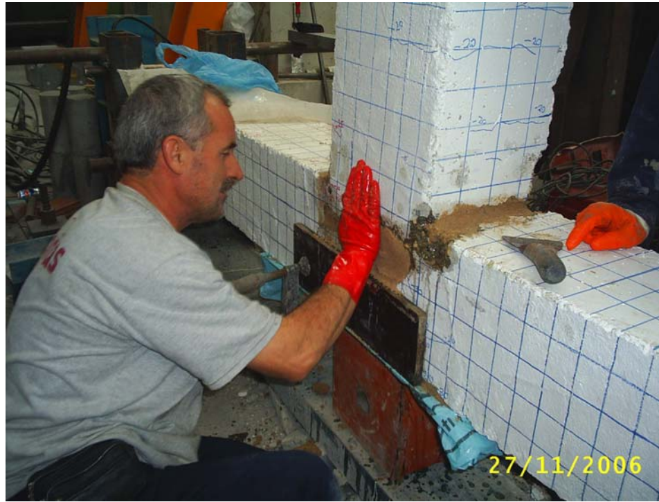
Şekil 3.4: Beton onarımı yapılacak yüzeye epoksi astar uygulaması
