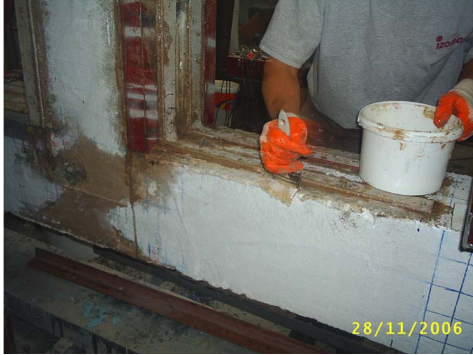
Şekil 3.7: Çelik elemanlarla güçlendirme öncesi epoksi adhesive uygulaması
