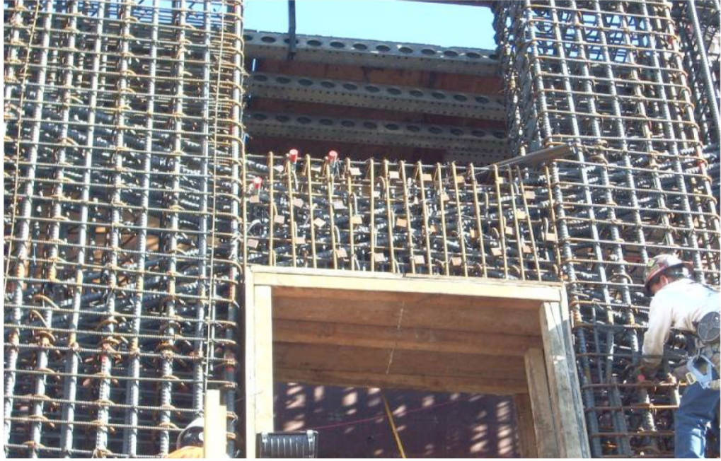
Şekil 5.25 : Çapraz donatılmış bağ kirişi uygulaması
