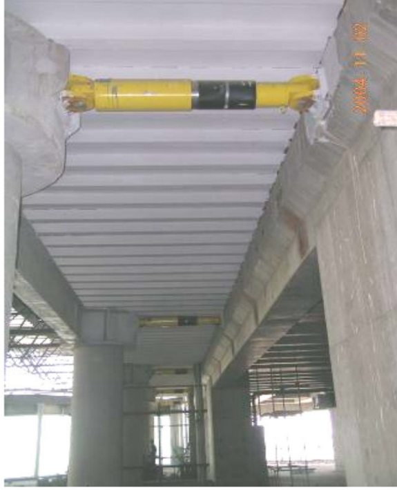
Şekil 3.2 : Hidrolik aktif sönümleyici eleman
