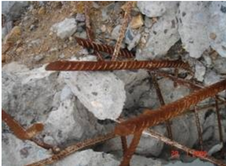
Şekil 7.8: 1. Kenar korugan perdelerinin hasar resimleri
