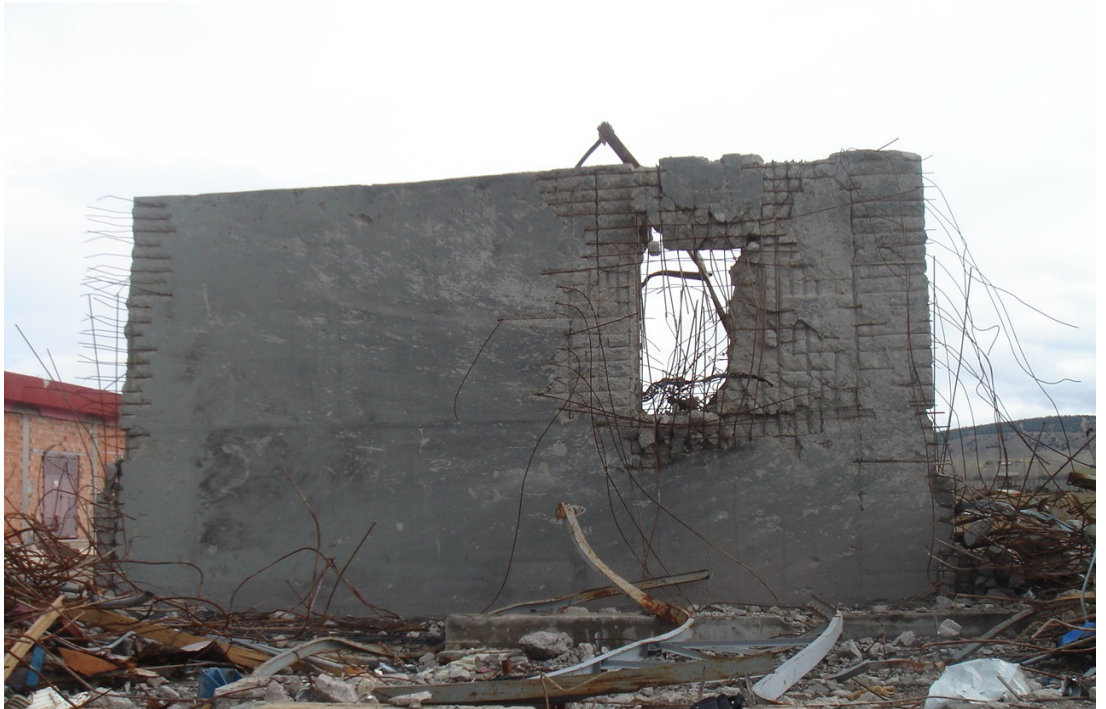
Şekil 7.9: 2. Kenar korugan hasar resimleri
