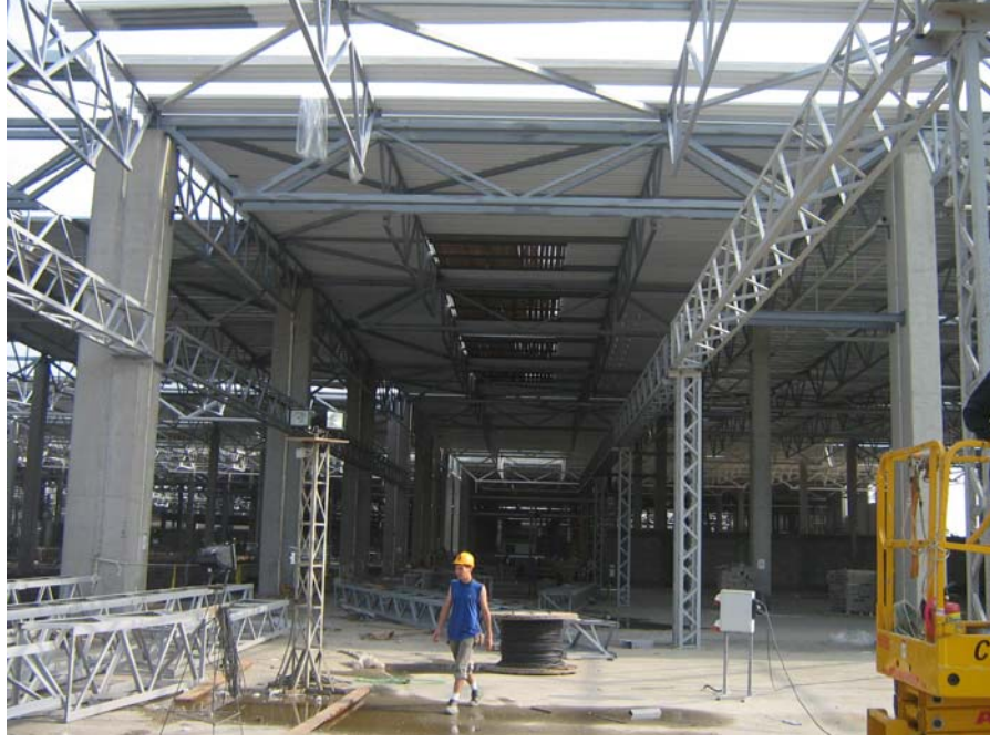
Şekil 5.18 : Çatı Sacı Montajı 1
