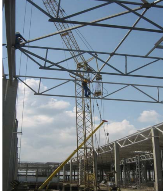
Şekil 5.17 : Çelik Makas Montajı 3
