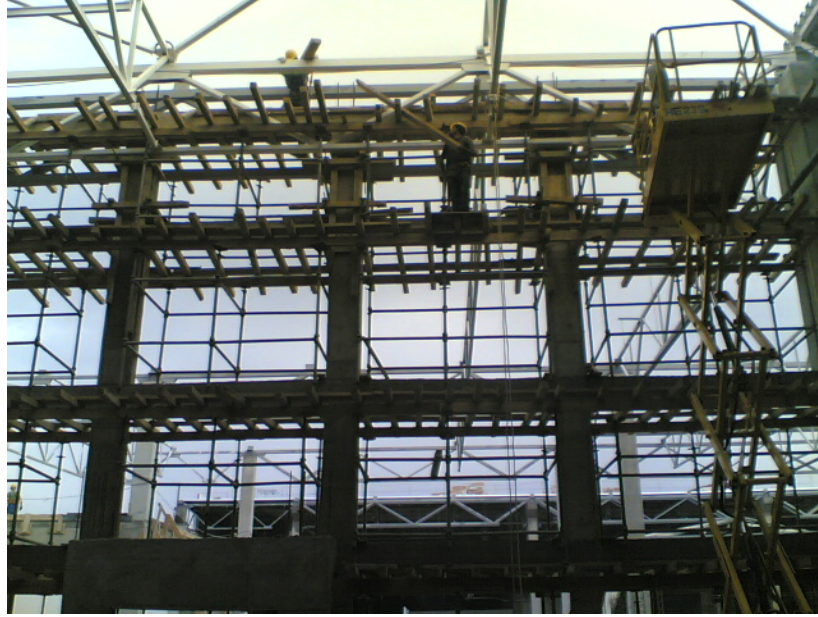
Şekil 5.19 : Gaz Beton Duvar imalatı 1
