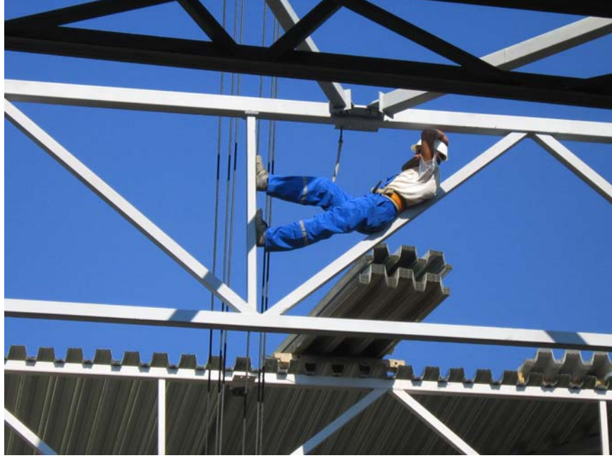
Şekil 5.16 : Çelik Makas Montajı 2
