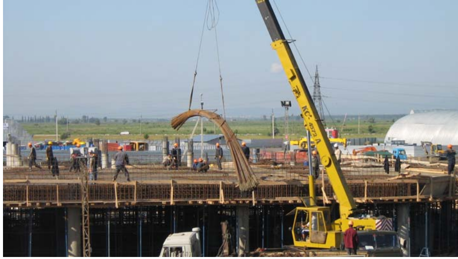
Şekil 5.5 : Vinç Çalışması Demir
