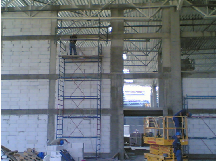
Şekil 5.20 : Gaz Beton Duvar imalatı 2
