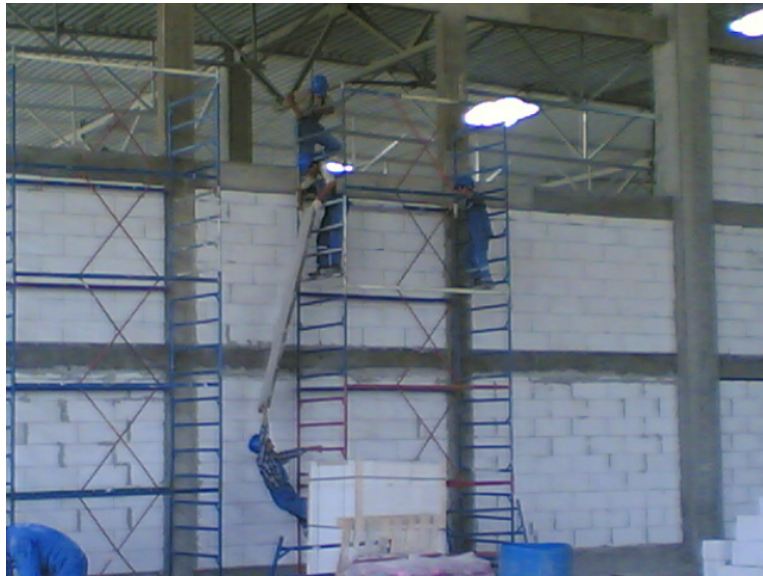
Şekil 5.21 : Gaz Beton Duvar imalatı 3
