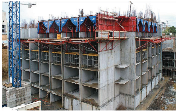
Şekil 2.2: Kalıp sistemindeki çalışma platformları ve korkuluklar.
