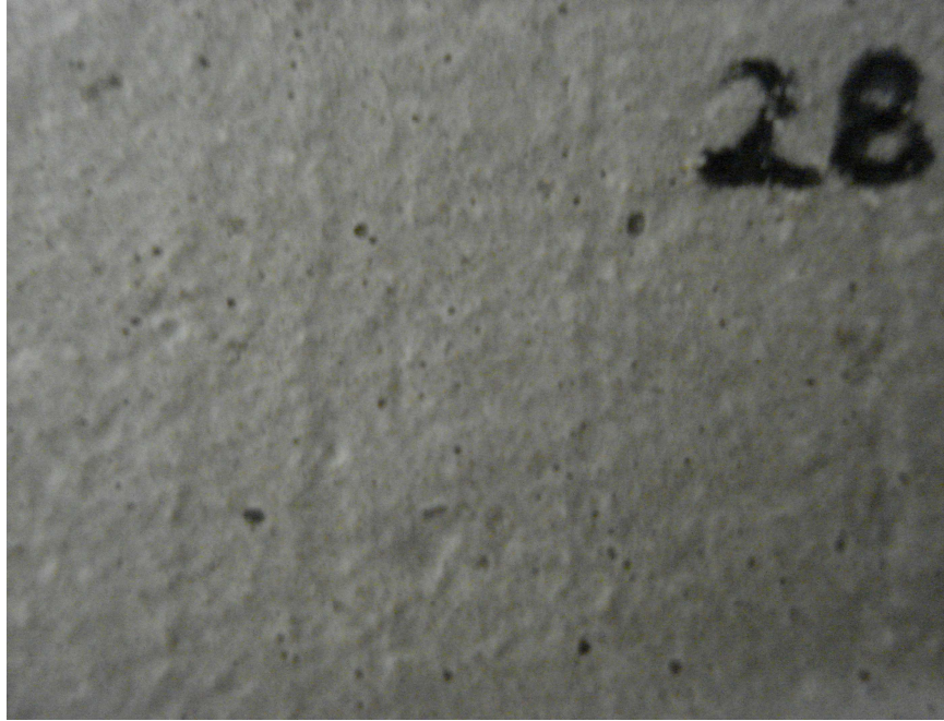
Şekil H-4: BYH katkılı harç çatlak takibi
