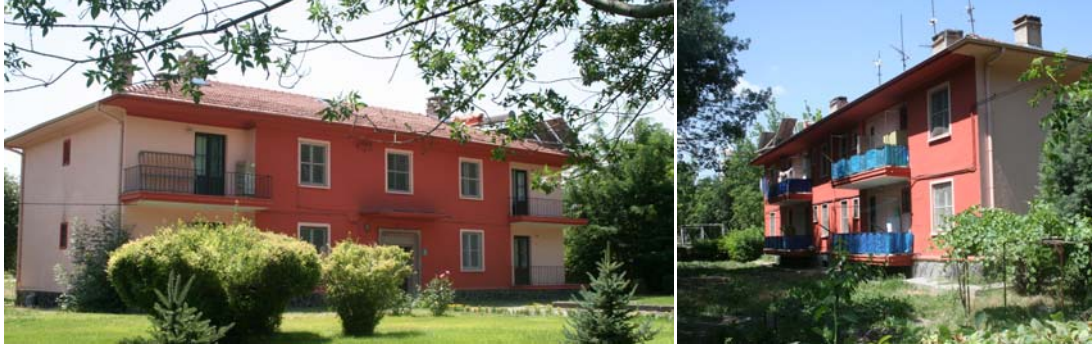
Şekil 4.68. TipD1 Şeker Fabrikası Lojmanı
