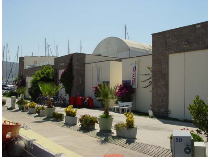
Şekil 4.52: Bodrum Karada Marina büro ve teknik servis birimleri
