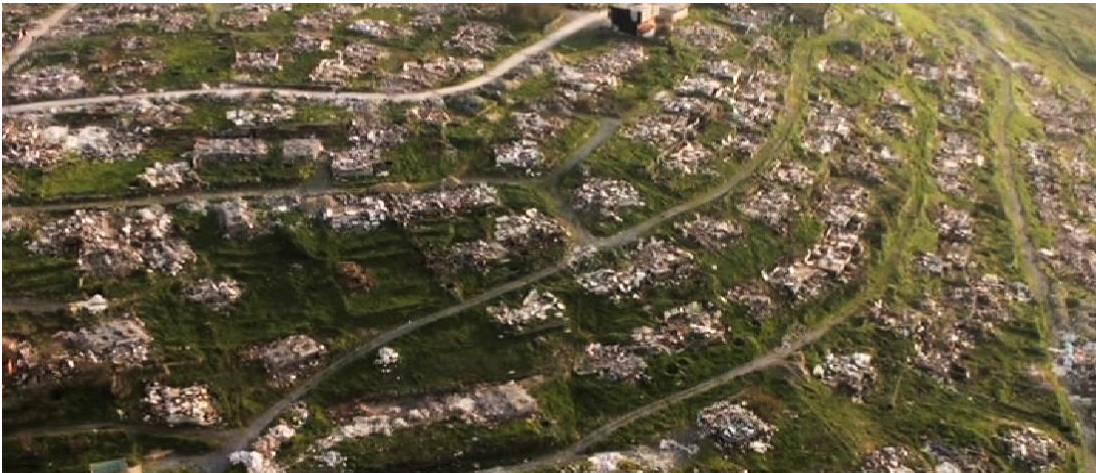
Şekil 4.24: Yıkım sonrası Ayazma (Günay, 2011).
