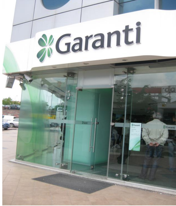
Şekil C.2: Garanti Bankası Dış Cephe İmajı.
