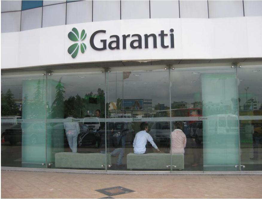
Şekil C.4: Garanti Bankası Dış Cephe İmajı.
