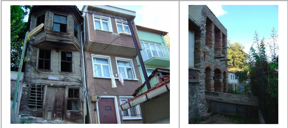
Şekil 5.9: Bakımsız ve terkedilmiş binalar
