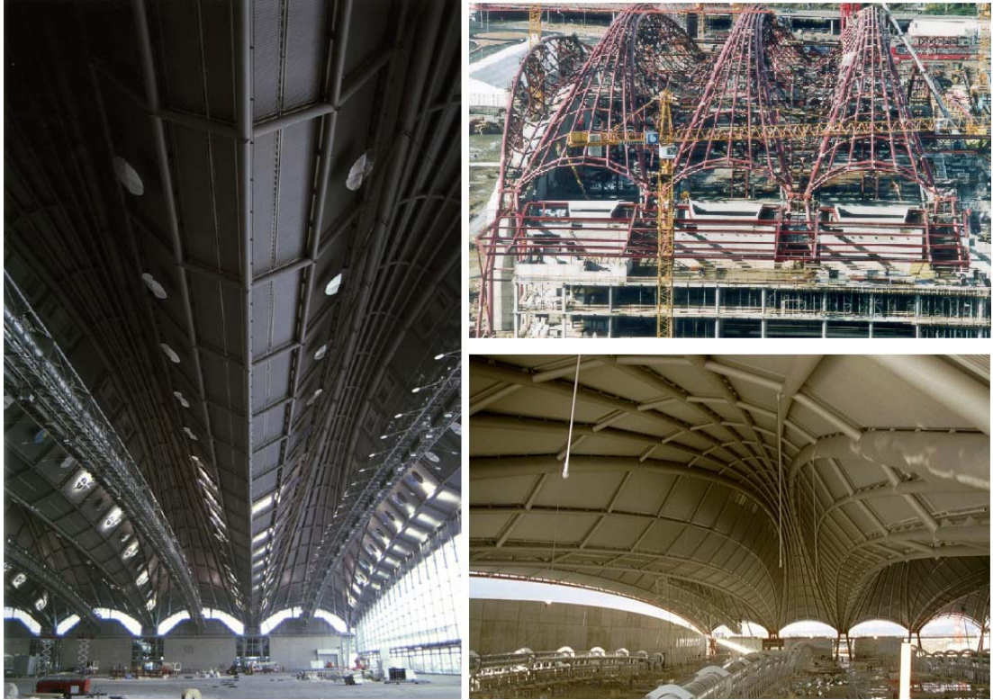
Şekil 5.5 : Yeni Sergi Salonu -3. Kısım Binası çatısı.
