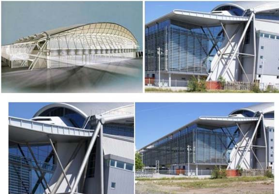
Şekil 5.7 : Çatı yüklerini kazıklı radyejeneral temele aktaran A çerçeveler.
