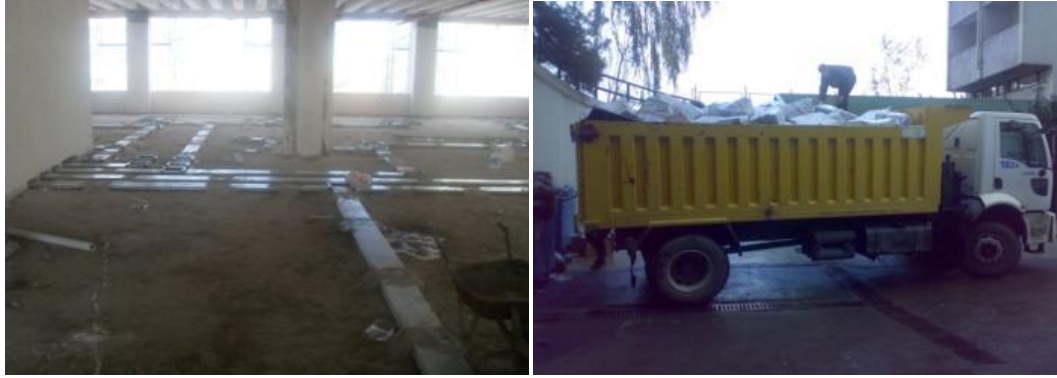
Şekil 4.29: Bina içerisinde yenileme çalışmaları neticesinde oluşan inşaat atıklarının toplanması.
