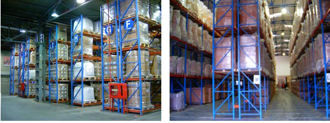
Şekil 3.7 : Sırt sırta raf sistemleri örneği (Hopbaoğlu, 2009).
