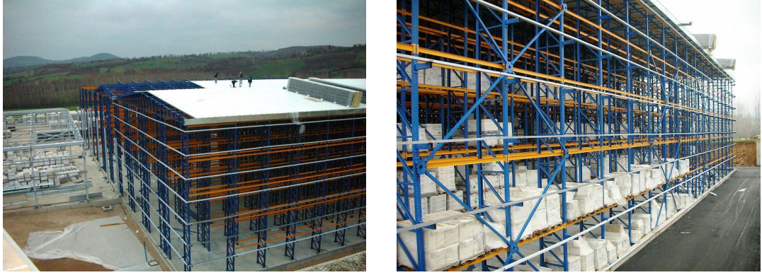
Şekil 3.11 : Giydirme raf sistemleri örneği (Hopbaoglu, 2009).
