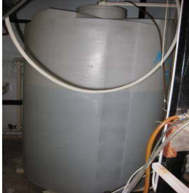
Şekil 3.11 : 10 tonluk tanklardan suyun basıldığı 1,5 tonluk ham su tankı
