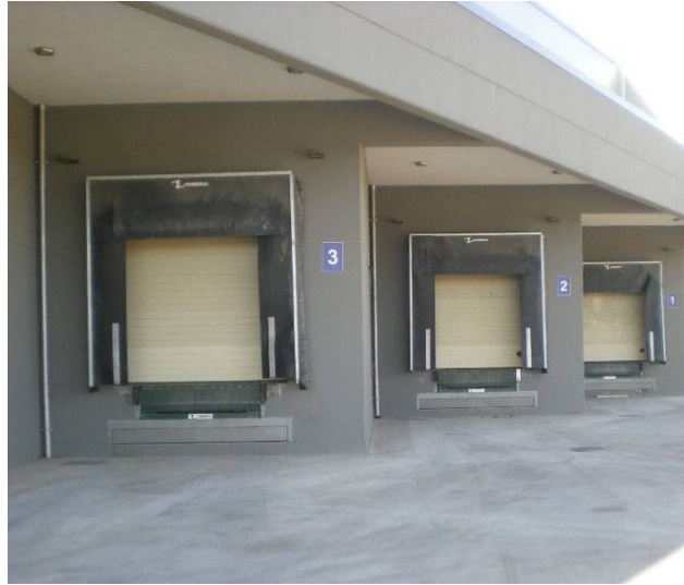
Şekil 6.19 : 45 derece açılı rampa ağızları.
