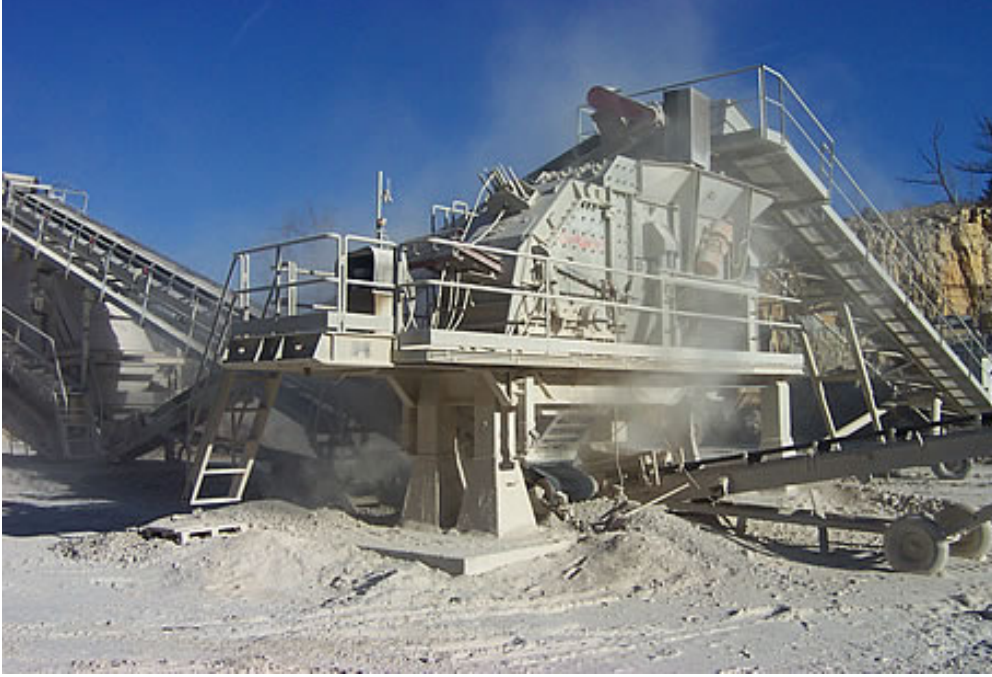
Şekil 4.6 : Geri kazanım tesisi çalışırken.
