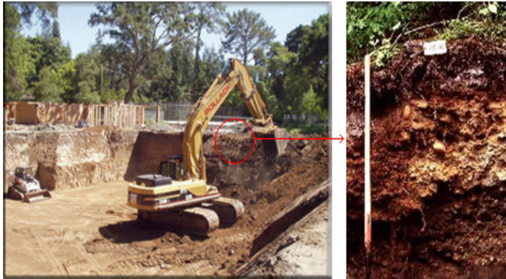
Şekil 2.1 : Hafriyat kazı çalışması ve bitkisel toprak kesiti.
