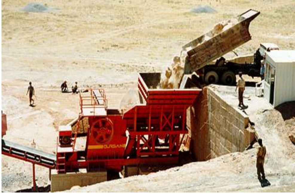
Şekil 2.3 : Geri kazanım tesisinde kırma-öğütme makinesi yükleme hunisi.
