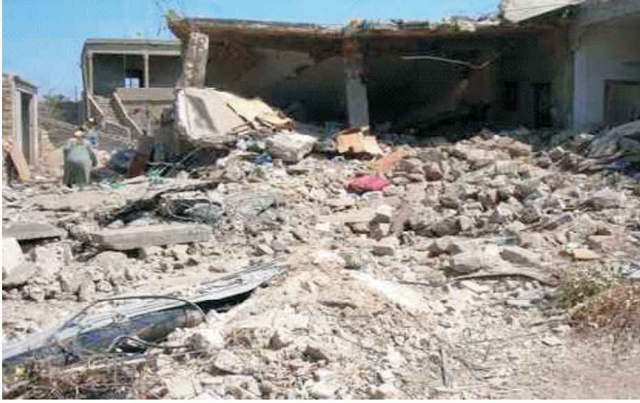
Şekil 2.2 : Yıkıntı atığı oluşumu.
