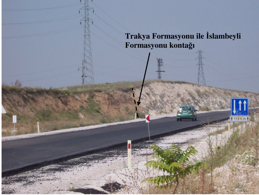
Foto 3.16: Trakya Formasyonu ile İslambeyli Formasyonu kontađı.
