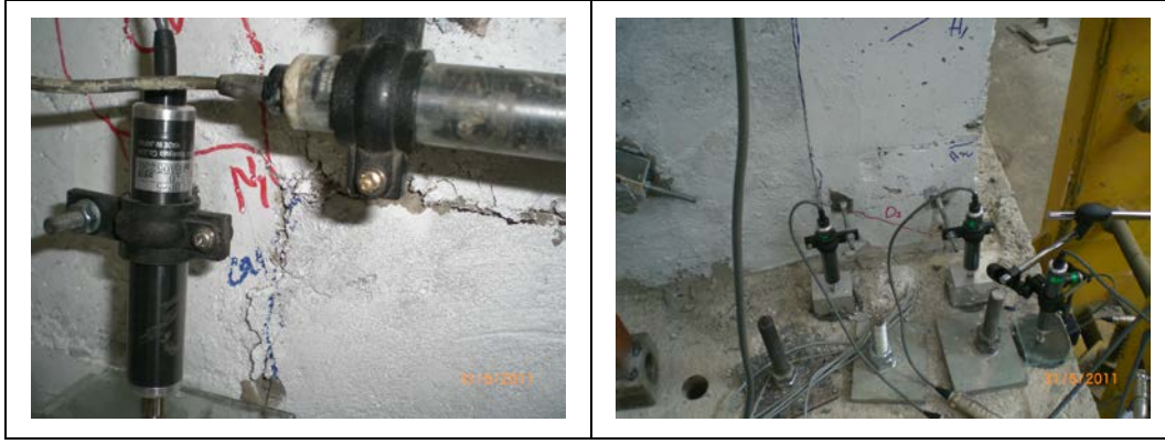
Şekil 3.54 : 9. çevrim sırasında oluşan çatlaklar.
