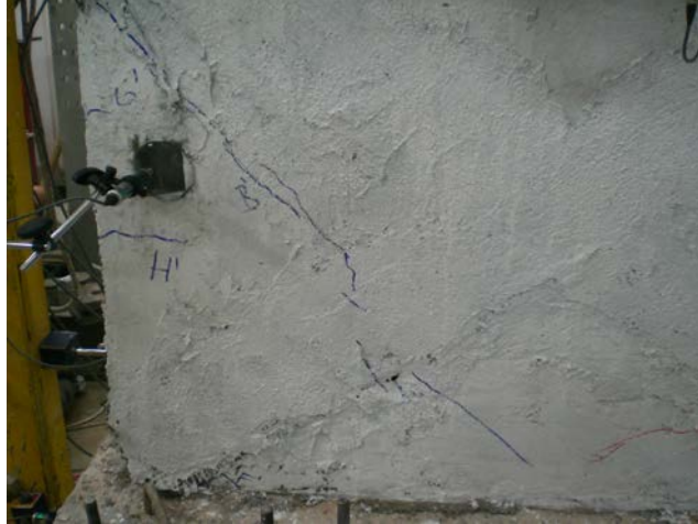
Şekil 3.96 : 8. çevrimde çatlığın ilerlemesi.
