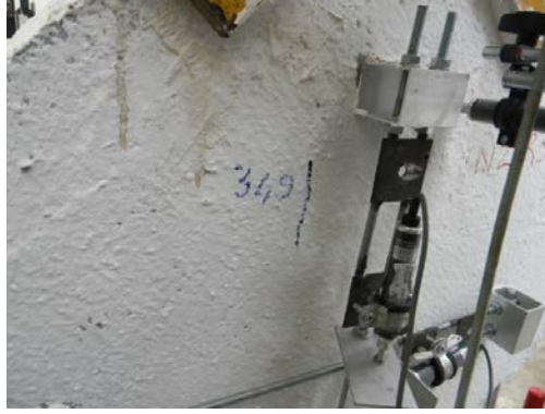
Şekil 2.30 : GN-2-1-2 numunesinde arka yüzde oluşan çatlak.
