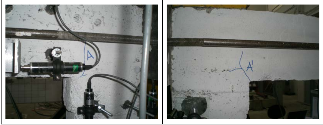
Şekil 3.41: 7. çevrimde ön ve arka yüzde oluşan çatlaklar.
