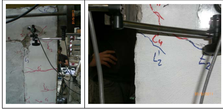
Şekil 3.52 : 7. çevrim sırasında oluşan çatlaklar.
