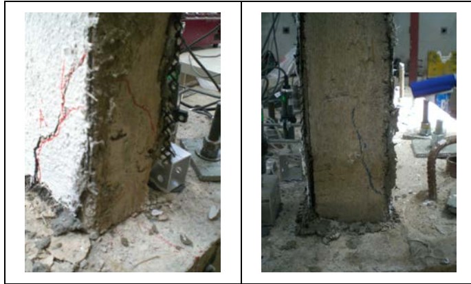
Şekil 3.103 : 10. çevrim sırasında oluşan çatlaklar.
