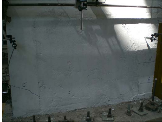
Şekil 3.60 : 4. çevrim sırasında oluşan çatlak.
