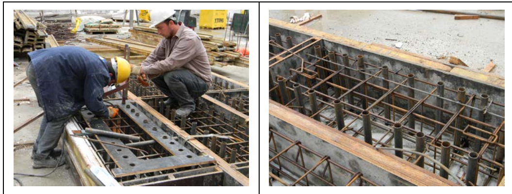
Şekil 3.5 : Bağlantı borularının temele yerleştirilmesi.
