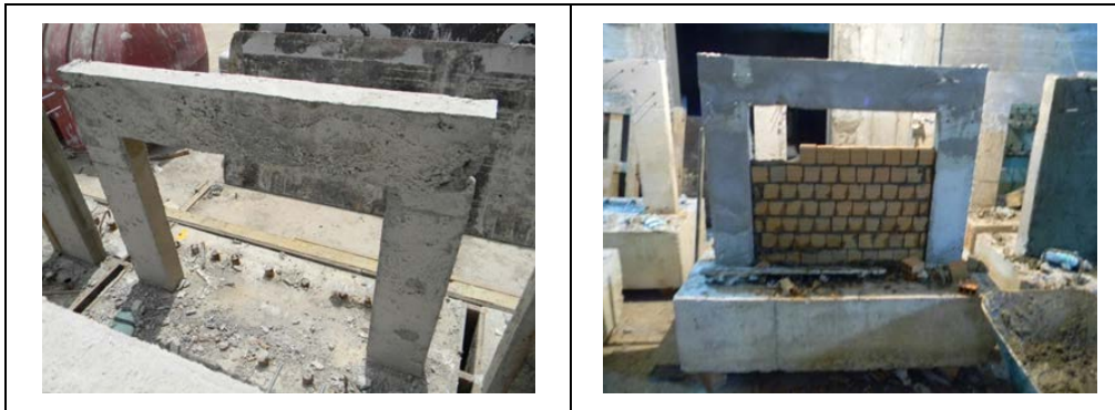
Şekil 3.11 : Betonarme çerçevelerin içine dolgu duvar örülmesi.
