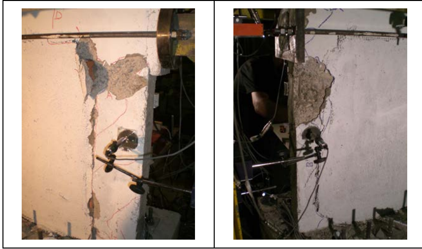
Şekil 3.88 : 11. çevrim sırasında oluşan hasarlar.
