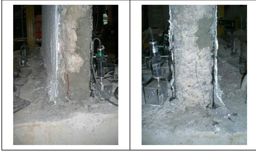
Şekil 3.74 : Kolon diplerinde oluşan hasarlar.
