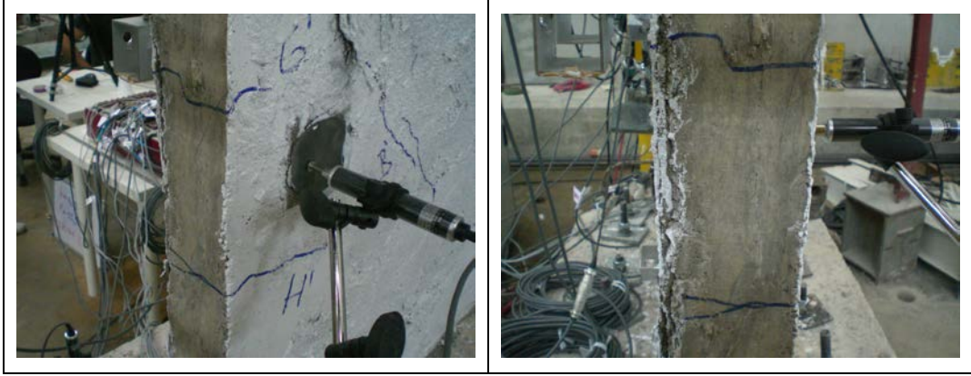
Şekil 3.95 : 7. çevrimde çekme sırasında arka yüzde oluşan çatlaklar.
