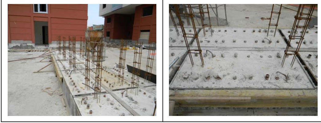
Şekil 3.6 : Kolon filizleri ve dökülmüş temel betonu.
