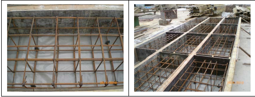
Şekil 3.4 : Donatıların temel kalıbına yerleştirilmesi.
