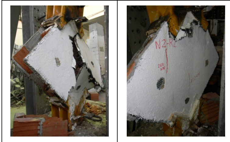
Şekil 2.33 : GN-2-1-3 numunesinin ön ve arka yüzlerinin göçme sonrası durumu.
