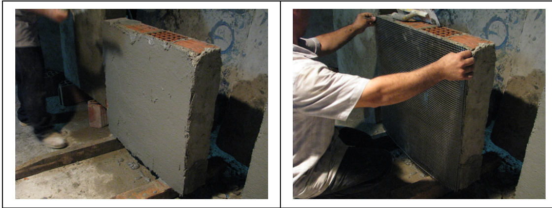
Şekil 2.5 : ıslatılmış yüzeye harcın sürülmesi ve karbon lifli ağın yerleşimi
