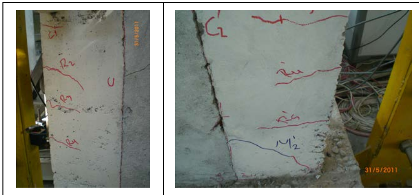
Şekil 3.56 : 11. çevrim sırasında oluşan çatlaklar.
