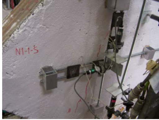
Şekil 2.23 : GN-1-1-1 numunesinin arka yüzünde oluşan a ve b çatlağı.
