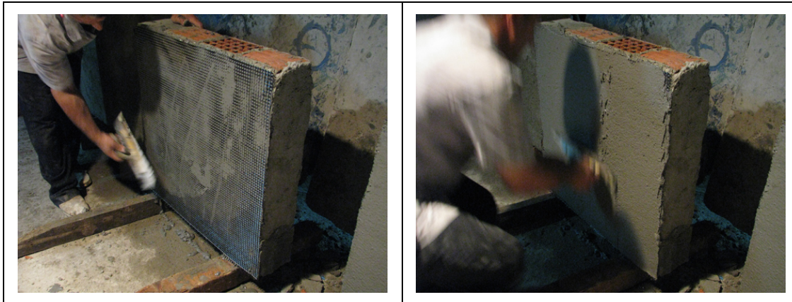
Şekil 2.6 : Ağın harcın içine iyice yerleştirilmesi ve üzerinin kapatılması.
