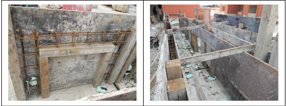
Şekil 3.9 : Kalıpların hazırlanması.
