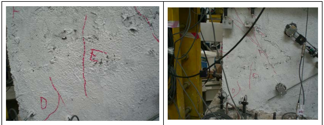
Şekil 3.92 : 6. çevrimde itme sırasında ön yüzde oluşan çatlaklar.
