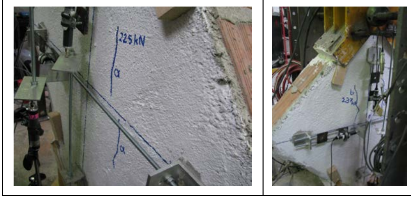
Şekil 2.18 : KN-1 numunesinin arka yüzünde oluşan a ve b çatlakları.
