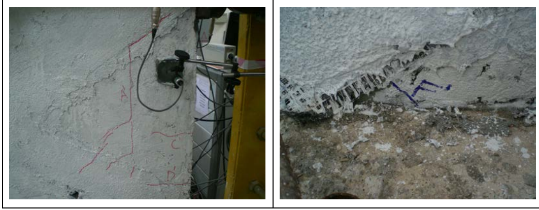
Şekil 3.93 : 6. çevrimde itme sırasında arka yüzde oluşan çatlaklar.
