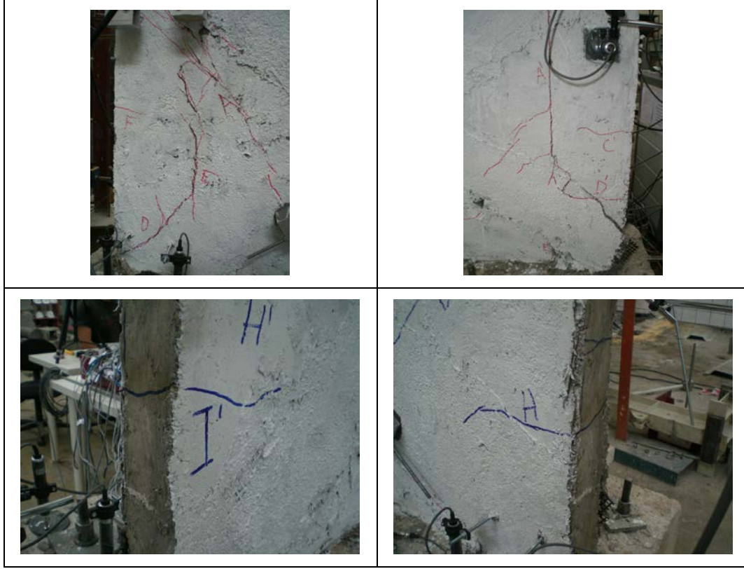
Şekil 3.97 : 9.çevrim sırasında oluşan çatlaklar.
