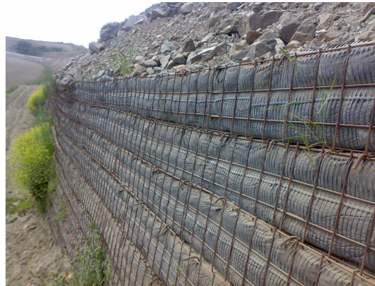
Şekil 5.8: Bohçalama sistem duvar görünüşü.
