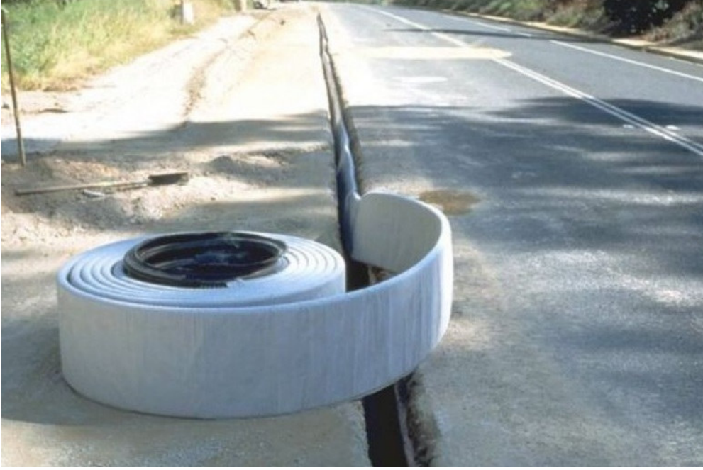
Şekil 4.54: Yol kenarına geokompozit panel dren uygulaması [48].
