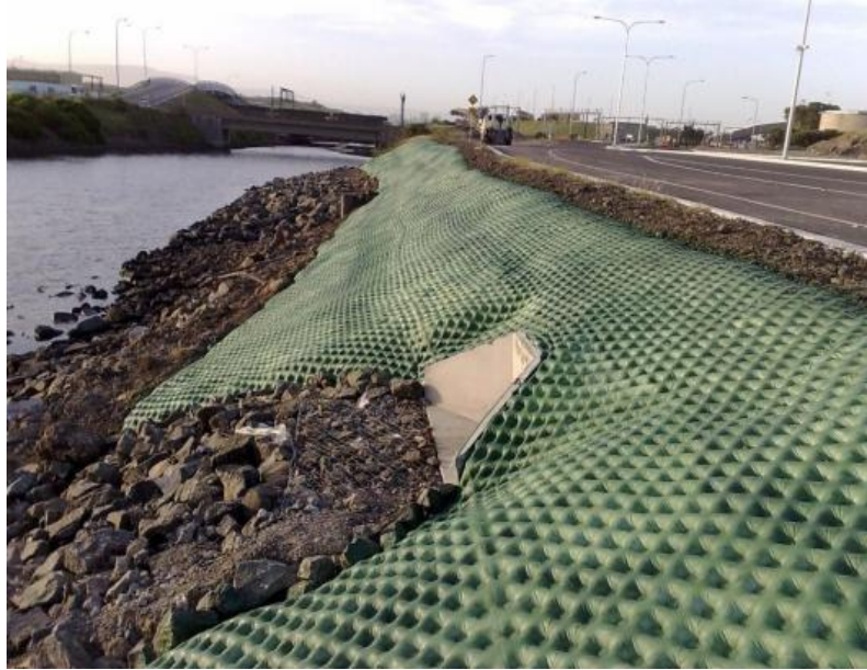
Şekil 4.64: Filtre şilte uygulaması, Port Kembla (Avusturalya) [23].
