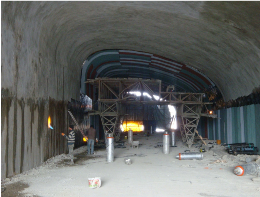
Şekil 5.6: Hasdal Kavşağı TEM Geçiş Tüneli yalıtım uygulaması.
