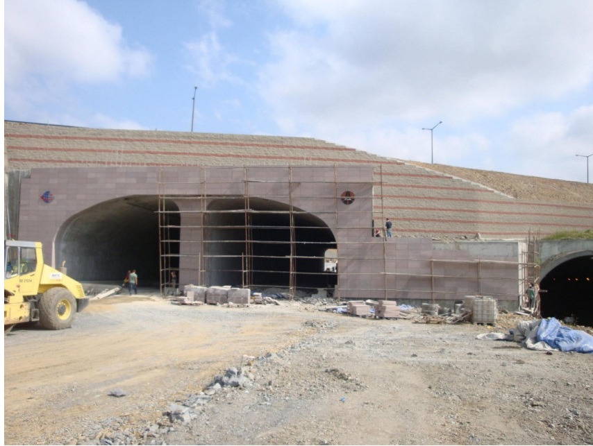
řekil 5.4: Hasdal Kavřaęı TEM Geçiş Tüneli Çıkıř Portalı geogrid donatılı prefabrik bloklı duvar.
