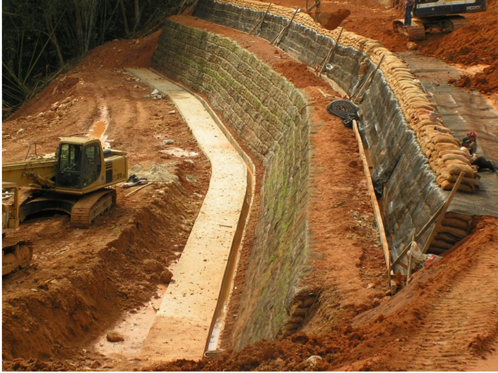
Şekil 4.30: Bohçalama sistem örneği, Ranong-Pato Yolu (Km:8), Ranong, Tayland [24].
