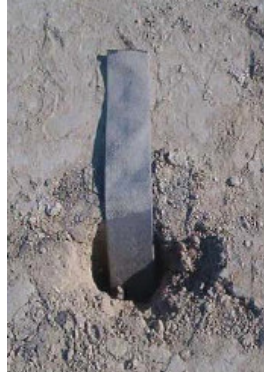
Şekil 4.7: Zemine yerleştirilmiş düşey bant dren [33].
