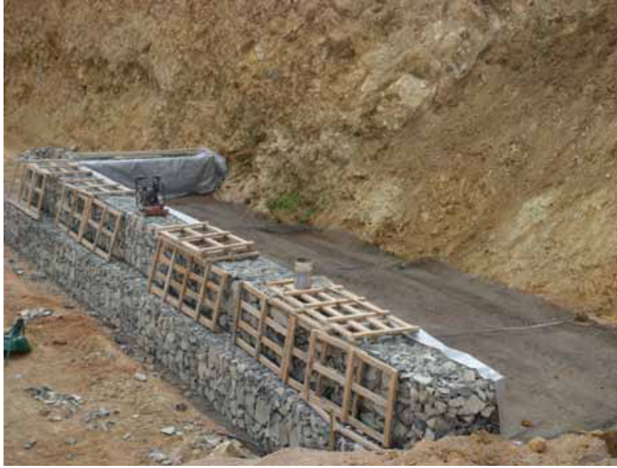
Şekil 4.33: Geogrid donatılı gabion duvar örneği [43].
