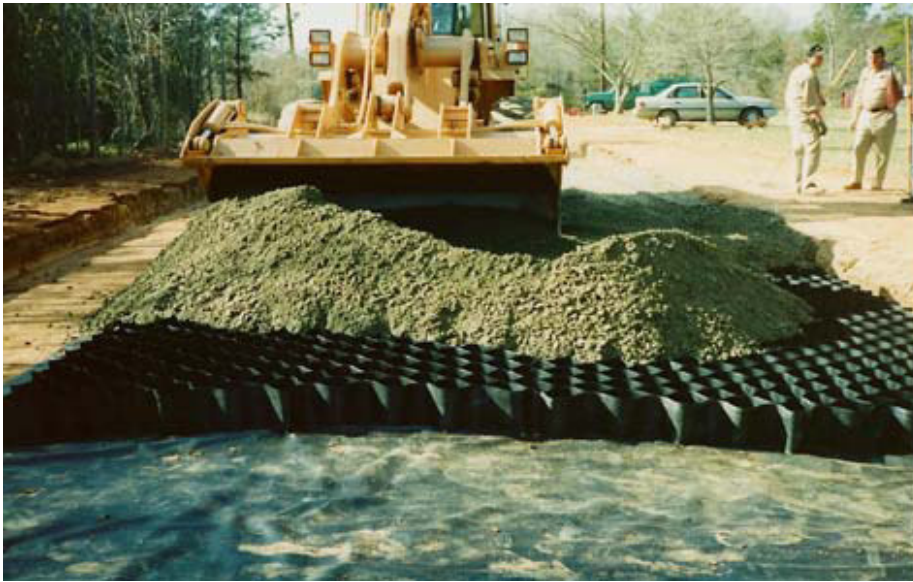
Şekil 4.21: Dolgu tabanına geohücre uygulaması [27].
