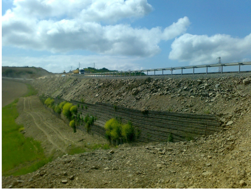
Şekil 5.12: Yüksek dolguda bohçalama sistemli duvar.
