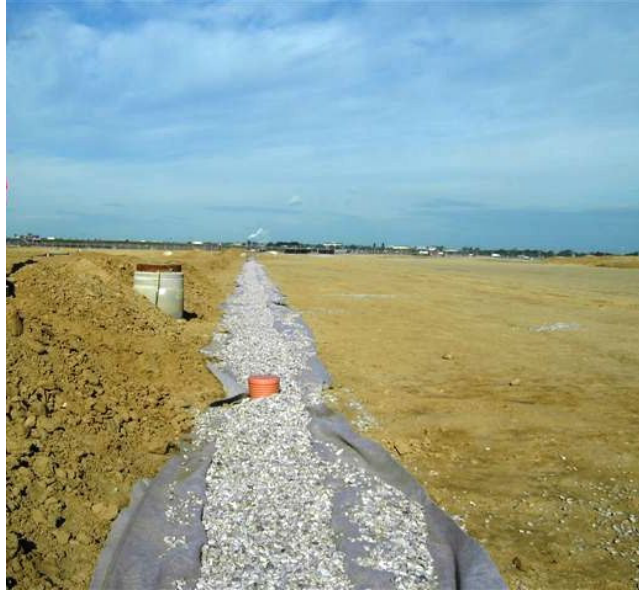
Şekil 4.50: Geotekstil sarımlı yerlatı drenaj yapısı [18].
