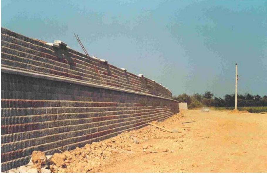
Şekil 5.13: Manavgat Köprüsü yaklaşım dolgusunda geosentetik donatılı istinat duvarı [11].
