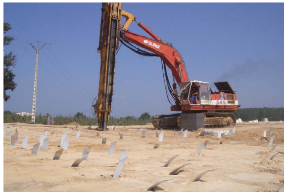
Şekil 4.8: Düşey bant dren uygulamasından bir örnek [33].
