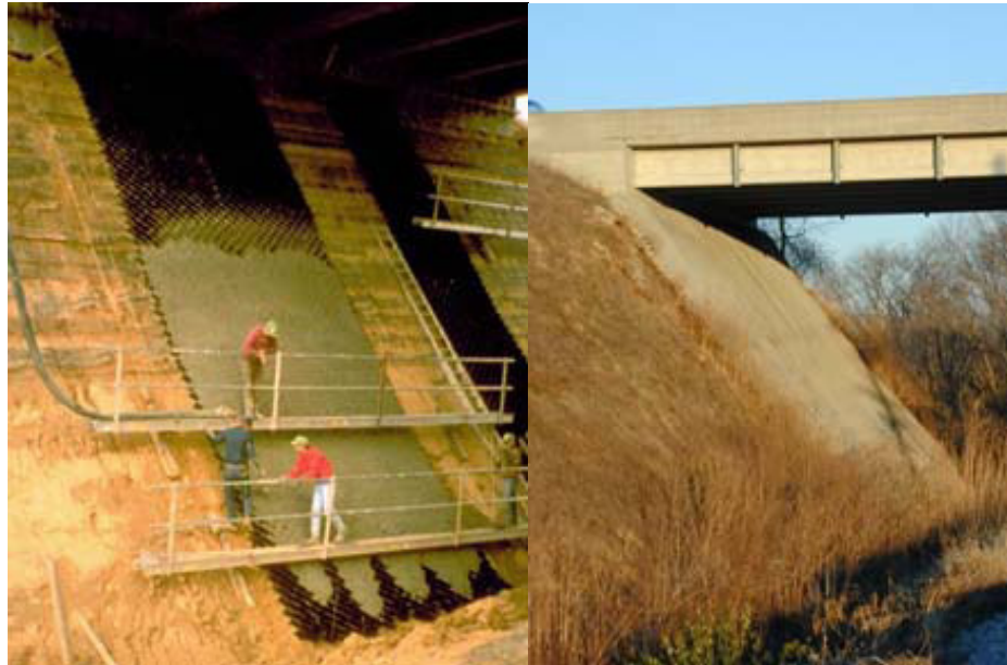
Şekil 4.79: Köprü altında şev koruma amaçlı betonla doldurulmuş geohücre uygulaması [21].
