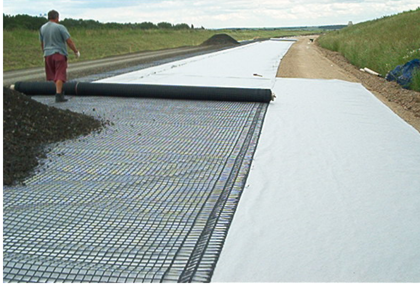
Şekil 4.39: Temel altında geogrid kullanılması [18].
