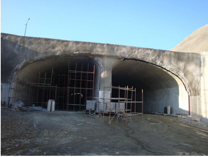
Şekil 5.5: Hasdal Kavşağı TEM Geçiş Tüneli Giriş Portalı.
