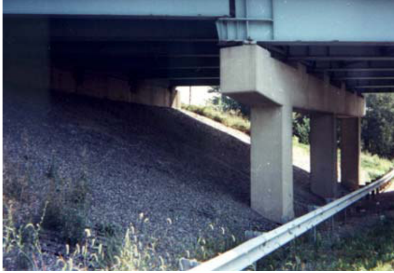
Şekil 4.80: Köprü altında kırmataşla doldurulmuş geohücre uygulaması [21].
