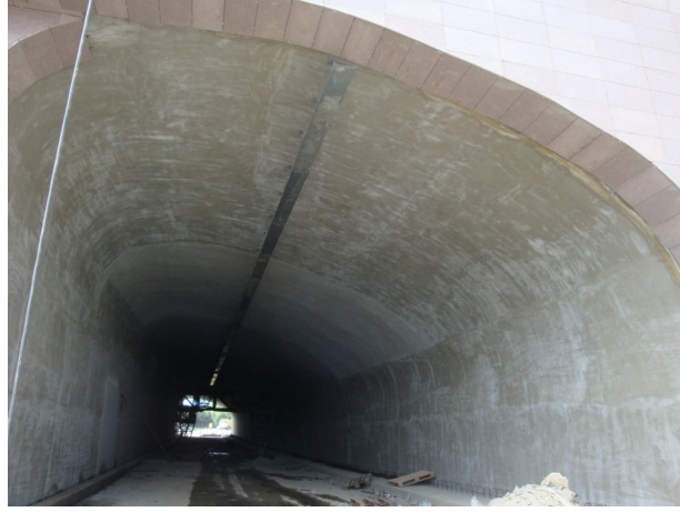
Şekil 5.7: Tünel iç yalıtımı tamamlanmış hali.
