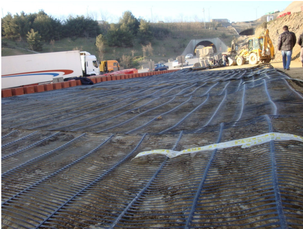
Şekil 5.2: Tünel yaklaşım dolgusunda geogrid donatılarının serilmesi.
