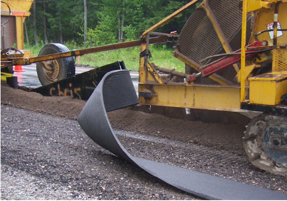
Şekil 4.55: Yol kenarına geokompozit panel dren yerleştirilmesi [32].
