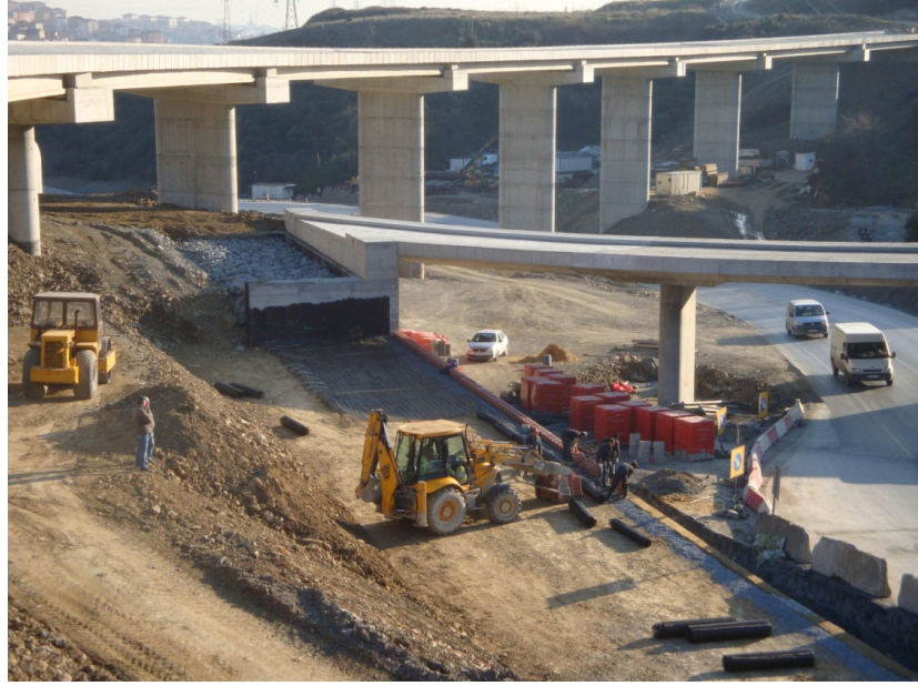
řekil 5.3: TEM Geçiş Tüneli Giriř Portalı önu yaklaşım dolguları geogrid donatılı duvar yapımı.
