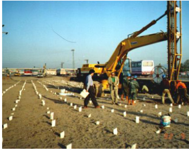
Şekil 4.6: İzmit bölünmüş yolu düşey bant dren uygulaması [31].
