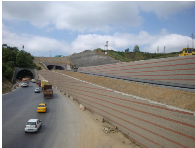
Şekil 5.1: TEM Geçiş Tüneli Giriş Portalı önü yaklaşım dolguları geogrid donatılı prefabrik bloklu duvar.
