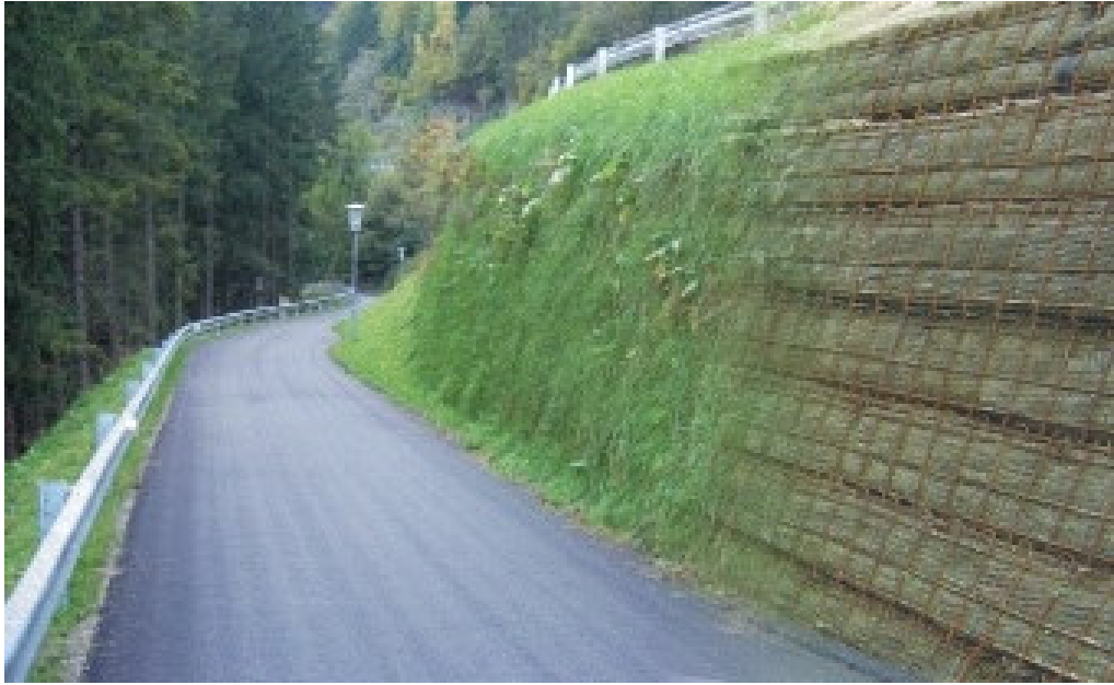
Şekil 4.82: Bitki örtülü dik şev uygulaması [18].
