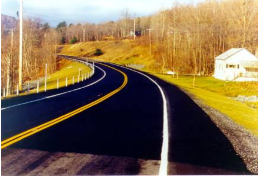
Şekil 4.20: İmalatın tamamlanmış hali (Route 23A, Jewett County, New York) [22].
