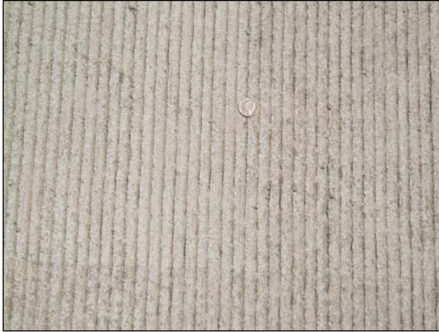
Şekil 6.8 : Boyuna doğrultuda ince kanallar açma yönteminin uygulanmasıyla elde edilmiş beton yol yüzeyi [30].
