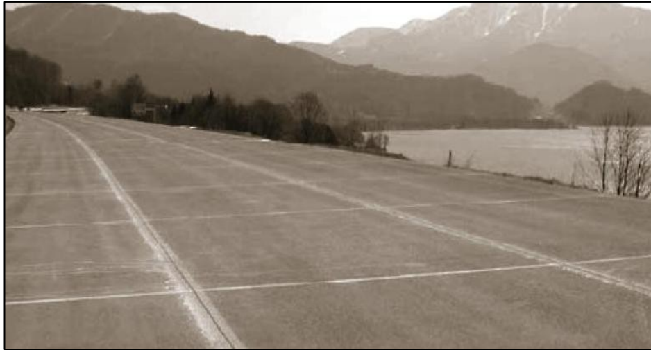
Şekil 3.16 : 50 yıl hizmet verdikten sonra 2003 yılında yeniden yapılan Avusturya'daki beton kaplamalı A1 otoyolu [23].
