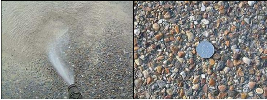
Şekil 6.15 : Yüzeydeki harcın yikanarak çıkarılması (solda) ve elde edilmiş soyulmuş agregalı beton yol yüzeyi [30].
