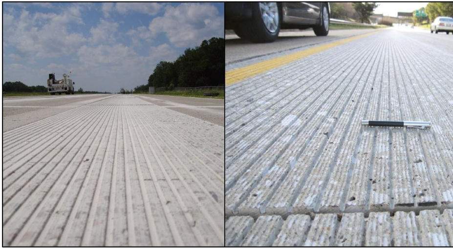
Şekil 6.12 : Boyuna doğrultuda uygulanmış yivlendirme yöntemi ile elde edilmiş beton yol yüzeyleri [43].
