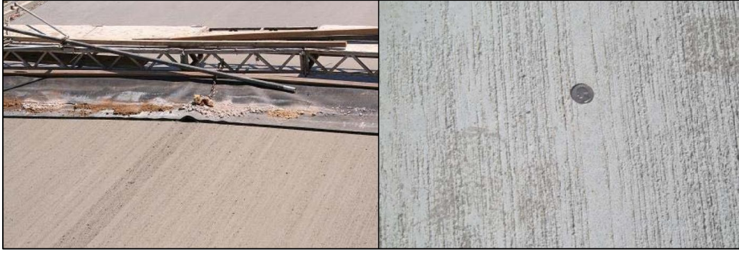
Şekil 6.1 : Suni çim halı ile yüzey pürüzlendirilmesi (solda) ve suni çim halı ile pürüzlendirilmiş beton yol yüzeyinin görüntüsü (sağda) [30].
