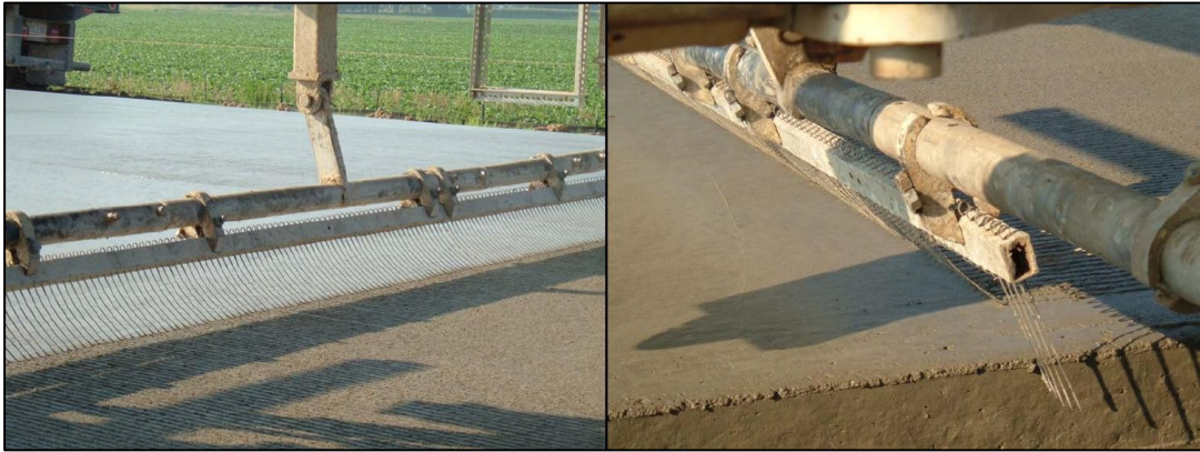
Şekil 6.5 : Yüzeyde ince kanallar açma yönteminin uygulanışı [39].
