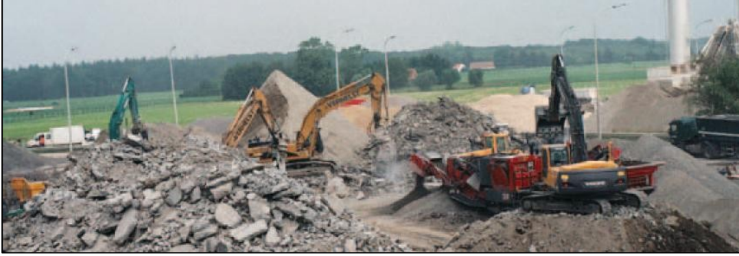
Şekil 3.23 : Silindirle sıkıştırılan beton yol temelinde ve yeni beton kaplamada agrega olarak kullanılmaya yönelik eski beton yolun geri dönüşümü [27].
