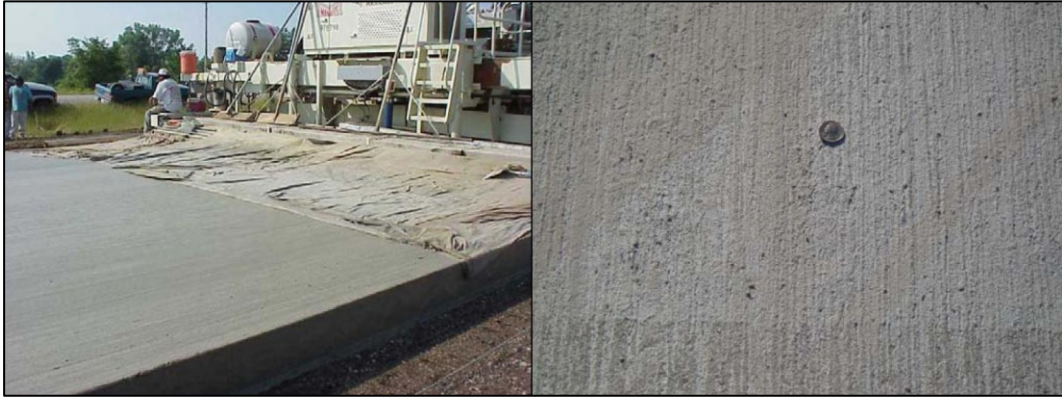
Şekil 6.2 : Çuval bezi ile yüzey pürüzlendirilmesi (solda) ve çuval bezi ile pürüzlendirilmiş beton yol yüzeyinin görüntüsü (sağda) [30].
