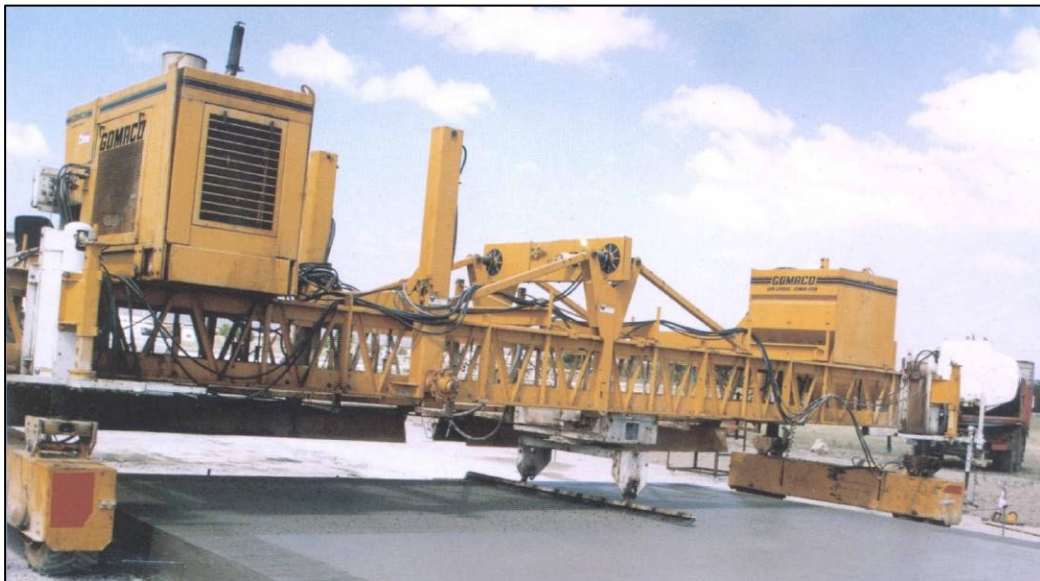
Şekil 6.3 : Afyonkarahisar'da yapılan beton yolun yüzeyinin enine yönde fırça sürüklenmesi yöntemi ile pürüzlendirilmesi [8].
