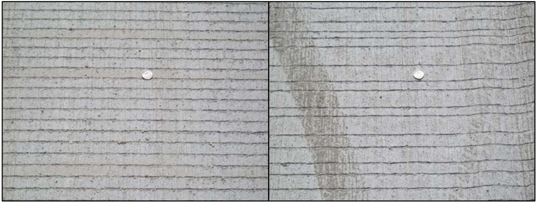
Şekil 6.6 : Enine doğrultuda ince kanallar açma yönteminin üniform (solda) ve rasgele (sağda) aralıklarda uygulanmasıyla pürüzlendirilmiş beton yol yüzeyinin görüntüsü [30].
