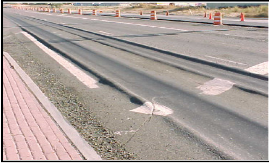
Şekil 4.4: Tekerlek izi oluşumu ve oluklanma [11].
