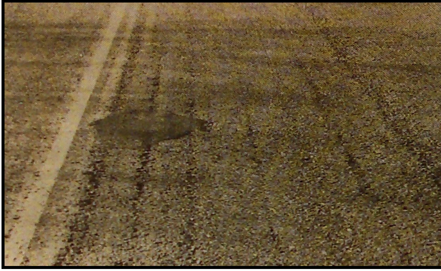
Şekil 4.52: Yüksek şiddette çizgisel agregat kaybı [1].
