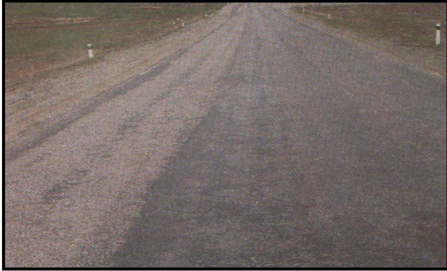
Şekil 4.49: Yüksek şiddette ayrışma, sökülme ve soyulma [1].
