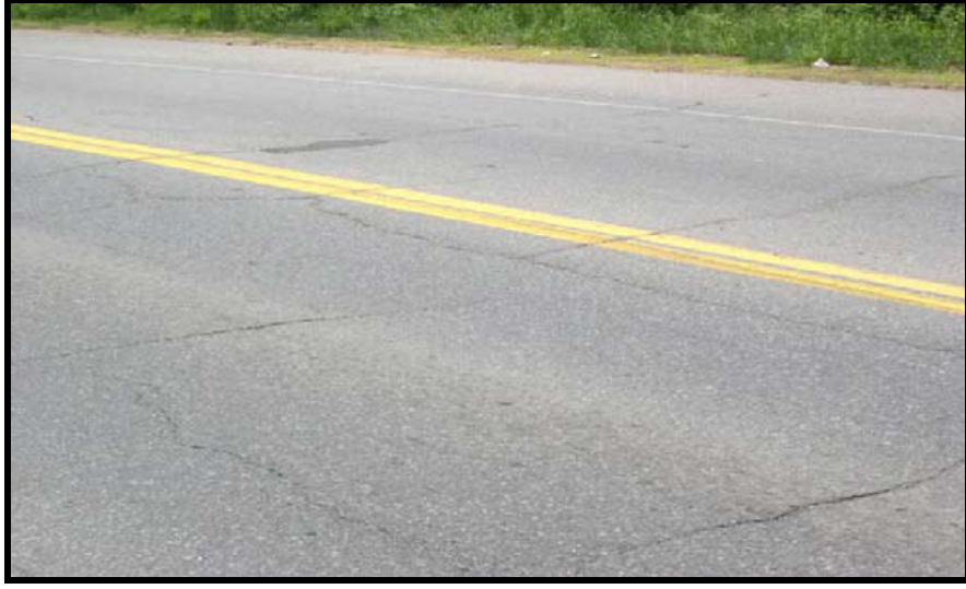
Şekil 4.5: Düşük şiddette tekerlek izi [12].
