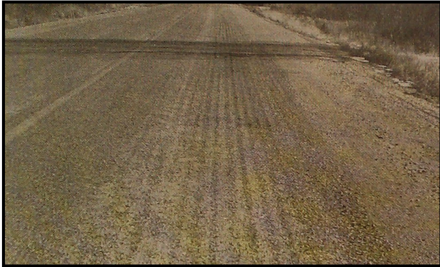
Şekil 4.51: Orta şiddette çizgisel agregâ kaybı [1].
