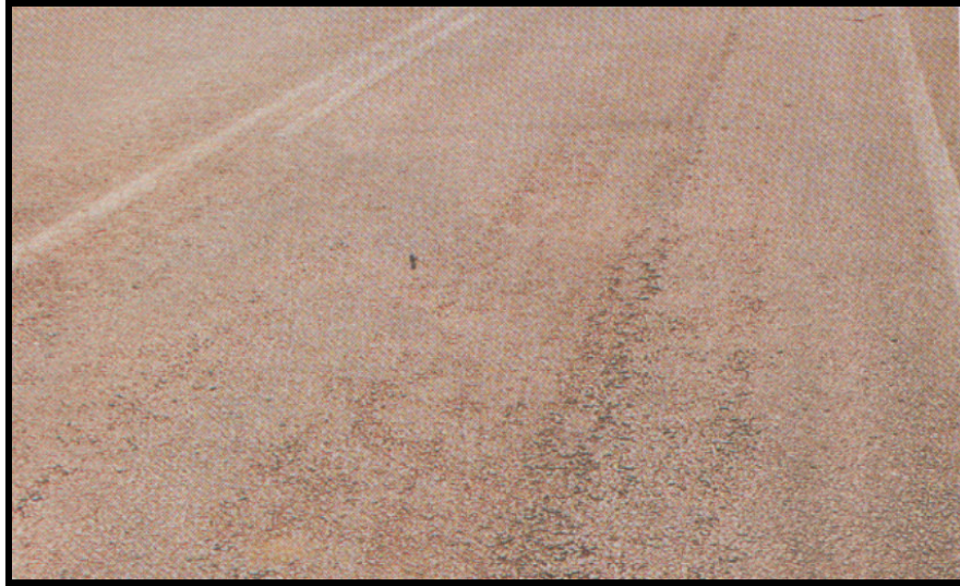
Şekil 4.47: Hafif şiddette ayrışma, sökülme ve soyulma [1].
