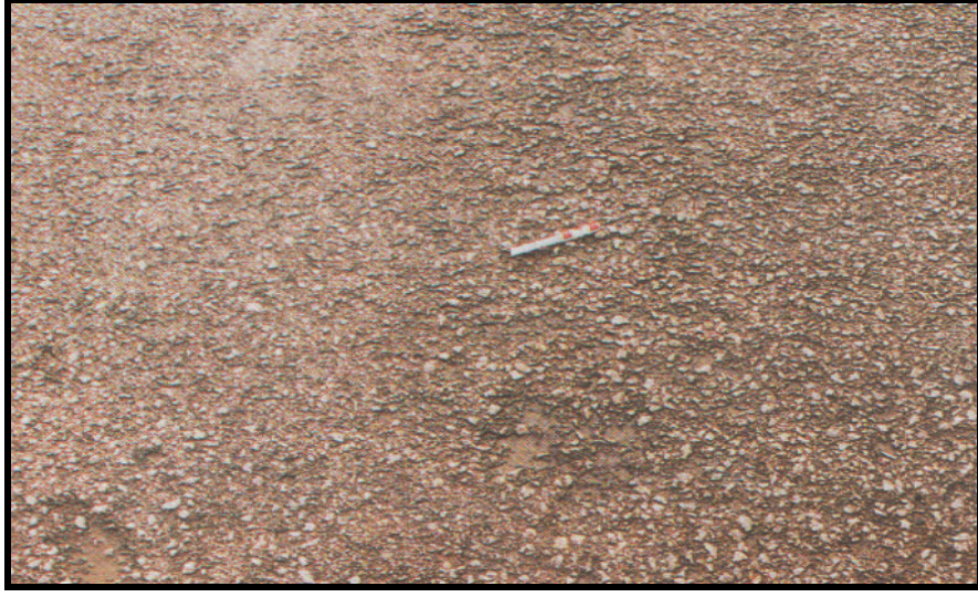
Şekil 4.48: Orta şiddette ayrışma, sökülme ve soyulma [1].
