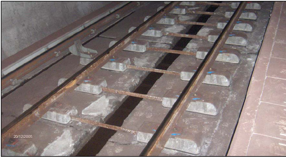
Şekil 2.15: İstanbul Metrosu Üstyapı Resimleri
