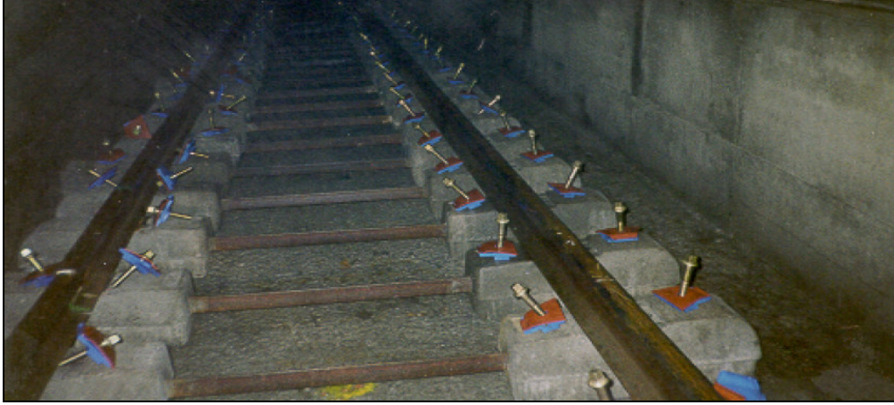
Şekil 2.14: İstanbul Metrosu Üstyapı Resimleri
