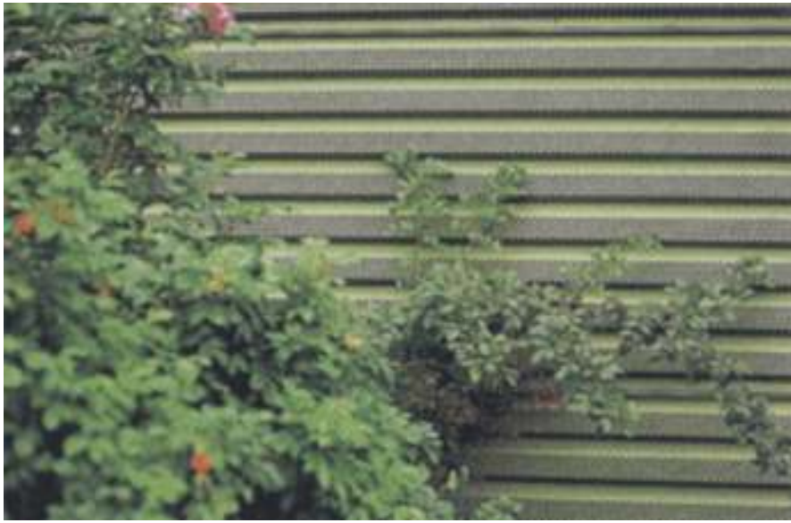
Şekil 4.5 Ön Yüzde 6 mm Çaplı Delikler Olan Profilli Metal Bariyer (Kotzen, English, 1999)
