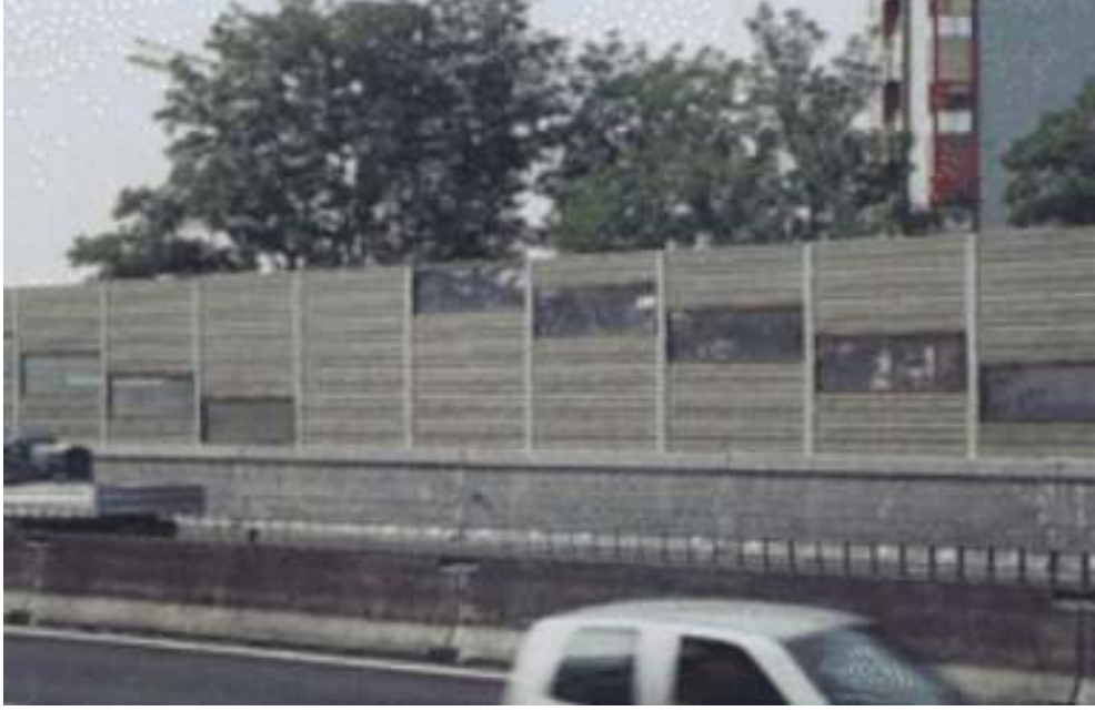
Şekil 4.6: New Jersey “Laghi” Duvarı Üzerine Monte Edilmiş Şeffaf Basamaklı Pencereleri Olan Ses Yutucu Özellikteki Alüminyum Bariyer (Kotzen, English, 1999)
