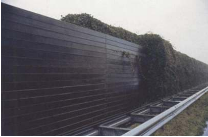
Şekil 4.4: Ahşap Bariyer ve Kutu Tipi Bariyerin Kesişim Noktası (Kotzen, English, 1999)
