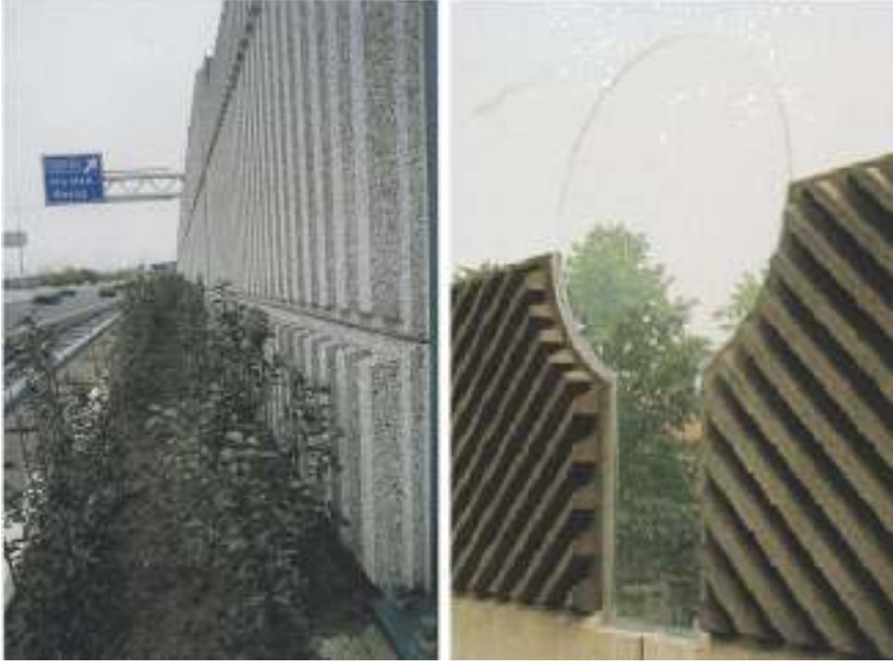
Şekil 4.10: Ahşap Lifli (Solda) Ve Tanecikli (Sağda) Malzemedan İmal Edilmiş, Değişik Formlardaki Beton Gürültü Perdeleri (Kotzen, English, 1999)
