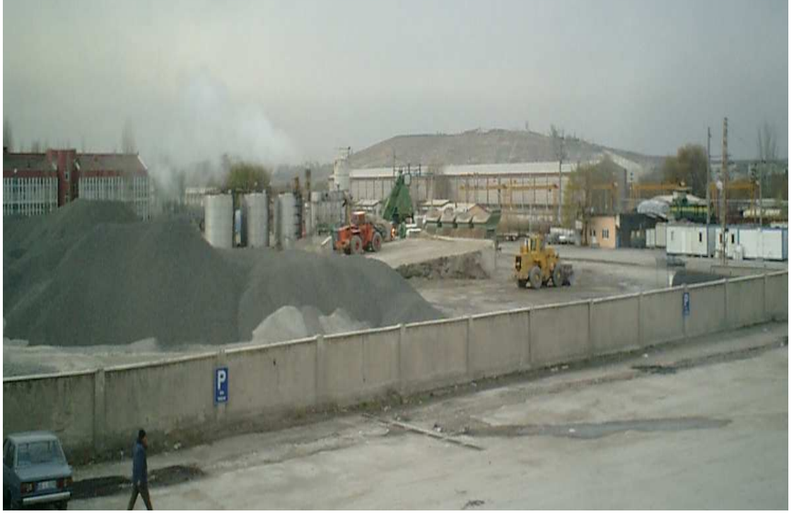
Şekil 2.6: Agreg a stok sahası (Karayolları 4. Bölge Müdürlüğü)
