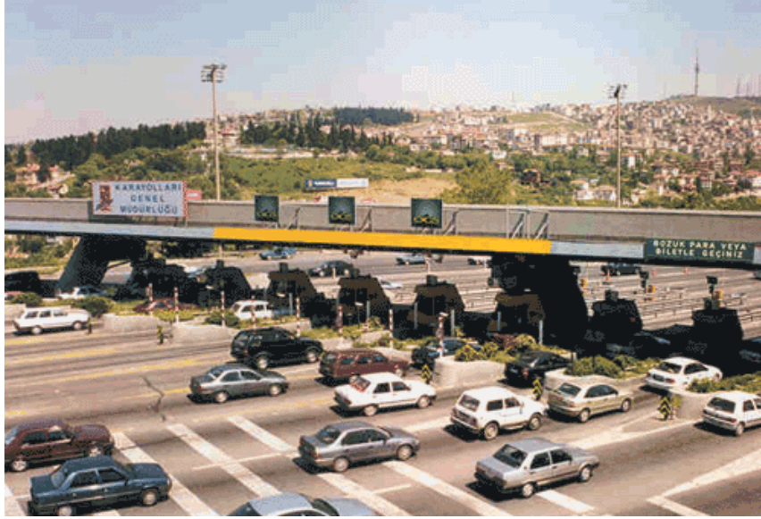
Şekil 3.7 : Boğaziçi Köprüsü'nde OGS gişeleri.
