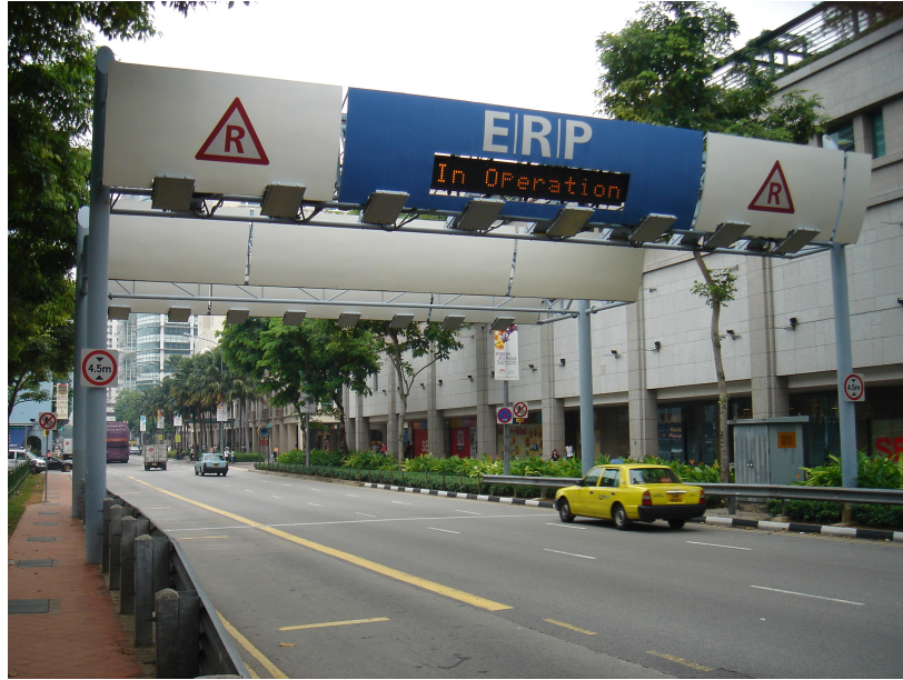
Şekil 3.8 : Singapur'daki elektronik tahsilât uygulamasında yol üstü antenleri.
