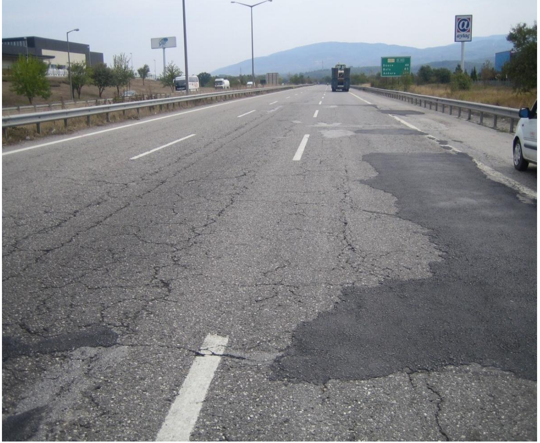
Şekil 6.27: T_{8.2} Eşdeğer standart dingil yükü değerlerinin yüksek olduğu kesimlerdeki bozulmalar
