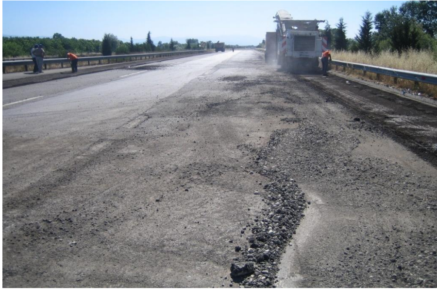
a) Onarım çalışmalarından bir görünüş
