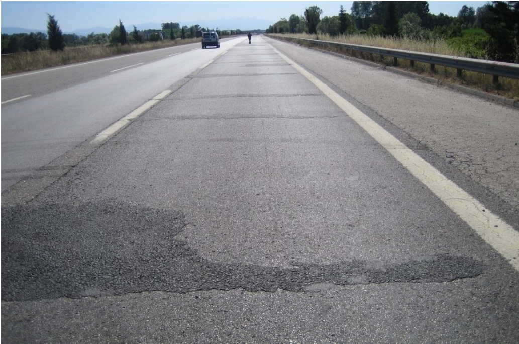
b) Sıcaklık deęişimlerinin neden olduęu bozulmalara ait dięer bir görünüş
