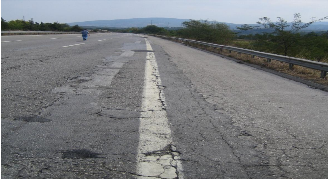
Şekil.6.26: T_{8.2} Eşdeğer standart dingil yükü değerlerinin yüksek olduğu kesimlerdeki bozulmalar
