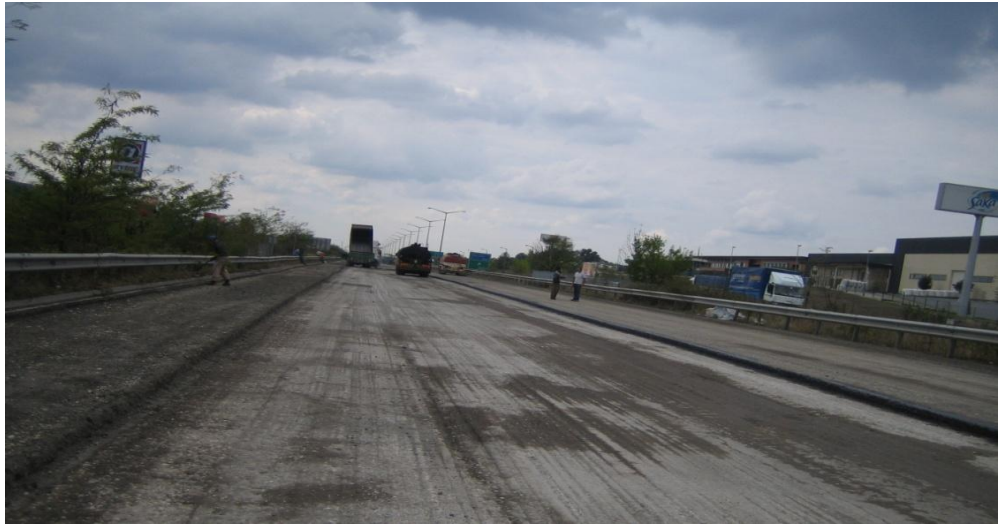
a) Onarım çalışmalarından bir görünüş
