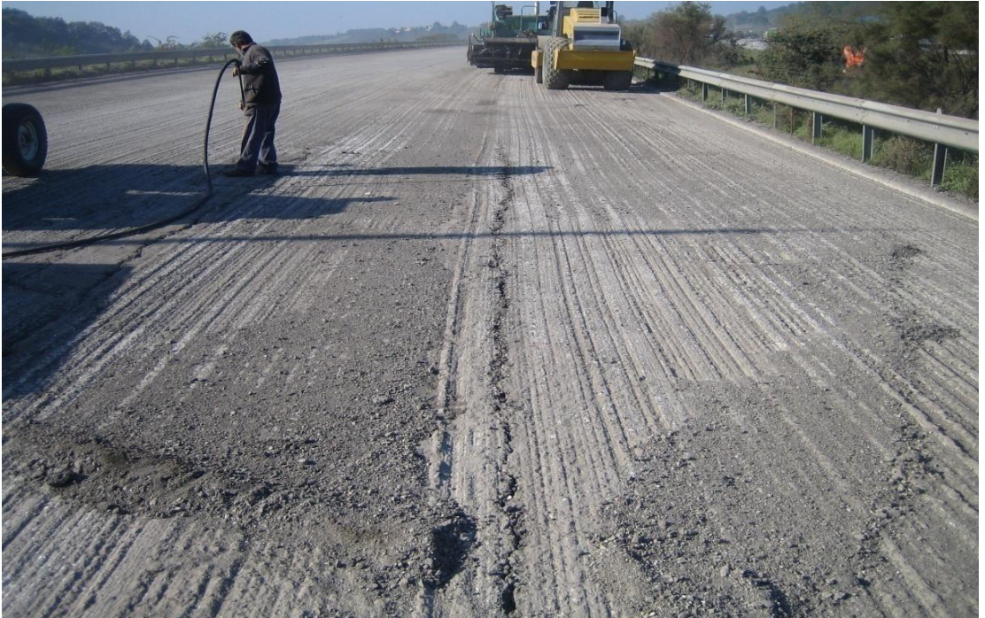
b) Onarım çalışmalardan bir görünüş
