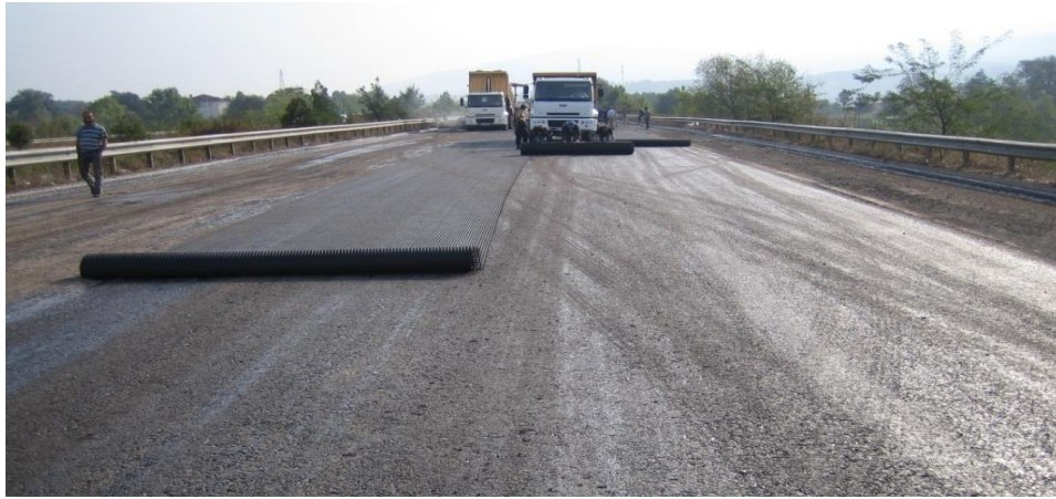
a) Onarım çalışmalarından bir görünüş
