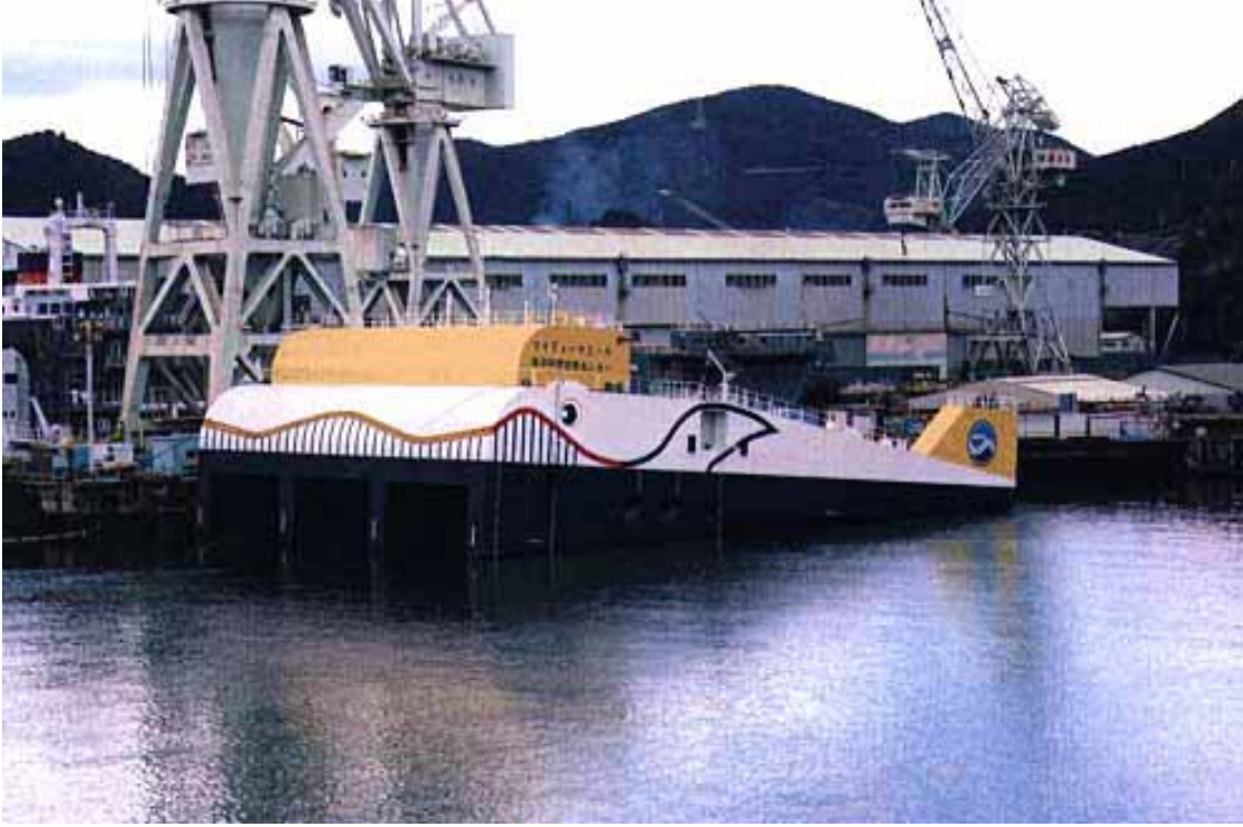
Şekil 1.12.2 Büyük balina (mighty whale) enerji dönüşüm sistemi prototipi suyun içinde
