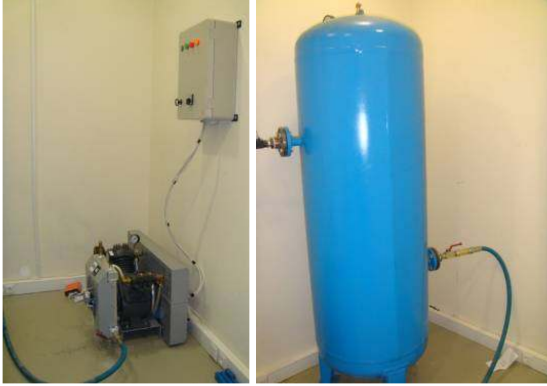
Şekil 3.14 : Kompresör ve yüksek basınç tankı.
