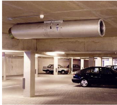
Şekil 5.24: Jetfanların otoparktaki kullanımı, v.d.Giesen ve diğ. (2010)’dan uyarlanmıştır.
