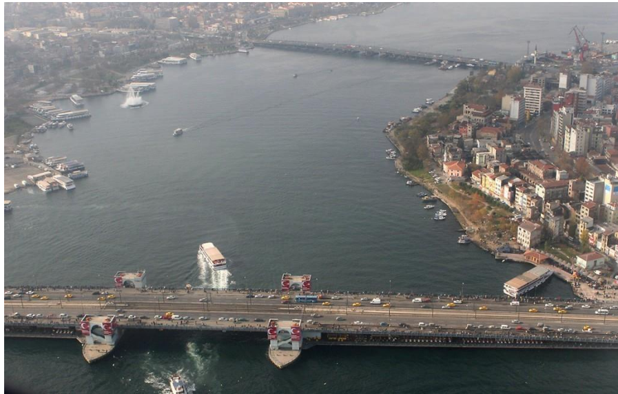
Şekil 5.1 : Çalışma alanının havadan görünümü (Url 14)
