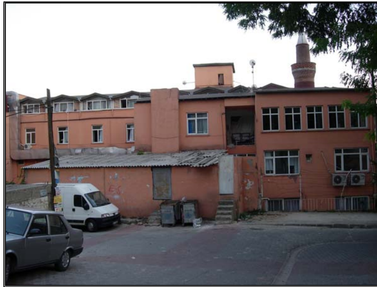
Şekil B.5 : İstinye Devlet Hastanesi Arka Cephesi
