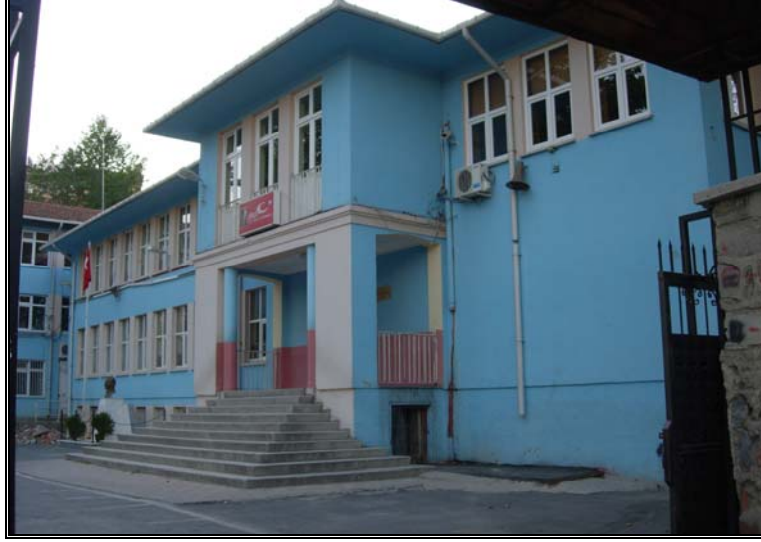
Şekil B.3 : Okul Binası
