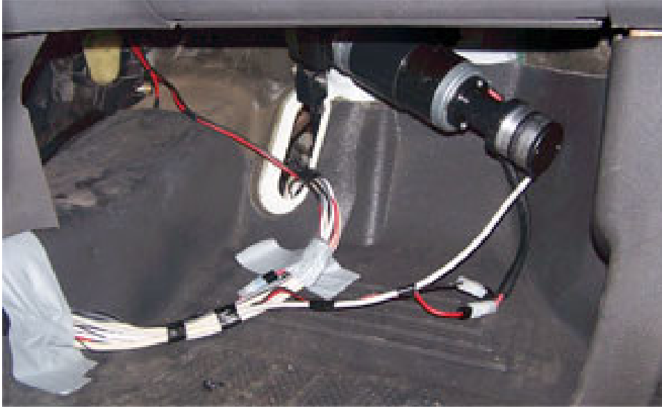
Şekil 5.10. Elektrik motoru ve takometrenin montajı
