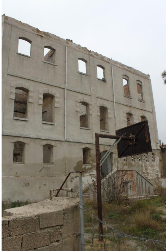
Şekil C.56: Güneydoğu Cephesi (Arka Cephe)
