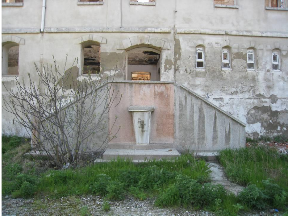
Şekil C.17: Yapının arka cephesini, bu cephedeki merdiveni ve önündeki heykel büstünü gösterir fotoğraf
