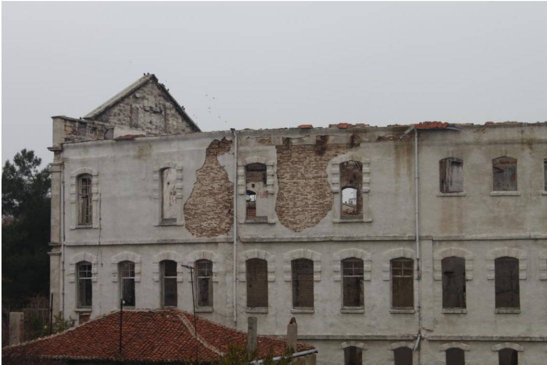
Şekil C.54: Güneybatı Cephesi (Yan Cephe)
