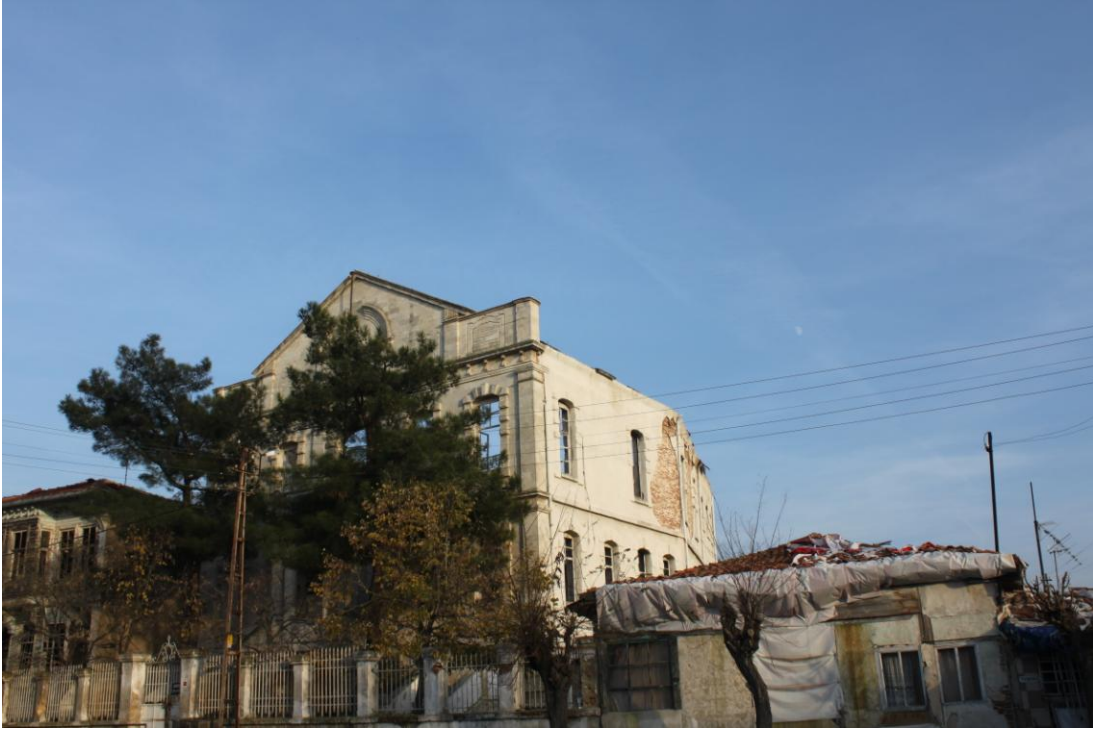
Şekil C.50: Kuzeybatı (Giriş) Cephesi
