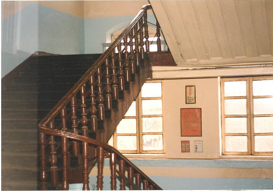
Şekil D.4: Yapının ahşap merdiven sistemi
