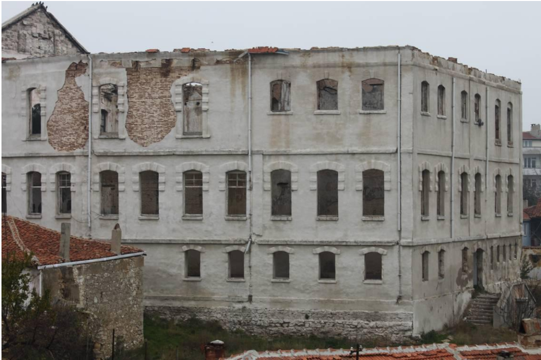
Şekil C.19: Yapının güneybatı cephesinin bütünü gösterir fotoğraf
