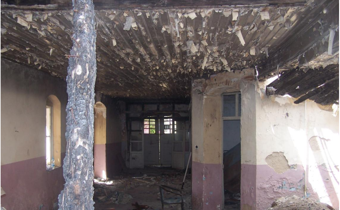
Şekil D.8: Zemin kat genel görünüm
