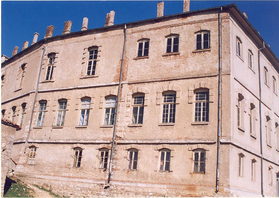
Şekil D.2: Yapının güneydoğu cephesi
