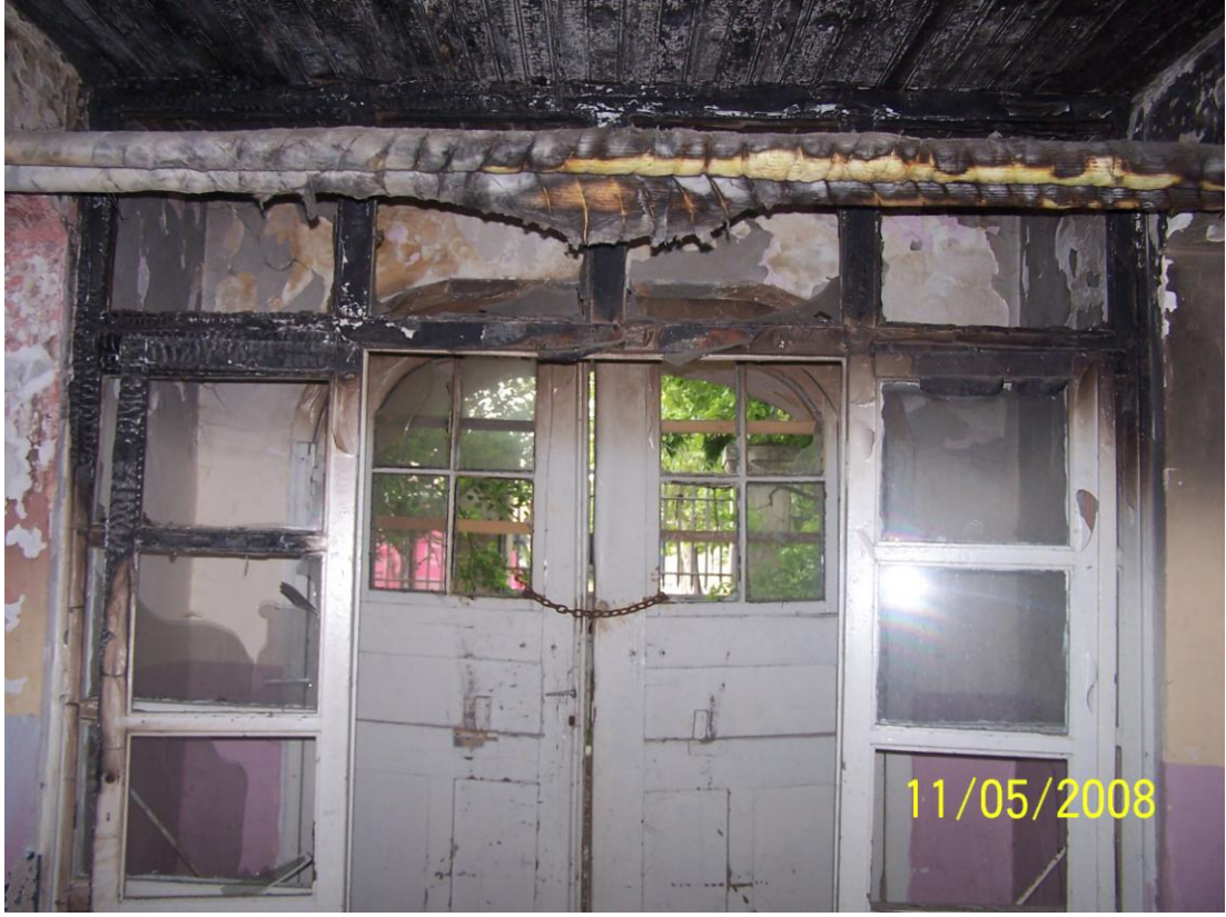
Şekil D.7: Yapının özgün zemin kat kapısı
