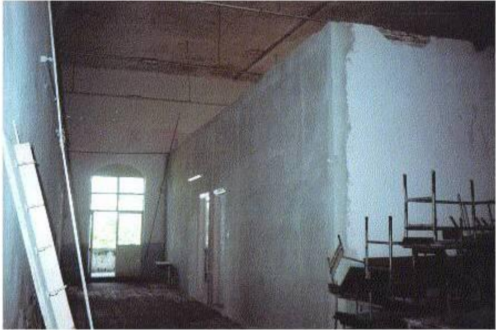
Şekil D.12: İkinci kat genel görünüm
