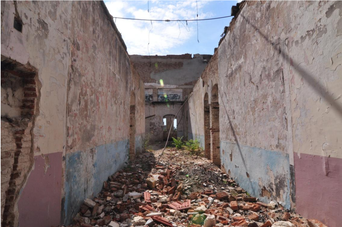
Şekil C.45: 1K02 Mekanı- Koridor'dan Merkezi Mekana Bakış
