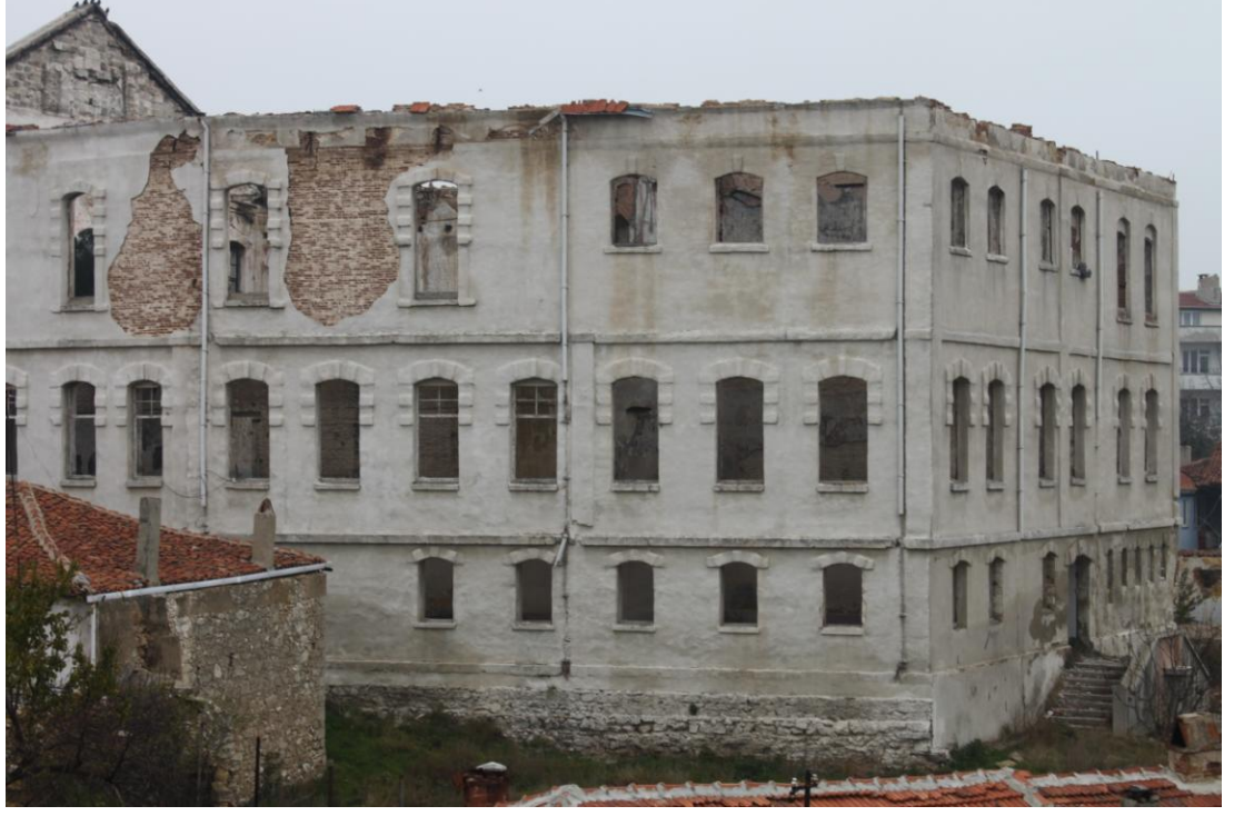
Şekil C.55: Güneybatı Cephesi- Moloz Dolgu Görünümü
