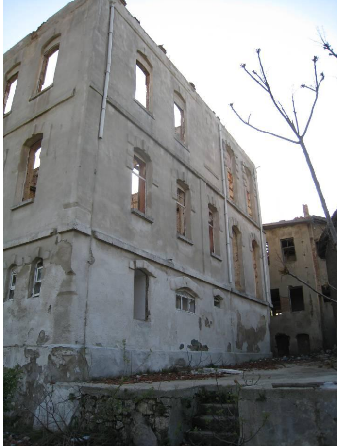
Şekil C.16: Yapının kuzeydoğu cephesini ve bu yöndeki beton platformu gösterir fotoğraf
