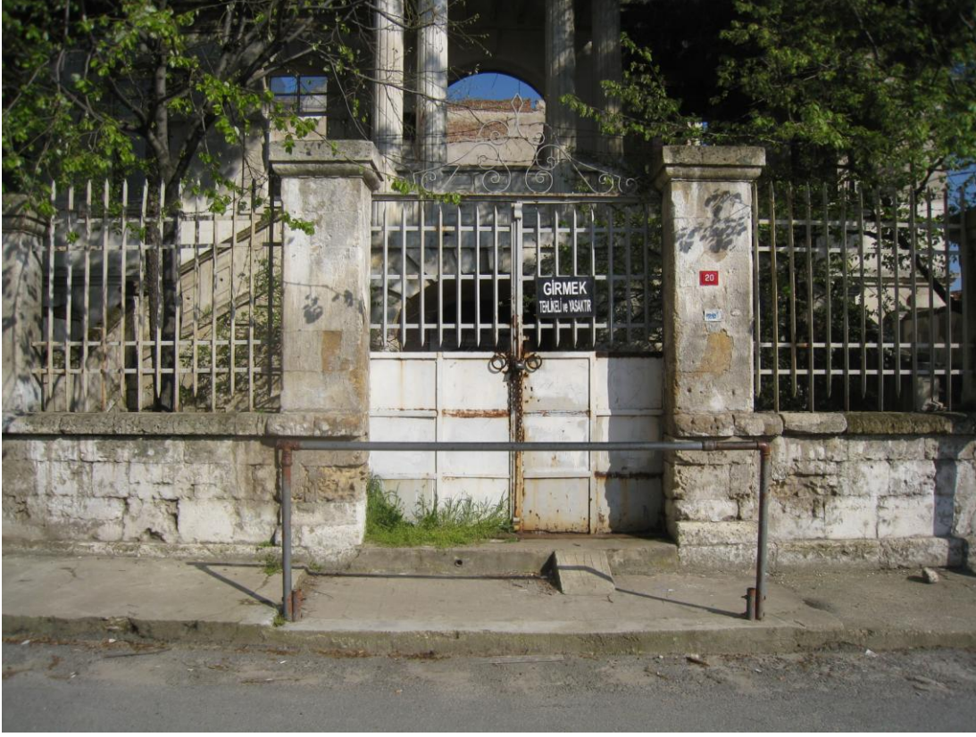
Şekil C.53: Ön Bahçe Duvarı- Bahçe Giriş Kapısı
