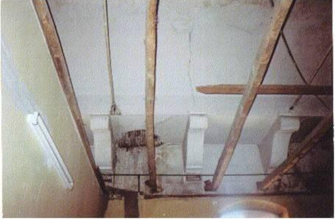
Şekil D.11: Bağdadi fûruş dizisi ve muhdes ahşap elemanlara bakış
