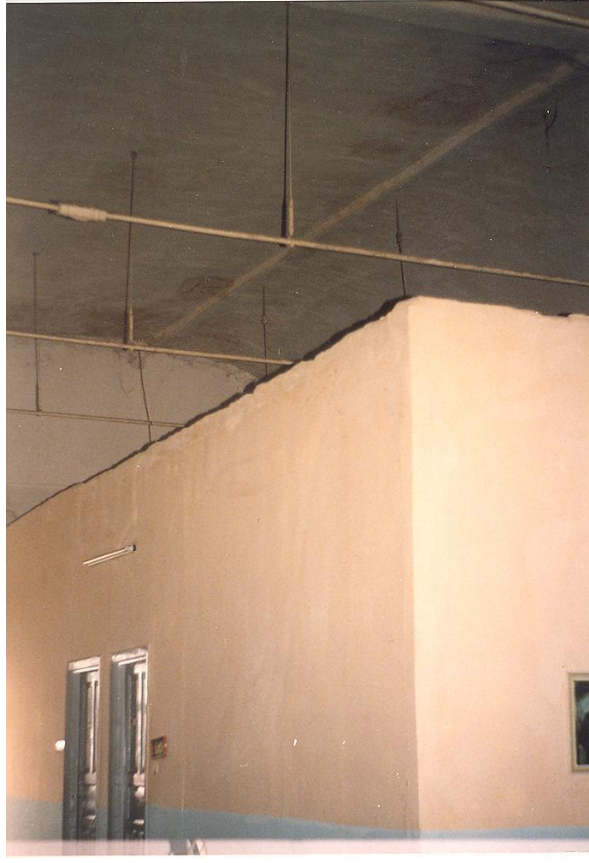
Şekil D.5: Yapının ikinci katındaki, bölücü duvarlar ve metal gergiler
