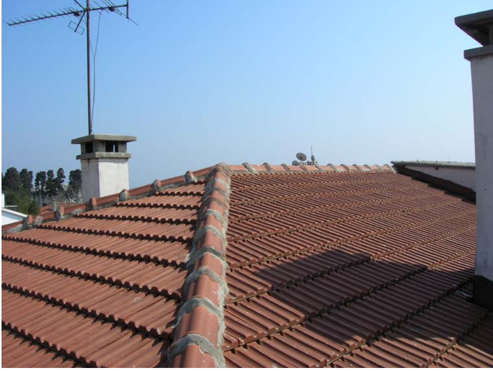
Şekil B159 – Yapının kırma çatısı
