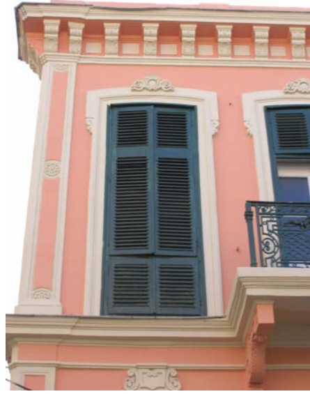
Şekil B142 – Kuzey Cephesi pilastrlar
