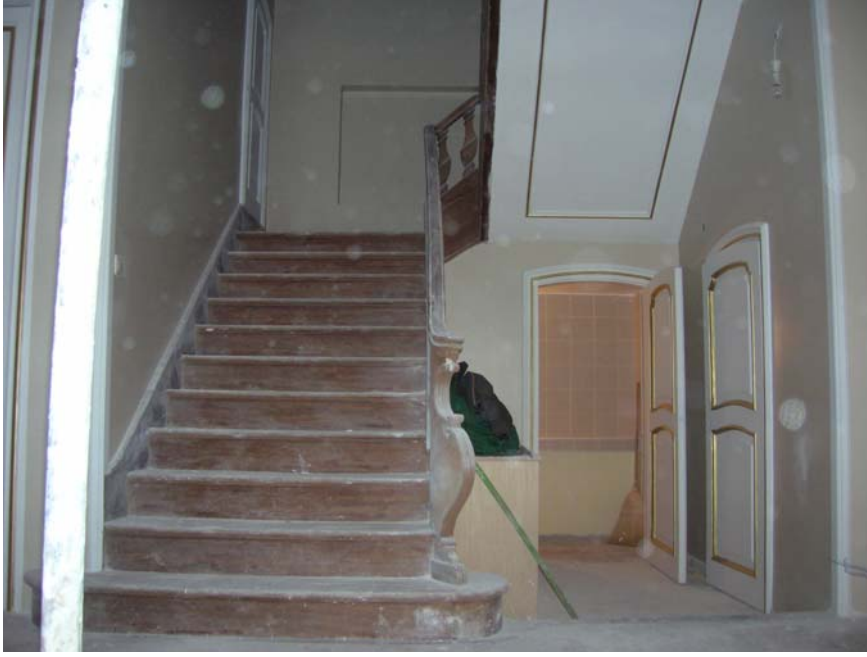
Şekil B161 – M1 ahşap merdiveni
