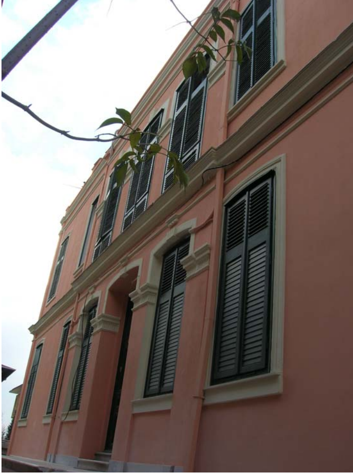
Şekil B147 – Doğu cephesi
