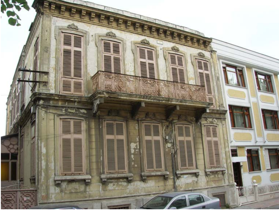
Şekil B139 – Kuzey Cephesi (Temmuz 2006)
