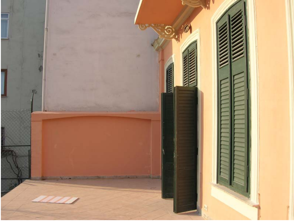
Şekil B46 – Z09 mekanı batı duvarı
