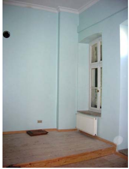
Şekil B66 – 102 mekanı batı duvarı
