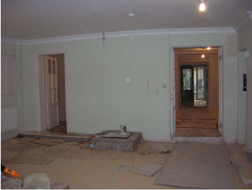
Şekil B123 – B06 mekanı güney duvarı
