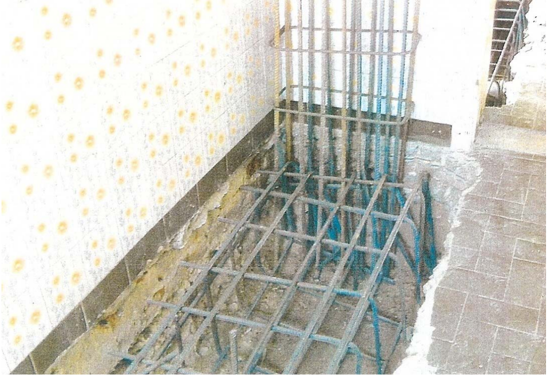
Şekil B197 – Yapıya uygulanan betonarme ve çelik eklentiler
