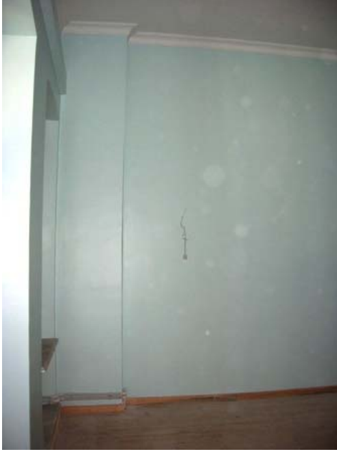
Şekil B69 – 102 mekanı doğu duvarı
