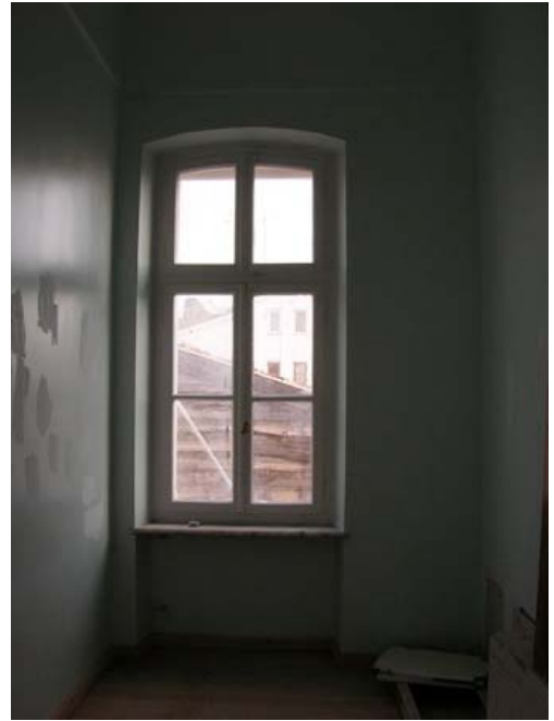
Şekil B76 – 104 mekânı doğu duvarı
