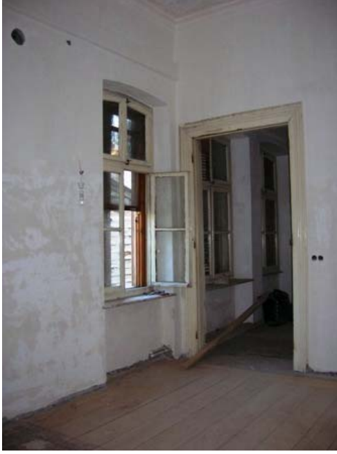
Şekil B57 – 101 mekanı doğu ve güney duvarı (Eylül 2006)
