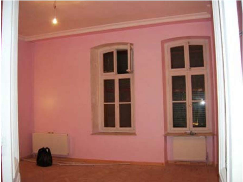
Şekil B18 – Z02 mekanı kuzey duvarı
