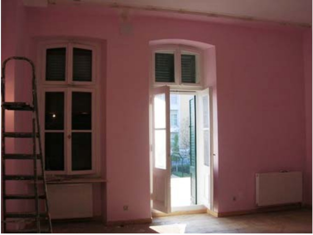
Şekil B28 – Z04 mekanı güney duvarı
