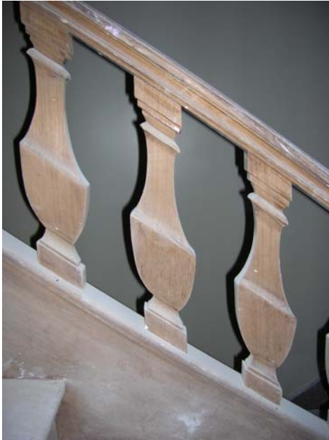
Şekil B162 – M1 merdiveni ahşap korkulukları
