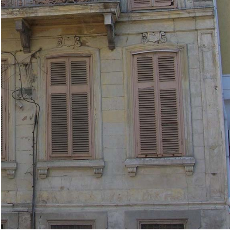
Şekil B143 – Kuzey cephesi- taş taklidi sıva
