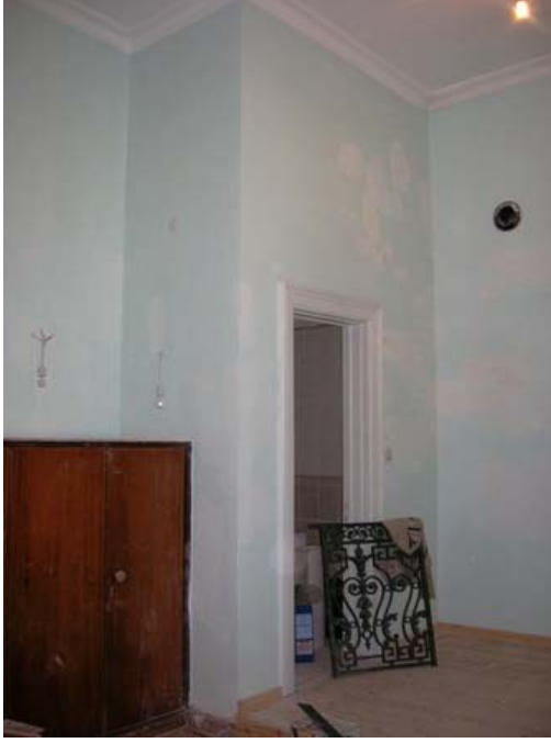
Şekil B65 – 102 mekanı güney duvarı
