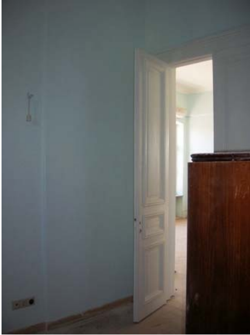
Şekil B63 – 102 mekanı güney duvarı
