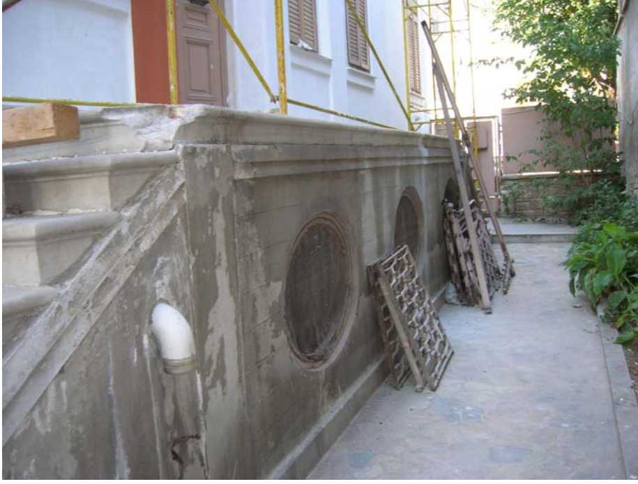
Şekil B149 – Giriş merdivenleri ve taş taklidi sıva
