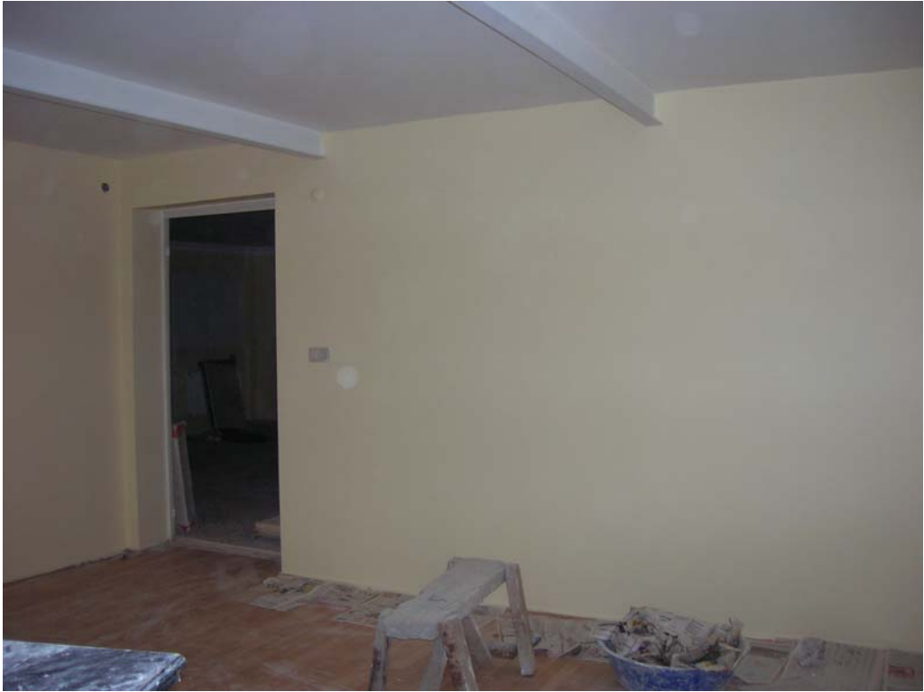
Şekil B107 – B02 mekânı güney duvarı
