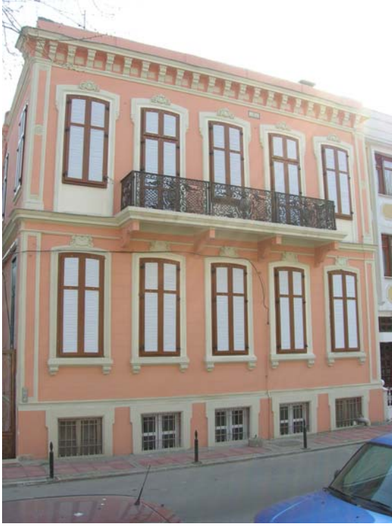
Şekil B188 – Niteliksiz pvc malzeme ile yenilenen kepenkler
