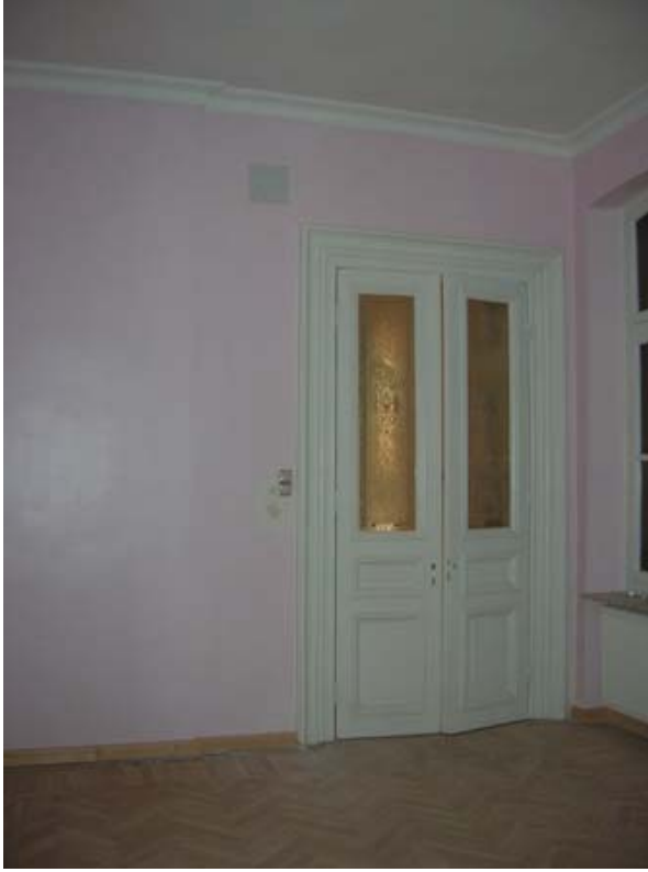
Şekil B19 – Z03 mekanı kuzey duvarı
