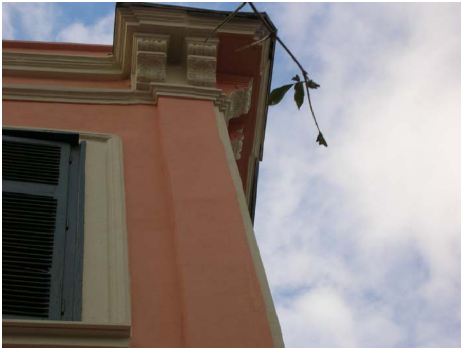
Şekil B148 – Taş saçak kornişleri
