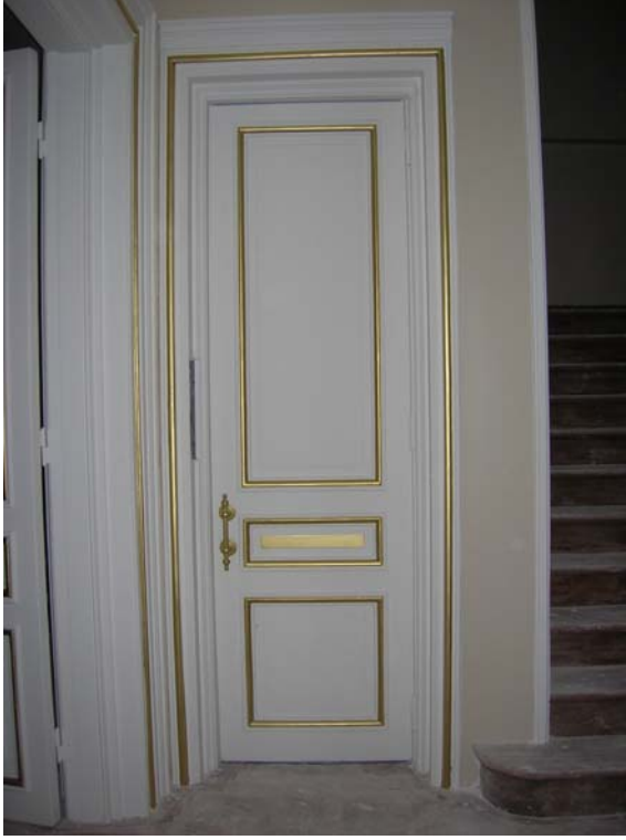
Şekil B175 – Zemin kat asansör kapısı
