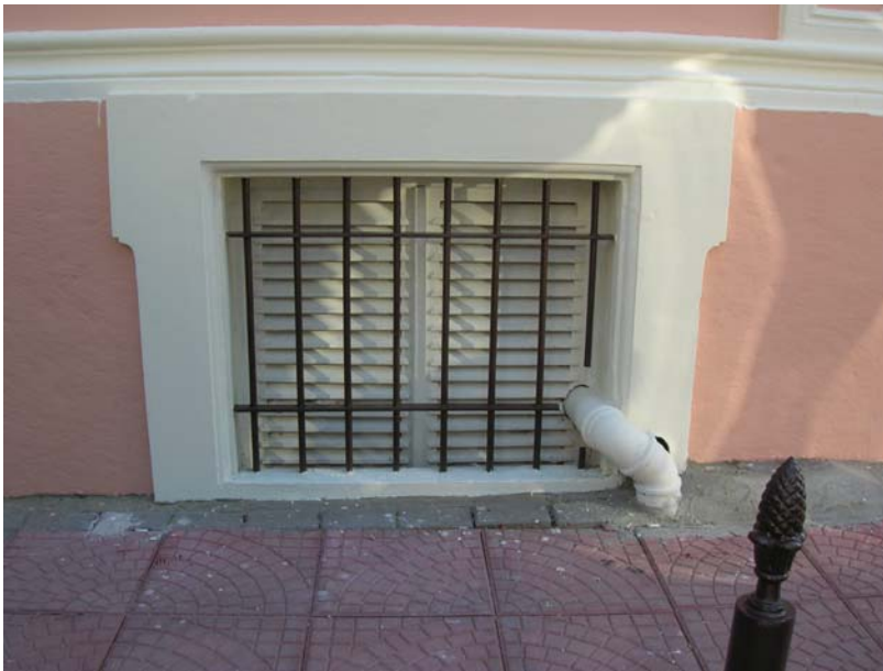
Şekil B193 – Bodrum kat kuzey cephesi pencereleri önündeki parmaklıklar
