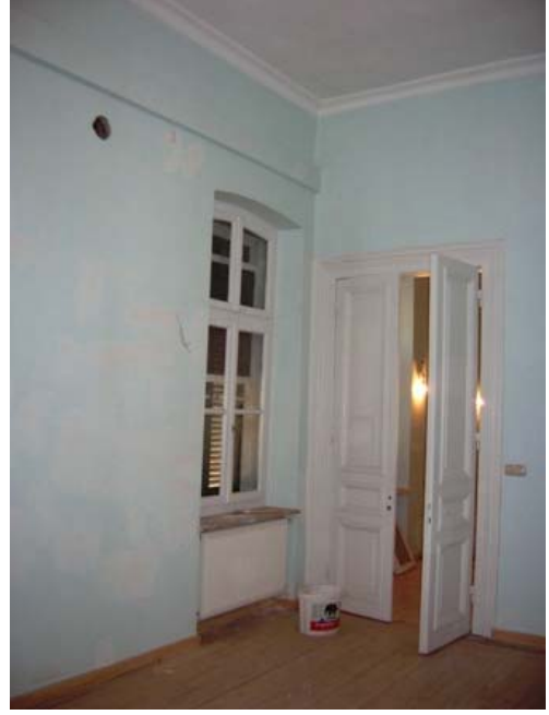
Şekil B58 – 101 mekanı doğu ve güney duvarı
