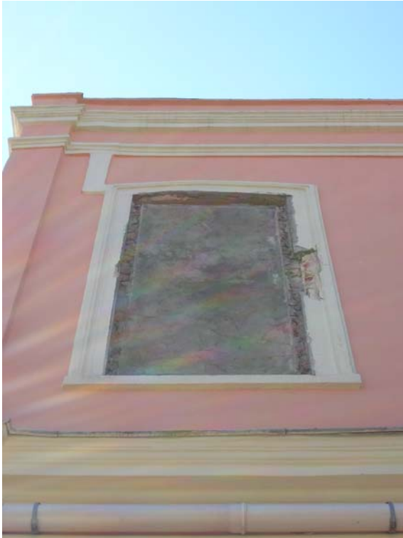
Şekil B152 – Doğu Cephesi kapatılmış pencere
