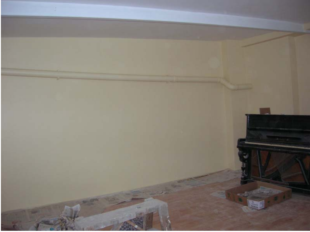
Şekil B108 – B02 mekânı batı-kuzey duvarı
