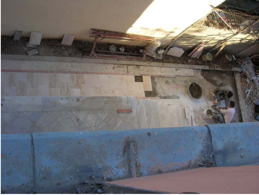
Şekil B203 – Travertenle kaplanan özgün mermer basamaklar
