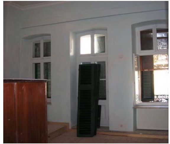
Şekil B68 – 102 mekanı kuzey duvarı
