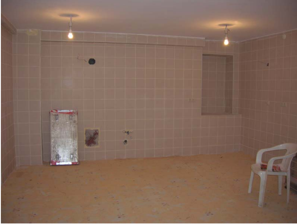
Şekil B121 – B05 mekânı batı duvarı
