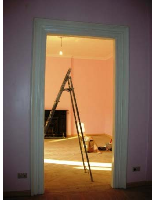
Şekil B24 – Z03 mekanı batı duvarı
