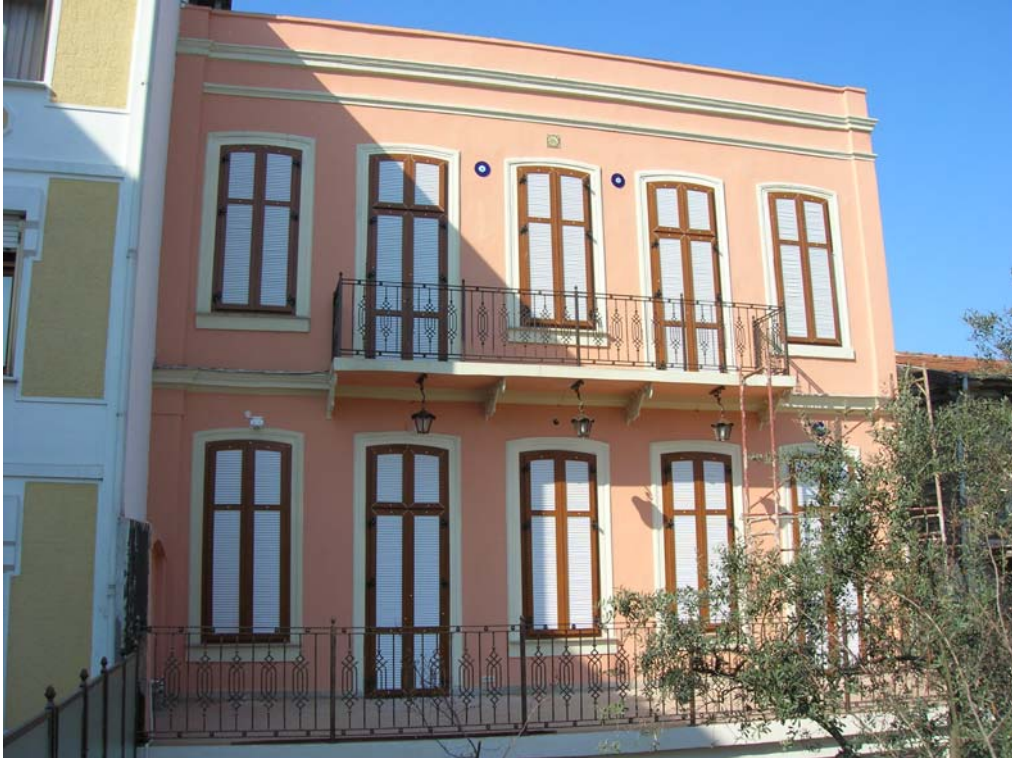
Şekil B156 – Güney cephesi değiştirilen balkon korkulukları
