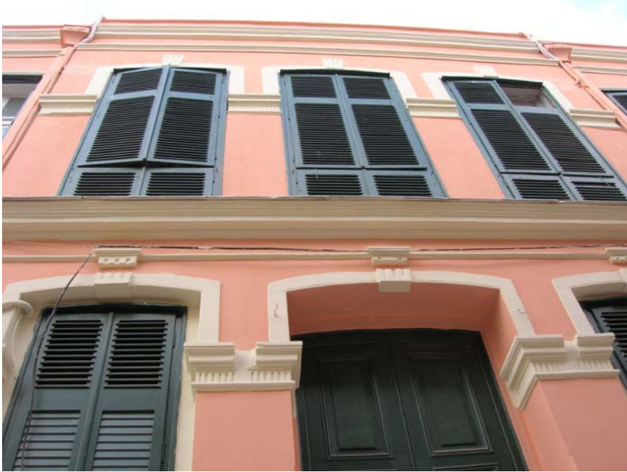
Şekil B150 – Doğu cephesi
