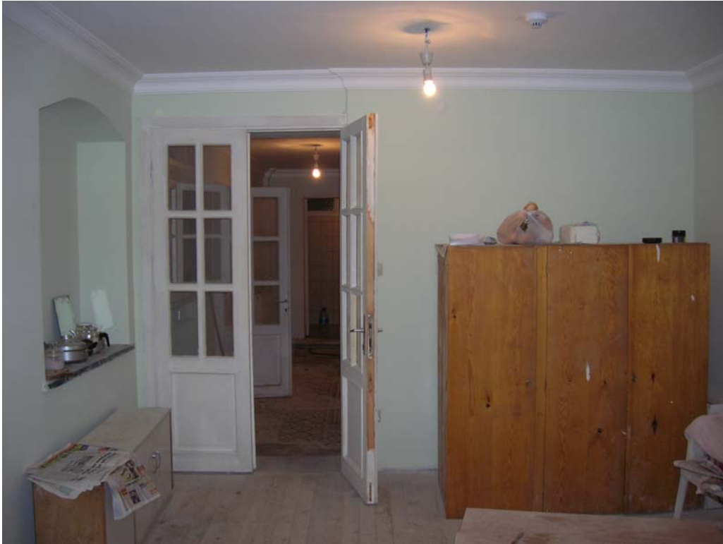
Şekil B103 – B01 mekanı güney duvarı
