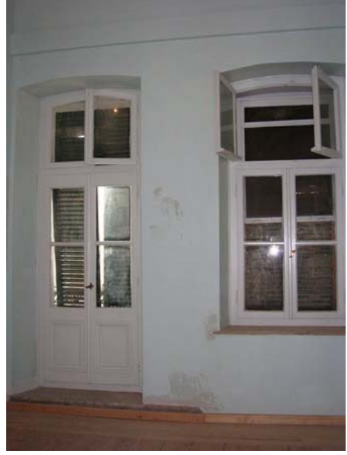
Şekil B62 – 101 mekanı kuzey duvarı
