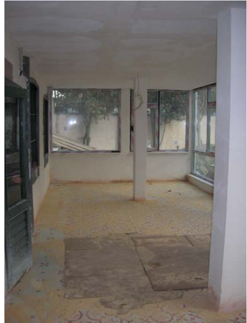
Şekil B135 – B11 mekanı doğu duvarı
