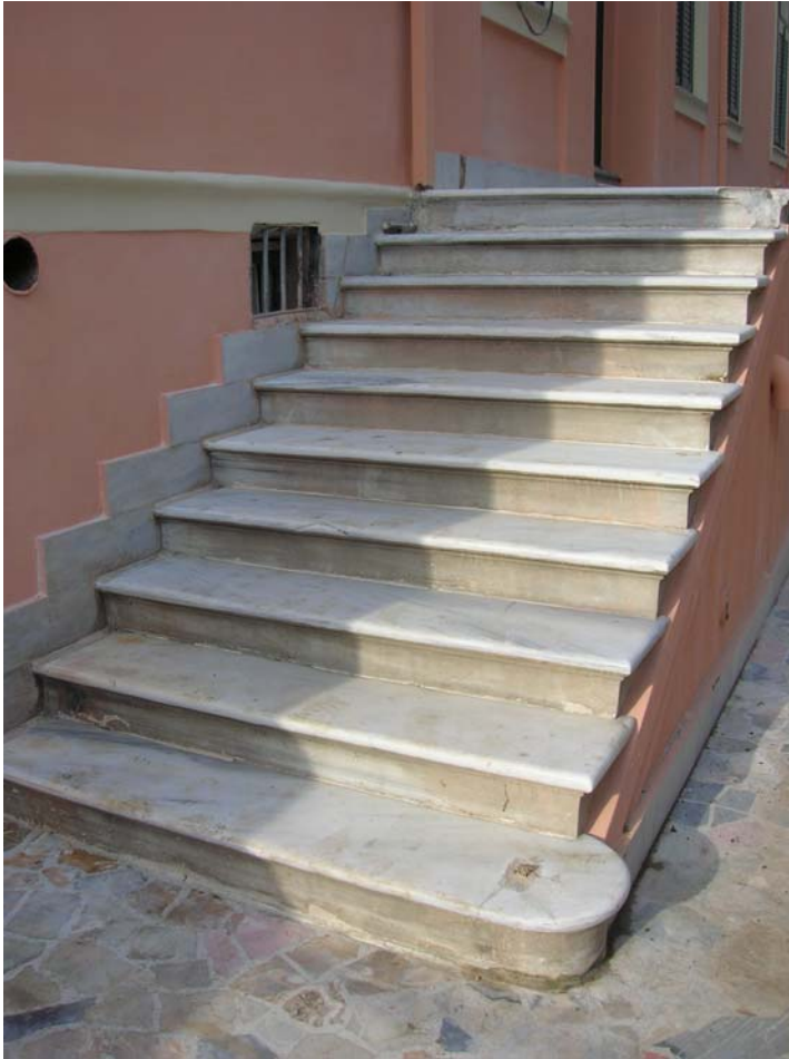
Şekil B166 – Mermer giriş merdivenleri
