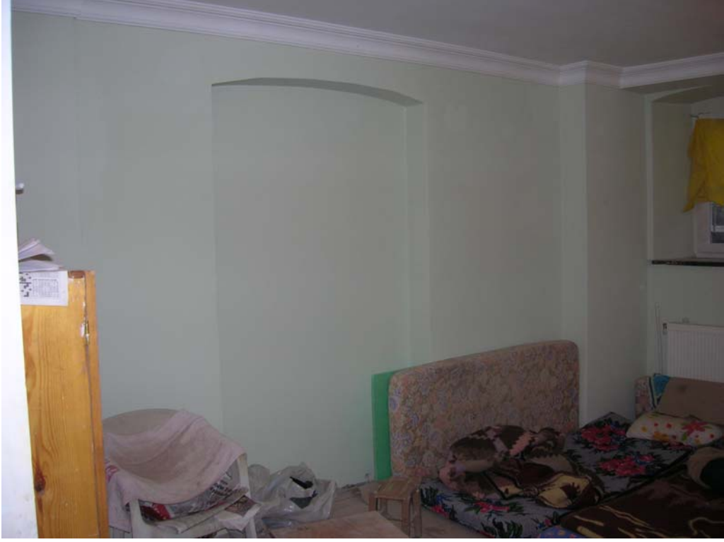
Şekil B104 – B01 mekanı batı duvarı
