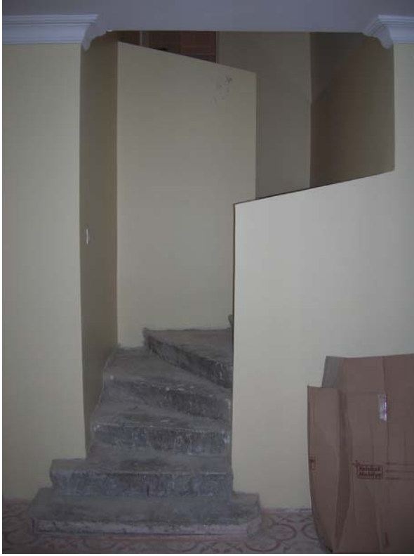
Şekil B102 – Bodrum kata inen M2 merdivenleri
