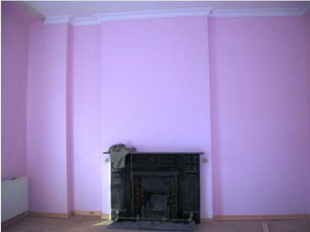
Şekil B29 – Z04 mekanı batı duvarı
