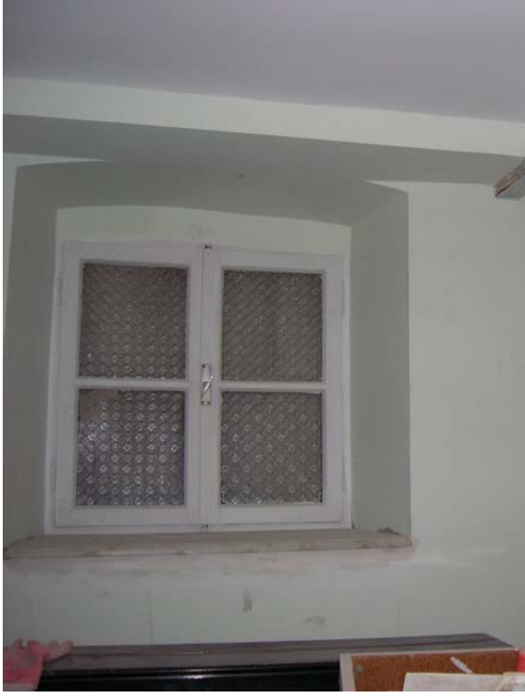
Şekil B183 – Bodrum kat kuzey cephesi pencereleri
