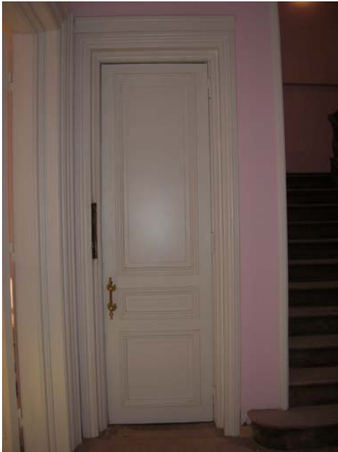
Şekil B35 – Asansör kapısı (zemin kat)
