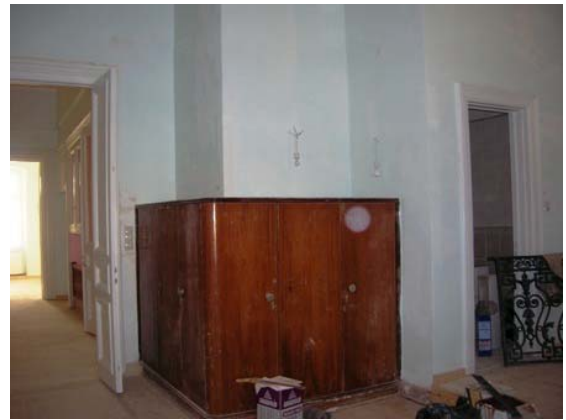
Şekil B64 – 102 mekanı güney duvarı
