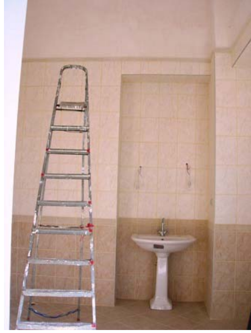
Şekil B70 – 103 mekanı batı duvarı
