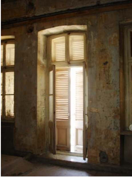
Şekil B67 – 102 mekanı kuzey duvarı
