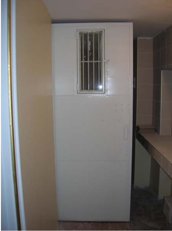
Şekil B176 – M2 merdivenine ulaşan metal kapı
