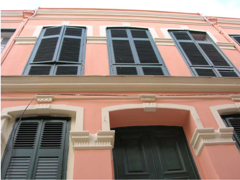
Şekil B191 – Doğu cephesinde bulunan kepenkler
