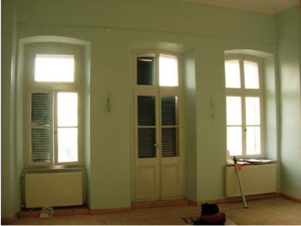
Şekil B84 – 105 mekanı güney duvarı
