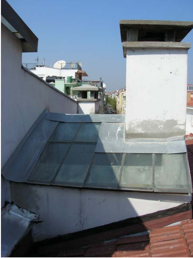
Şekil B160 – Asansör kuyusunun duvarları
