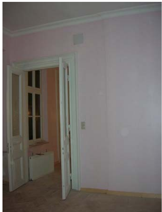
Şekil B10 – Z01 mekanı güney duvarı
