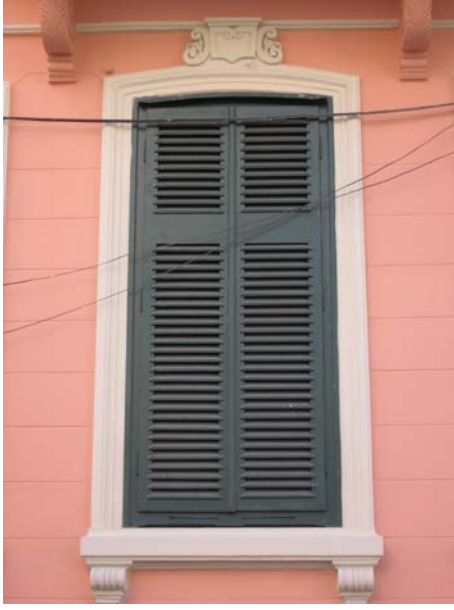
Şekil B189 – Kuzey cephesi kepenkleri
