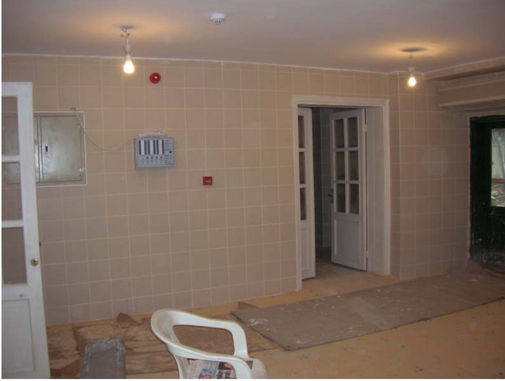
Şekil B119 – B05 mekânı doğu duvarı
