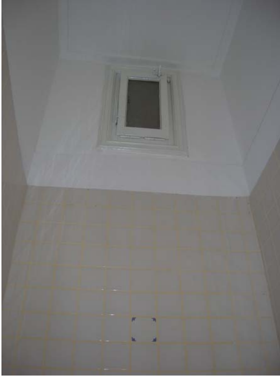
Şekil B39 – Z06 mekanı batı duvarı
