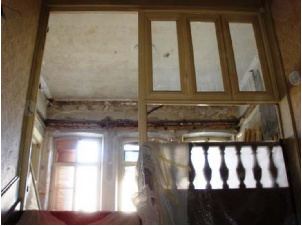
Şekil B55 – M1 merdivenlerinden 107 mekanına bakış ( Temmuz 2006 )
