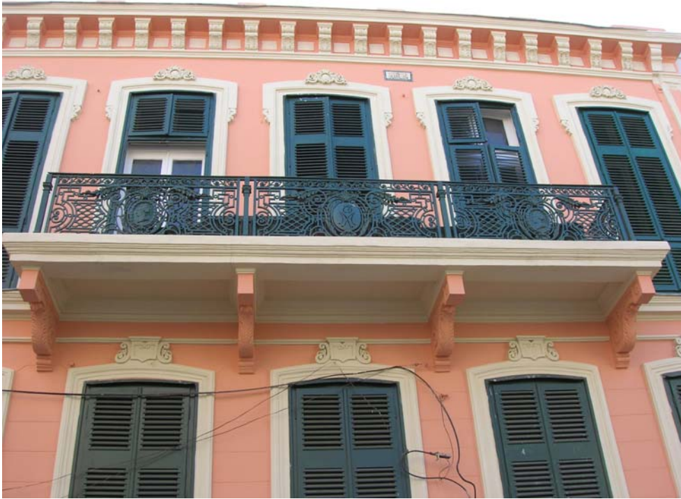
Şekil B146 – Birinci kat balkonu döküm korkulukları
