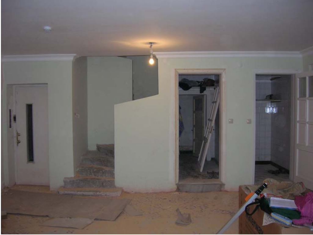
Şekil B125 – B06 mekânı batı duvarı
