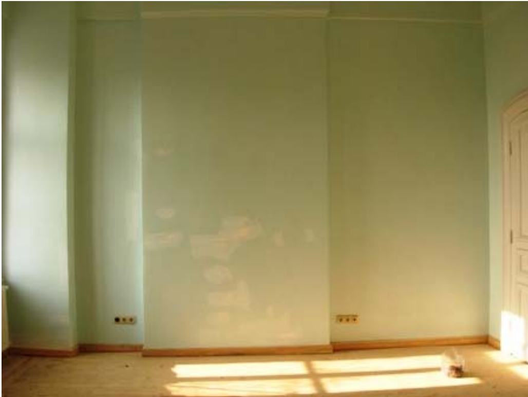
Şekil B85 – 105 mekanı batı duvarı
