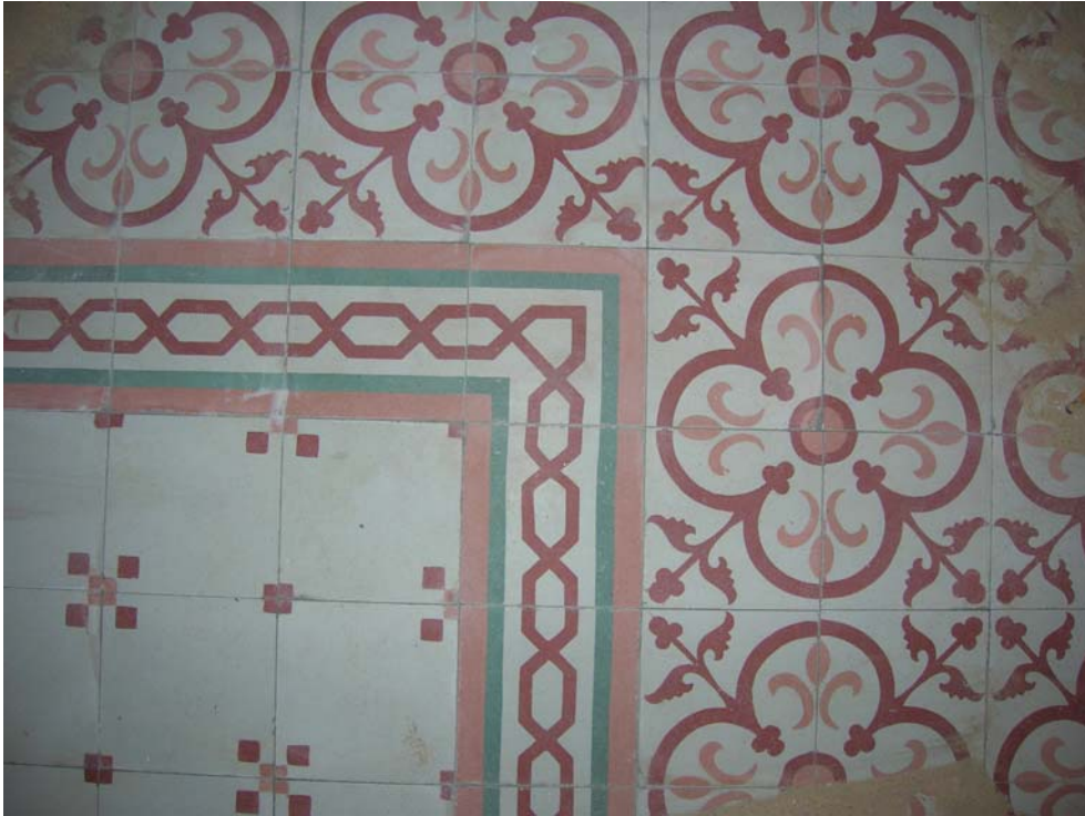
Şekil B158 – Son müdahaleler sırasında döşenen yeni terrazzolardan örnek
