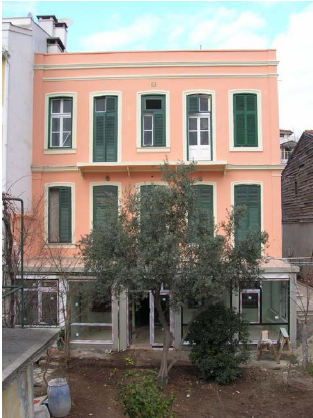
Şekil B154 – Güney Cephesi
