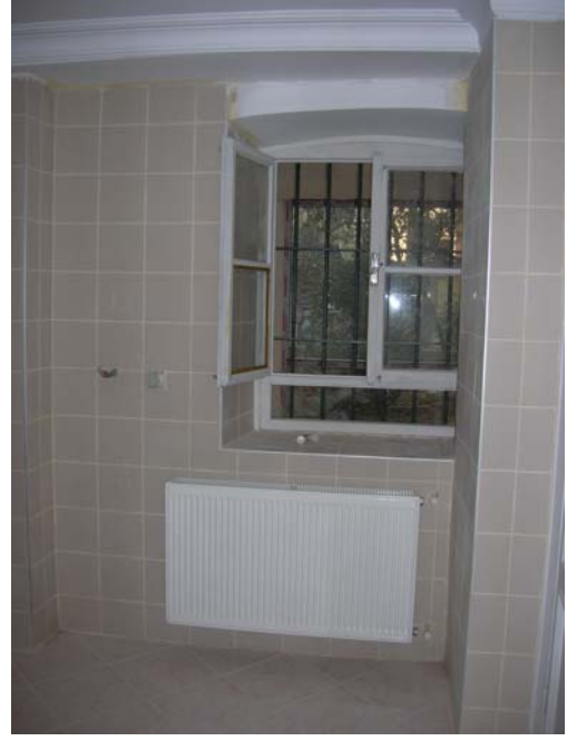
Şekil B114 – B03 mekanı güney duvarı
