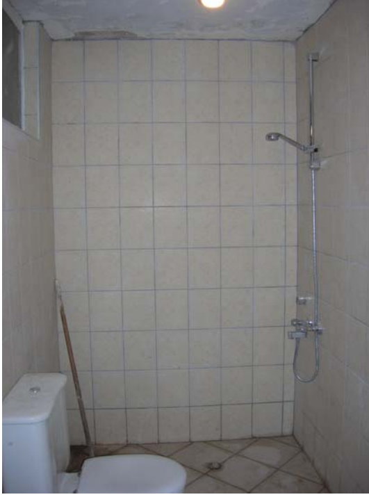
Şekil B117 – B04 mekânı batı duvarı
