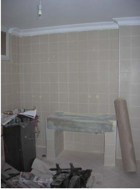
Şekil B113 – B03 mekanı doğu duvarı
