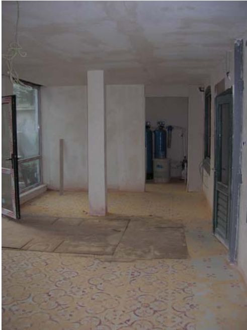
Şekil B134 – B11 mekanı batı duvarı
