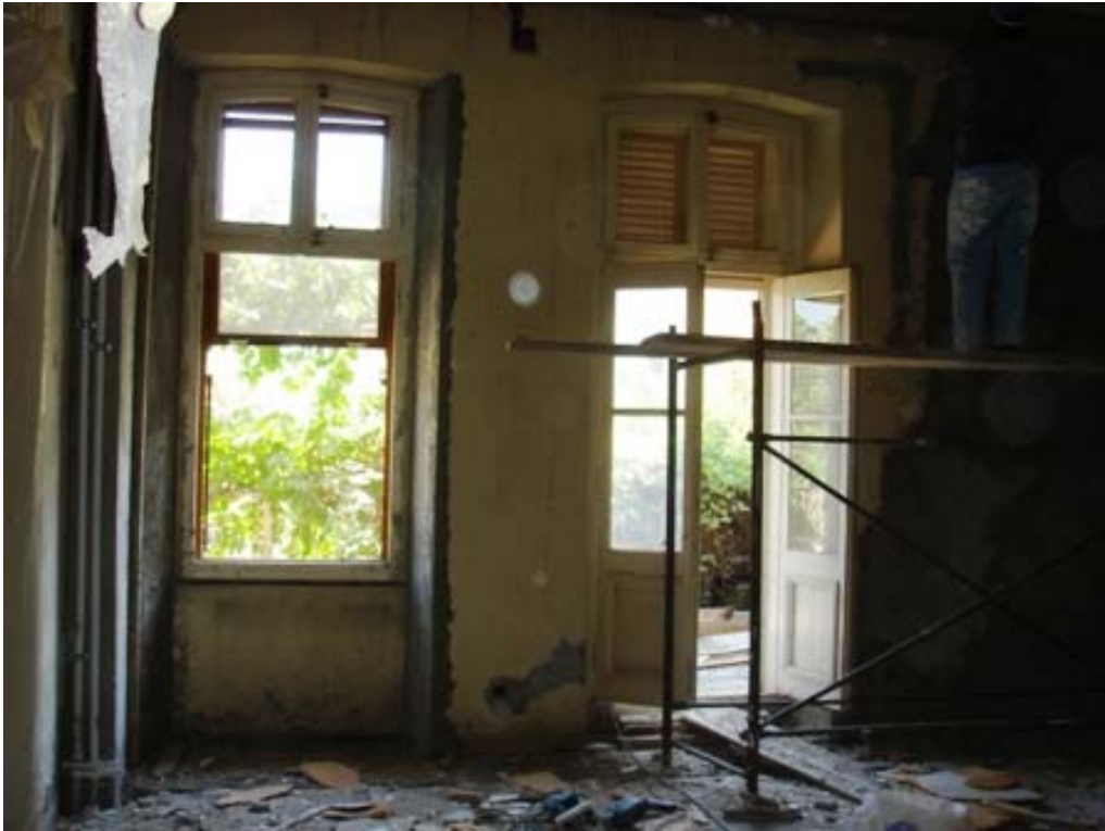
Şekil B27 – Z04 mekanı güney duvarı ( Temmuz 2006 )
