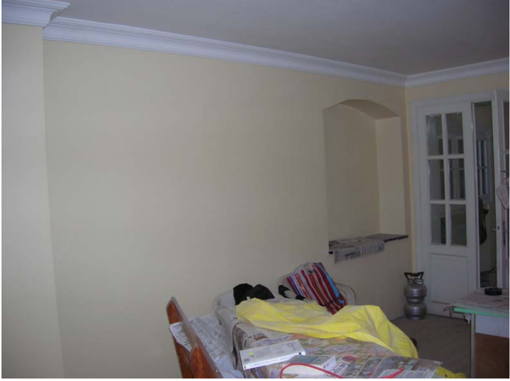
Şekil B106 – B01 mekânı doğu duvarı
