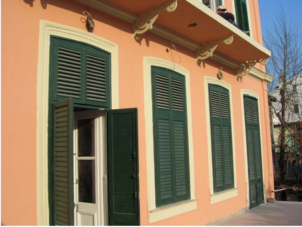
Şekil B44 – Z09 mekanı kuzey duvarı
