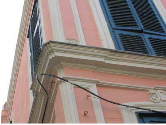
Şekil B141 – Kuzey Cephesi kat silmeleri
