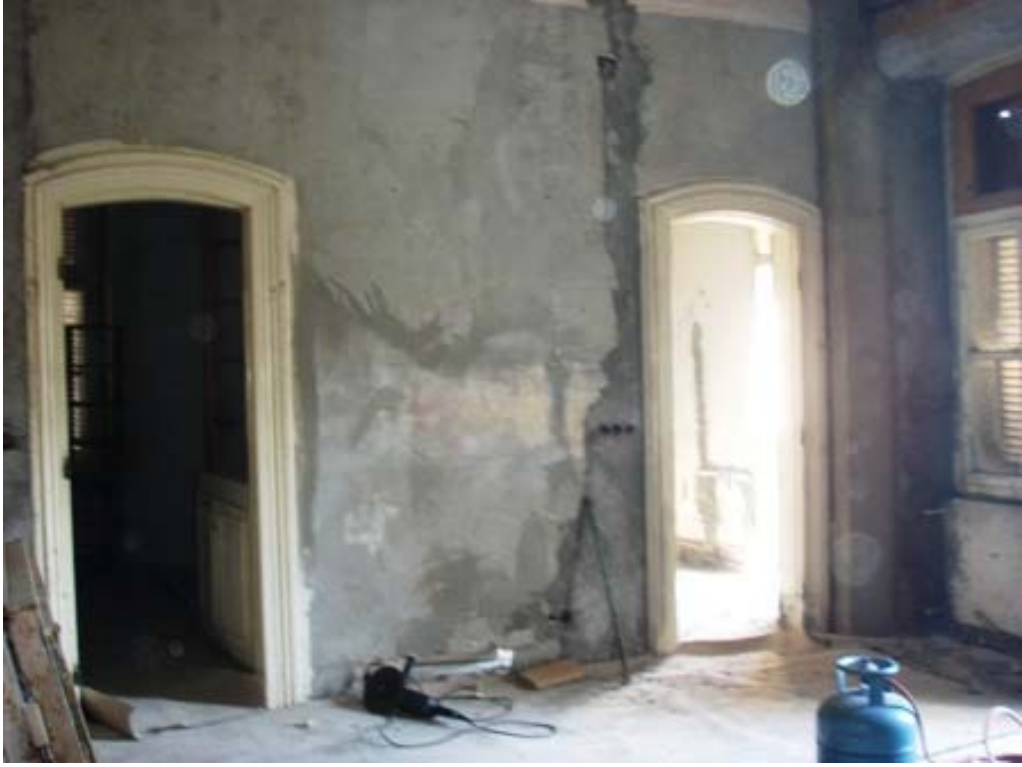
Şekil B80 – 105 mekanı doğu duvarı ( Temmuz 2006 )
