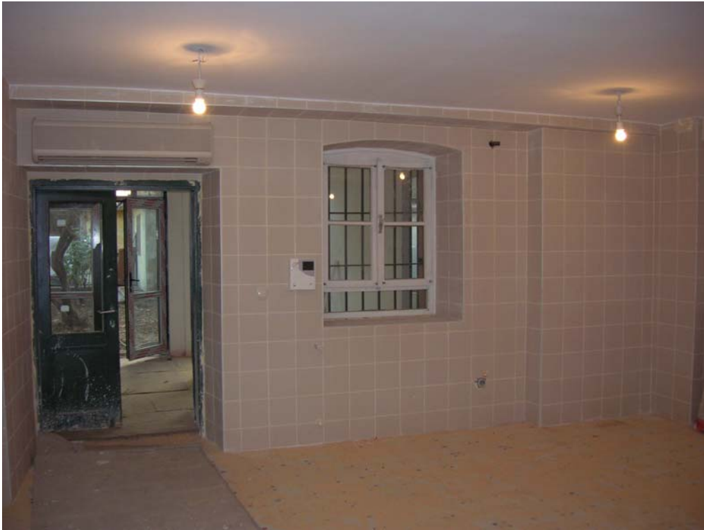
Şekil B120 – B05 mekânı güney duvarı
