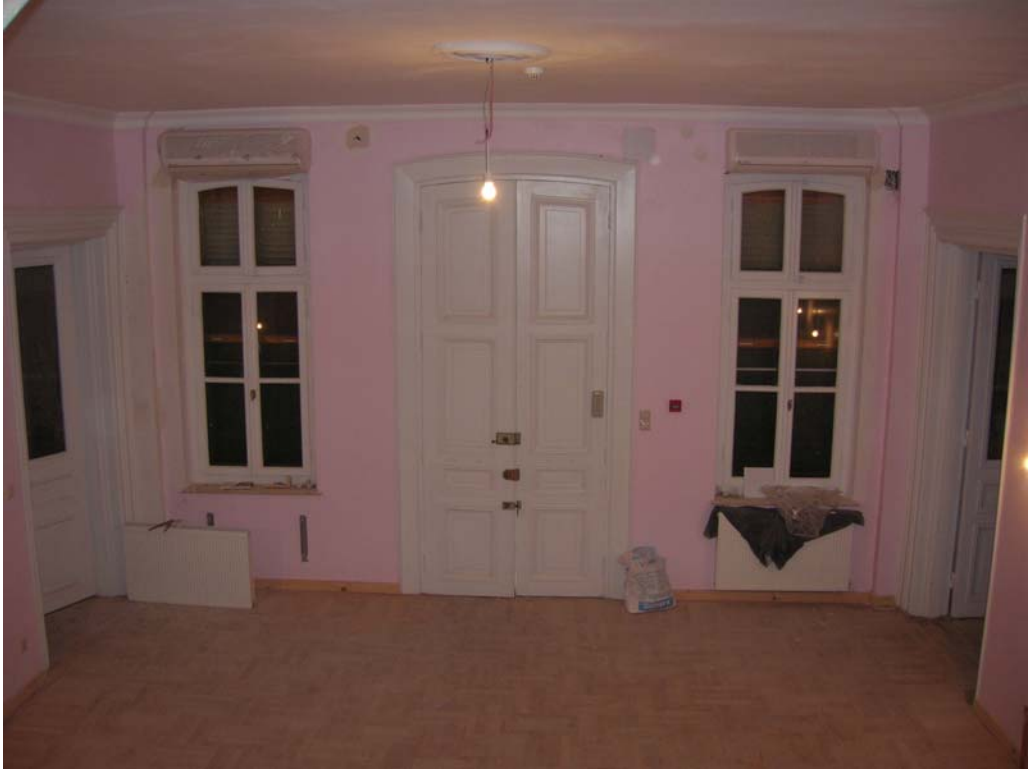
Şekil B30 – Z05 mekanı doğu duvarı ve bina giriş kapısı
