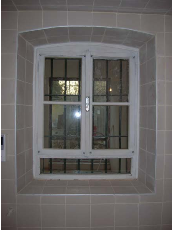
Şekil B184 – Bodrum kat güney cephesi pencereleri
