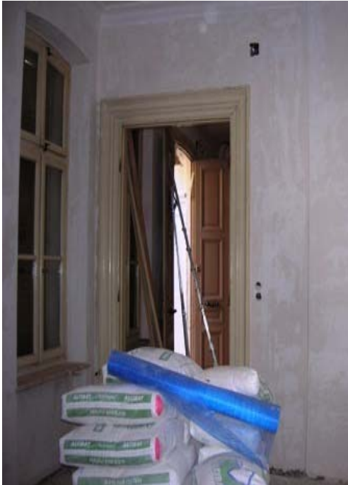
Şekil B9 – Z01 mekanı güney duvarı ( Eylül 2006 )
