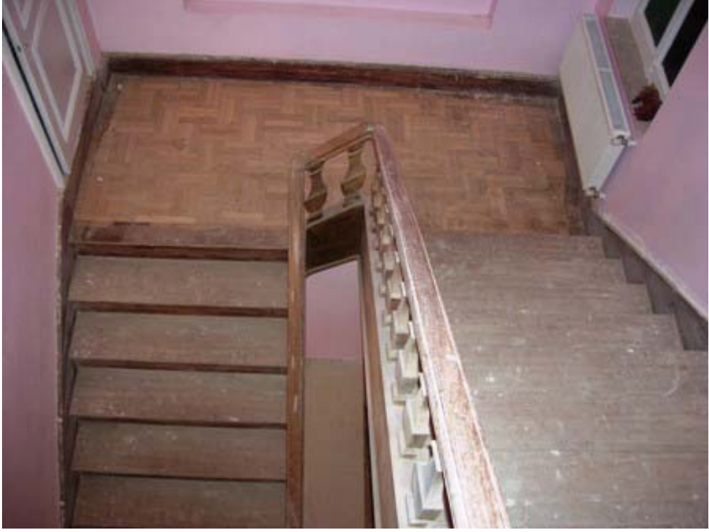
Şekil B48 – M1 merdivenleri ve A02 mekanı
