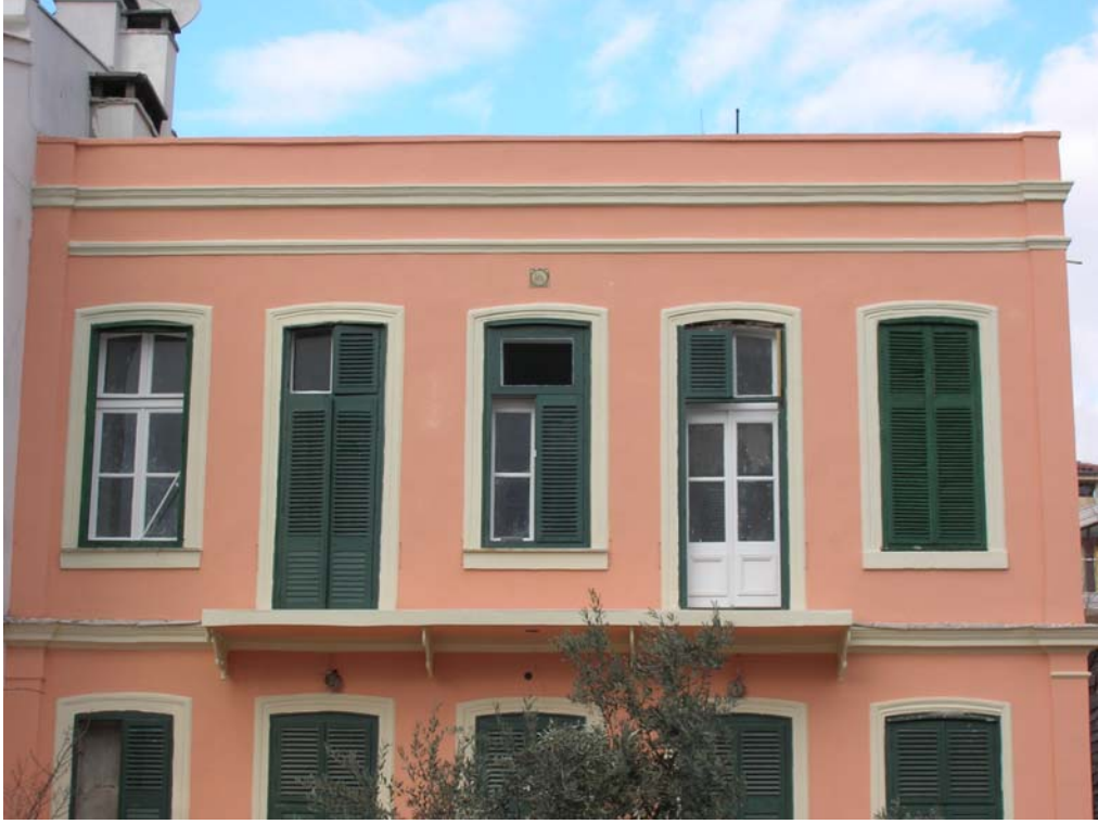
Şekil B192 – Güney cephesinde bulunan kepenkler
