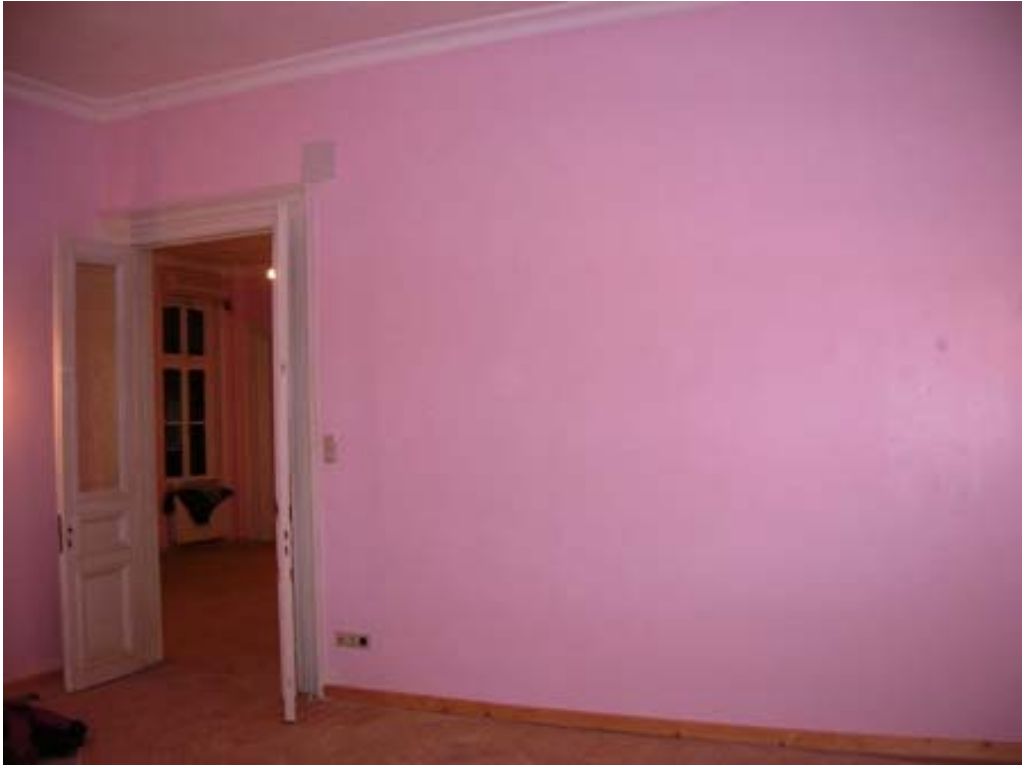
Şekil B16 – Z02 mekanı güney duvarı
