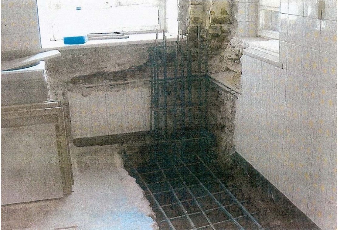
Şekil B198 – Yapıya uygulanan betonarme ve çelik eklentiler
