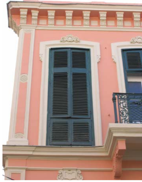
Şekil B190 – Kuzey cephesi kepenkleri
