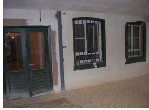
Şekil B133 – B11 mekanı kuzey duvarı
