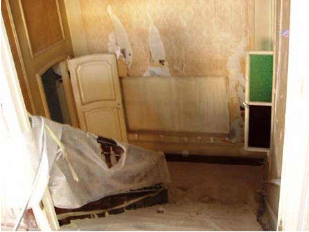
Şekil B53 – M1 merdivenleri ve A02 mekanı ( Temmuz 2006 )
