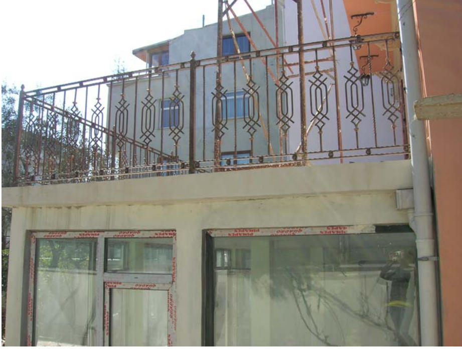
Şekil B153 – Kapatılmış veranda ve zemin kat balkonu demir korkulukları
