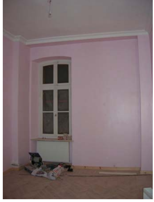
Şekil B12 – Z01 mekanı kuzey duvarı
