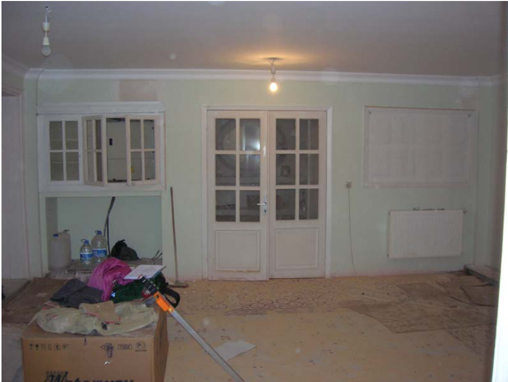
Şekil B124 – B06 mekanı doğu duvarı
