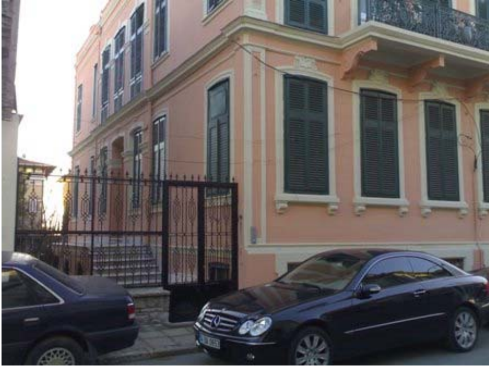
Şekil B2 – Kuzey Cephesi girişi
