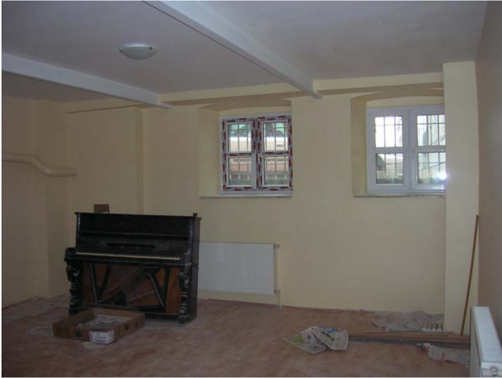
Şekil B200 – Bodrum kat B02 mekanında bulunan çelik I profiller
