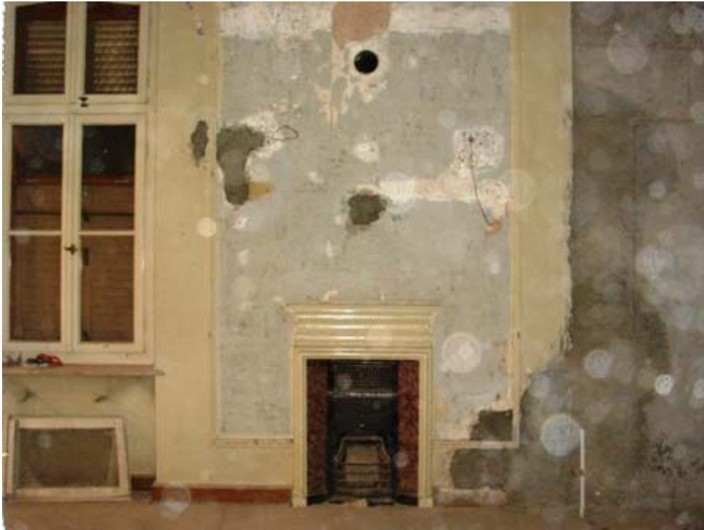
Şekil B20 – Z03 mekanı doğu duvarı ( Temmuz 2006 )
