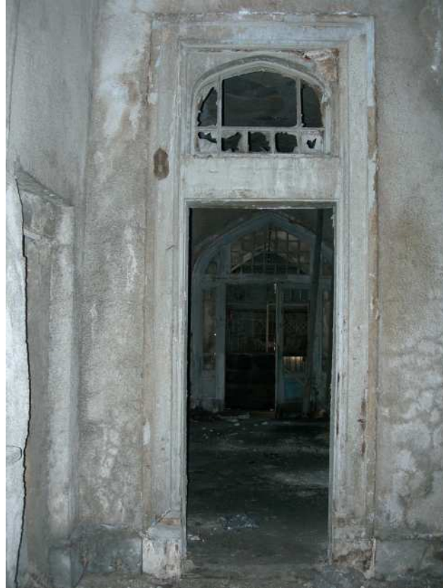
Şekil C.17. ZK04; mekana giriş kapısı
