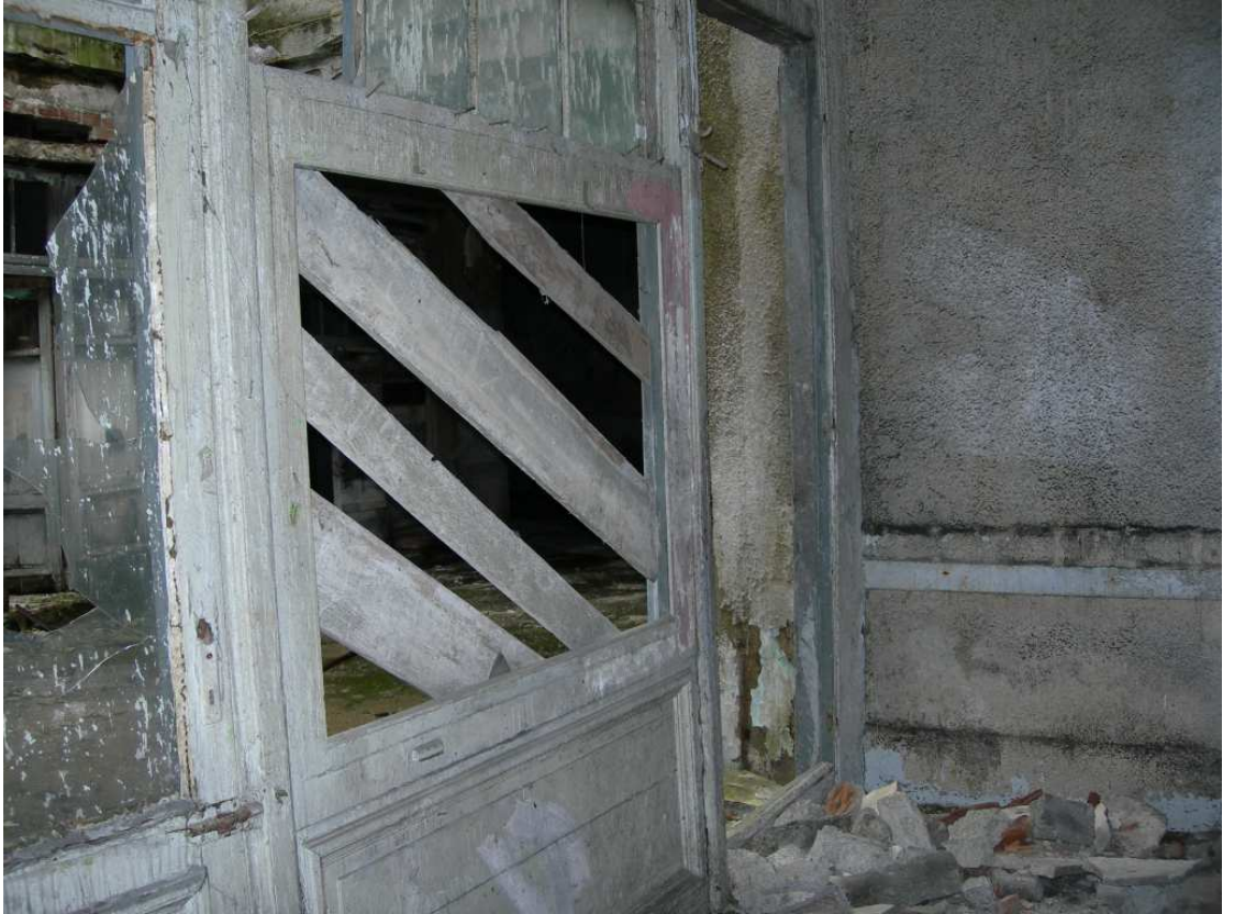
Şekil C.61. ZK19; dükkanda ahşap sandalyelik elemanı
