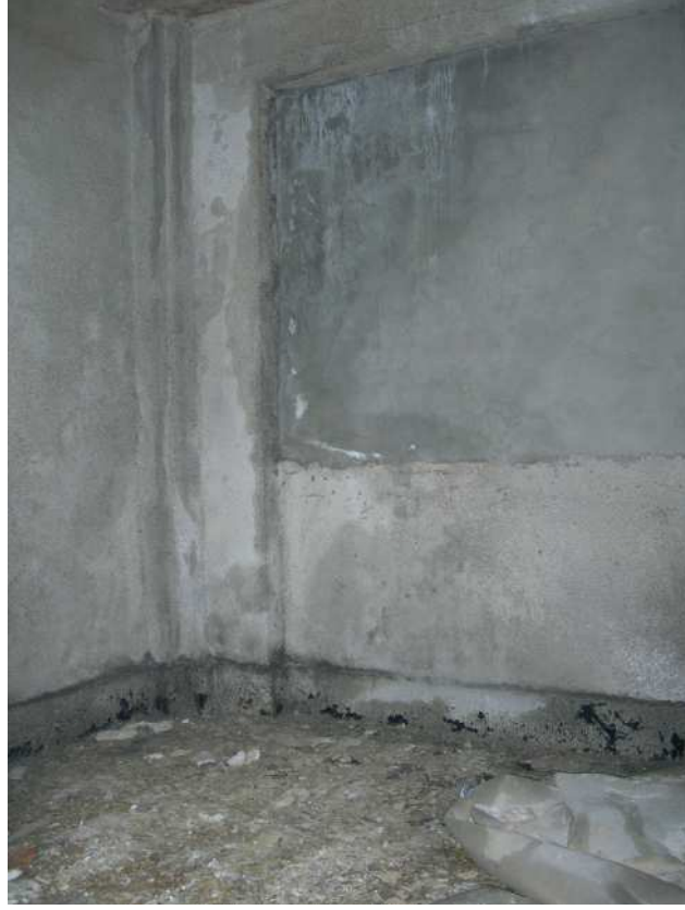
Şekil C.100. BK05; ofiste kapatılmış pencere izi BPC01
