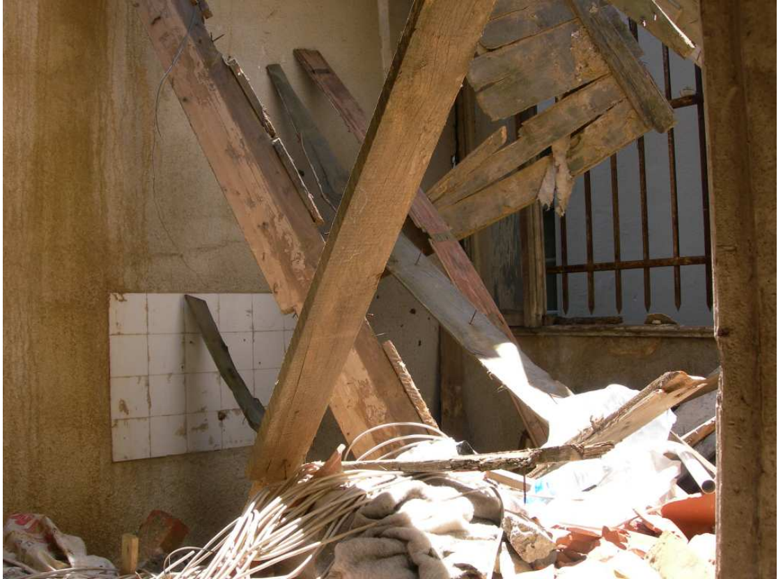
Şekil C.111. BK09; ofisin güney duvarı üzerindeki BPC03 penceresi
