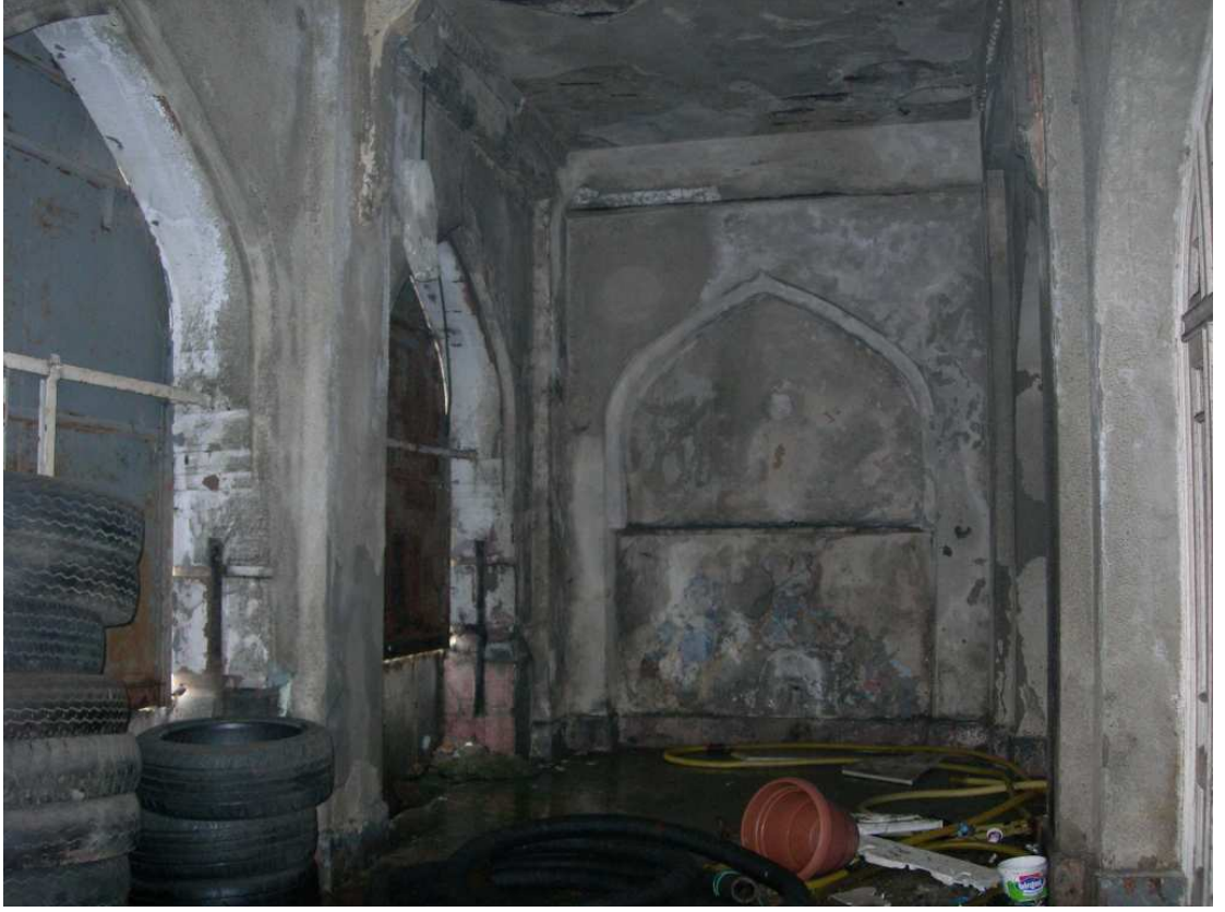
Şekil C.7. ZK01; güney duvarı
