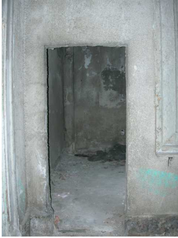
Şekil C.20. ZK05; doğu duvarı üzerinde ZK06 mekanına giriş kapısı ZKD01
