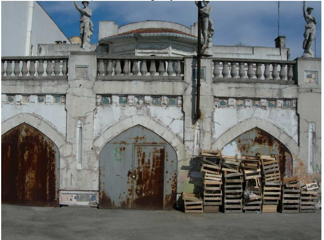
Şekil C.146 Doğu cephesi; sivri kemerli giriş kapıları
