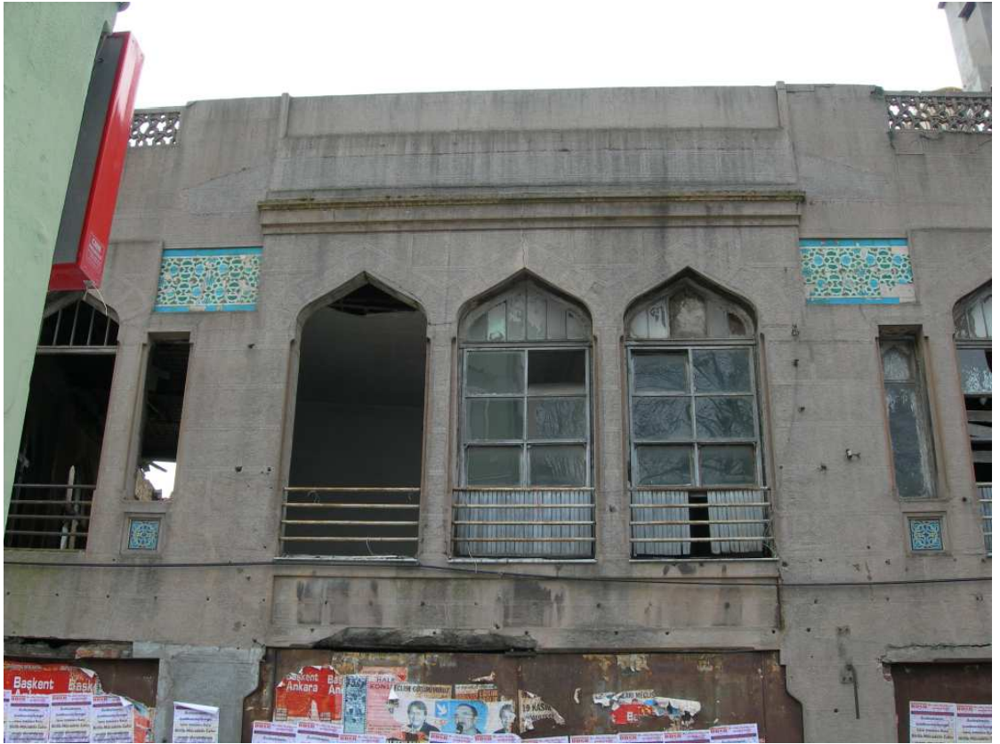
Şekil C.142. Batı cephesi, üçlü pencere düzeni ve profilli saçak silmesi
