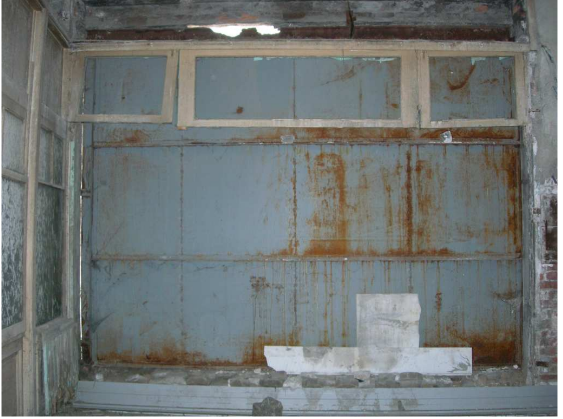
Şekil C.74. ZK23; dükkanın sac levha ile kapatılmış vitrini ZKM03
