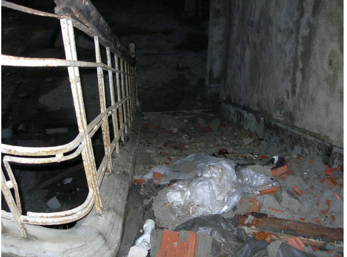
Şekil C.47. ZK12; merdiven holü
