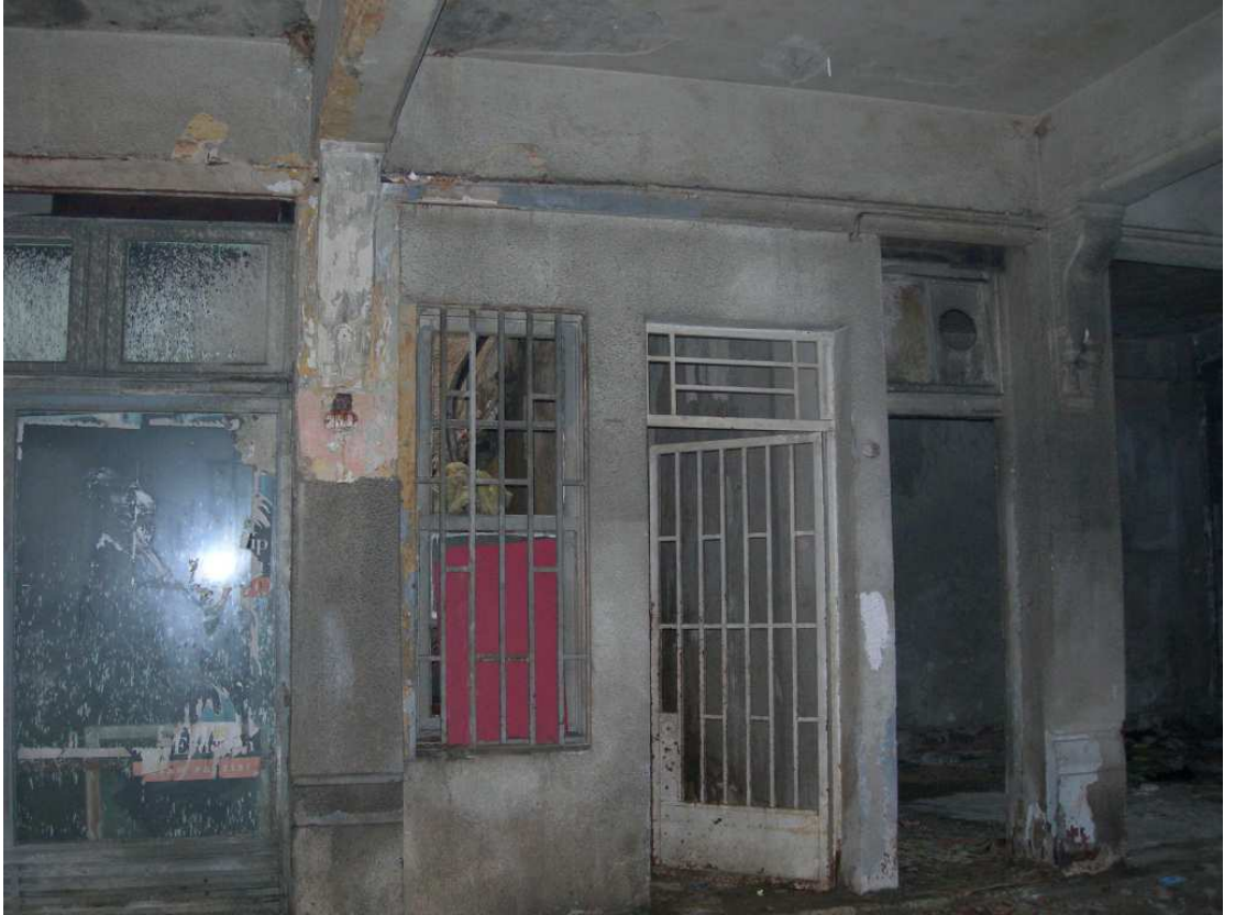
Şekil C.65. ZK21; merdiven holüne giriş kapısı ZKK01 ve kuzey duvarındaki pencere ZPG01
