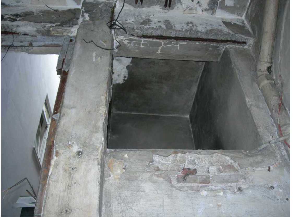
Şekil C.52. ZK16; WC' nin batı duvarındaki niş
