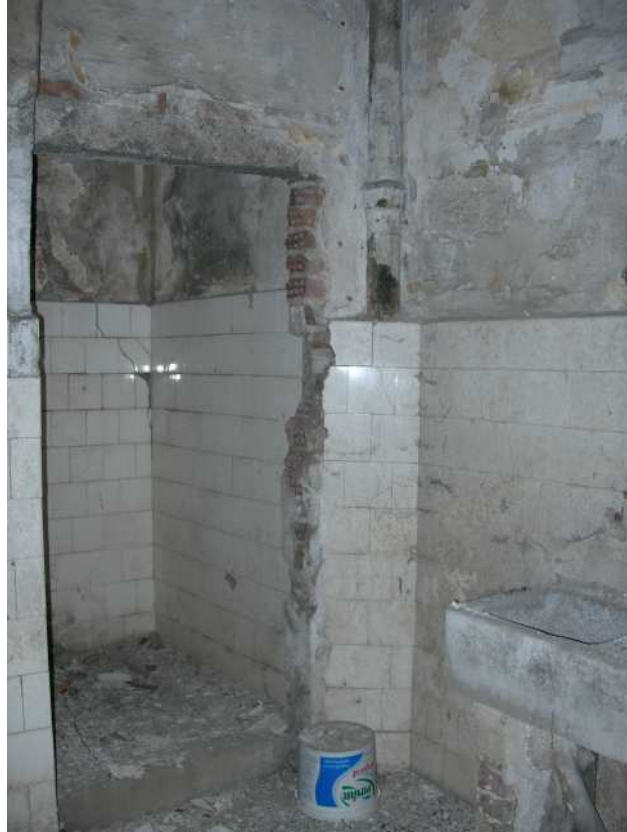
Şekil C.51. ZK16; WC’ de batı duvarı üzerindeki betonarme bölmeler
