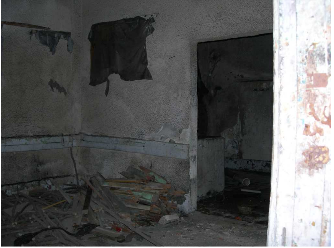
Şekil C.60. ZK19; dükkanda sonradan açılmış kapı ZKJ01
