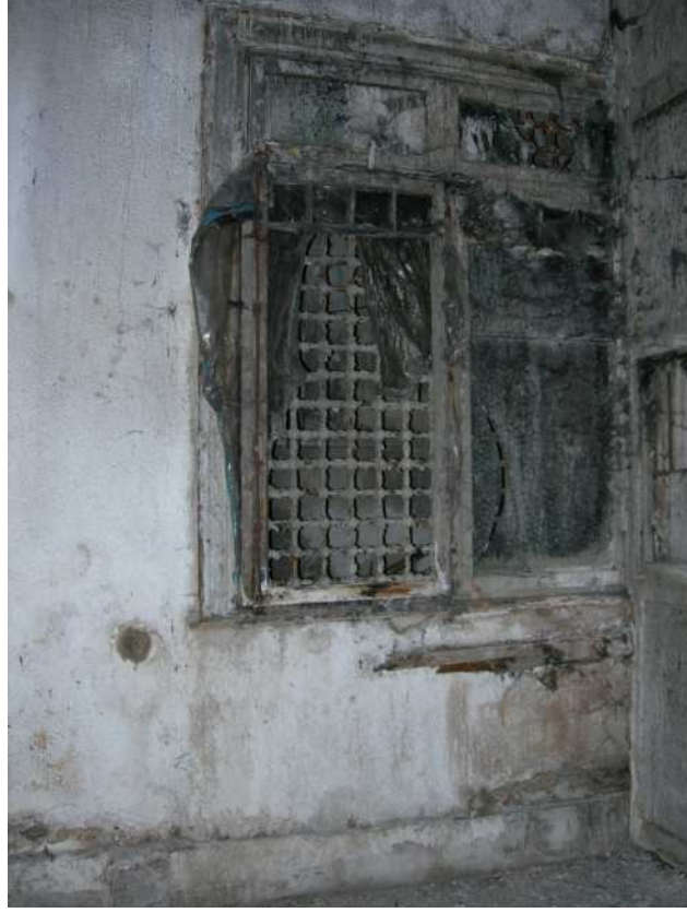
Şekil C.34. ZK09; memur odasının kuzey duvarı üzerindeki ZPB01 penceresi
