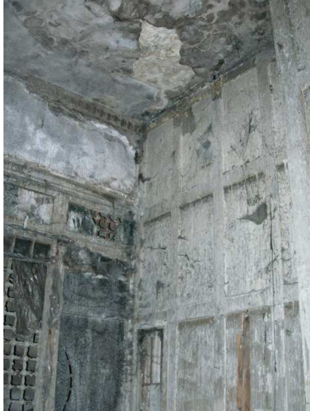
Şekil C.37. ZK09; memur odasının tavanındaki mukarnaslı koltuk silmesi izi
