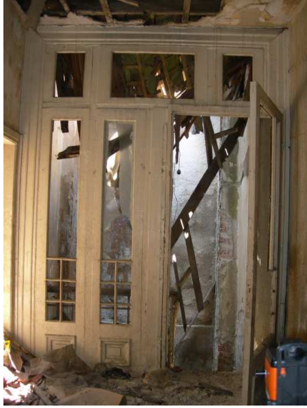
Şekil C.106. BK07; merdiven holü özgün ahşap kapısı BKF01
