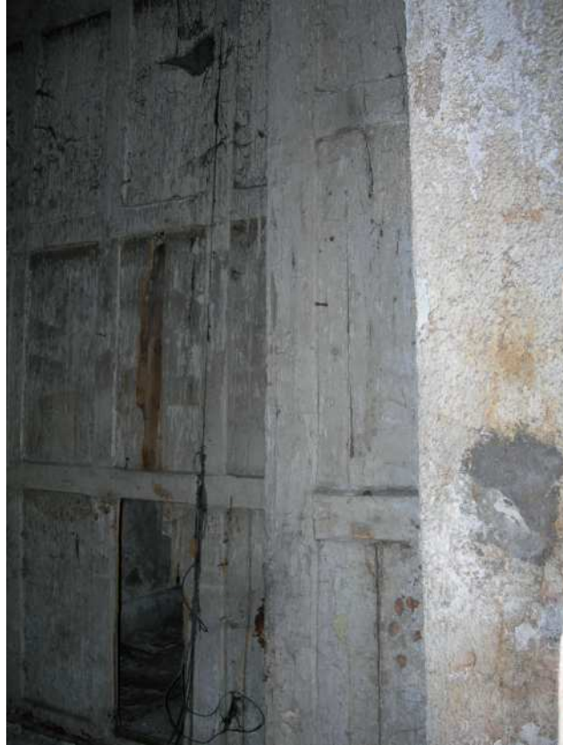
Şekil C.33. ZK09; memur odası içinde sonradan eklenmiş ahşap bölme
