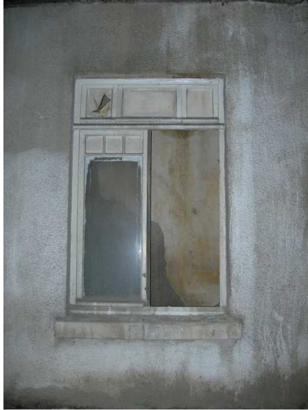
Şekil C.124. BK14; ofisin güney duvarı üzerindeki BPD03 penceresi ve doğal taş denizliği
