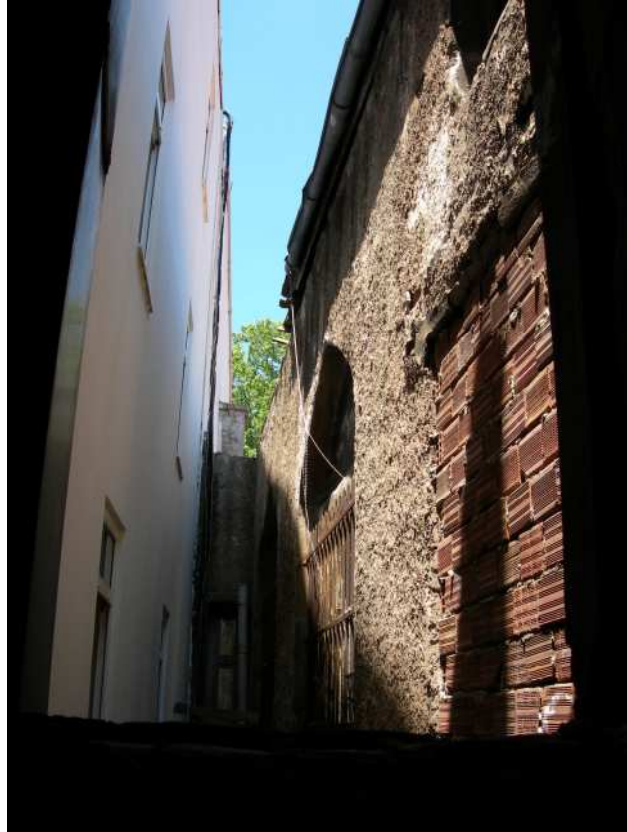
Şekil C.103. BK06; ofisin BPC02 penceresinin kapatılmış kemer izi
