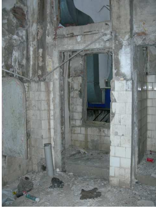
Şekil C.50. ZK16; WC’ de batı duvarı üzerindeki betonarme bölmeler
