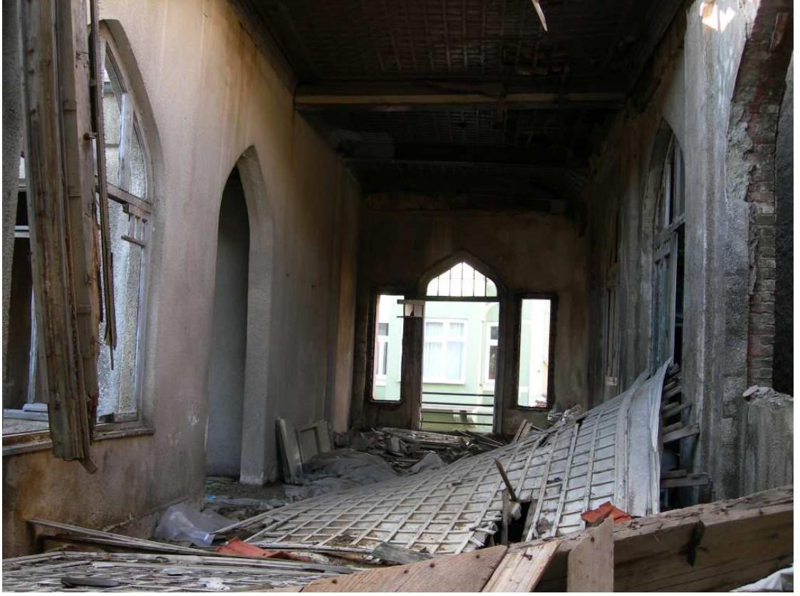
Şekil C.129. BK15; salonun güney duvarı
