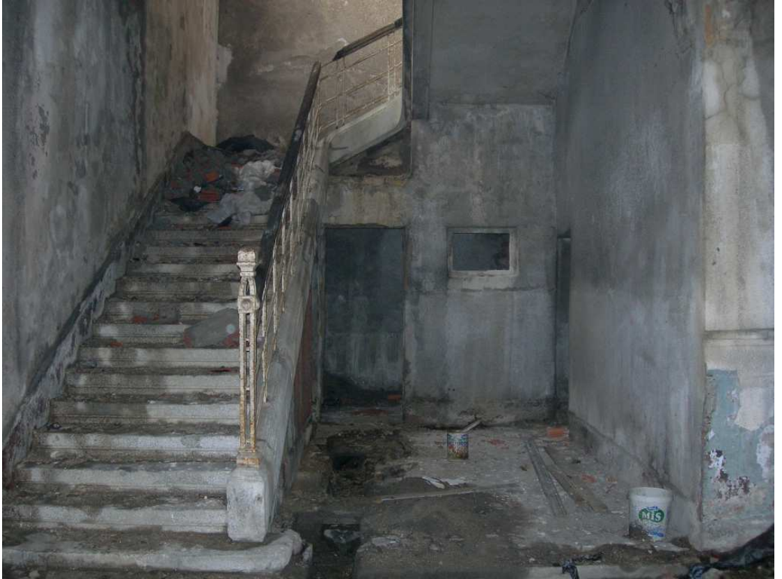
Şekil C.45. ZK12; merdiven holü
