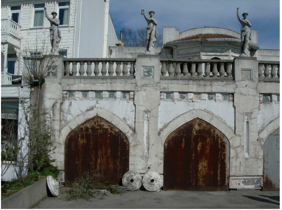
Şekil C.145. Doğu cephesi, heykeller
