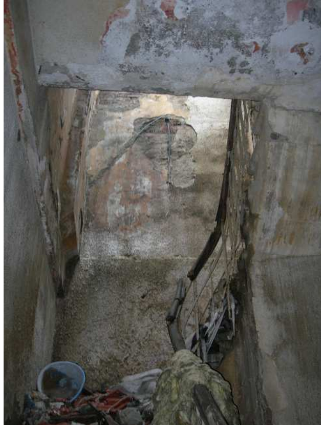
Şekil C.67. ZK21; merdiven holündeki yarım dönel merdiven
