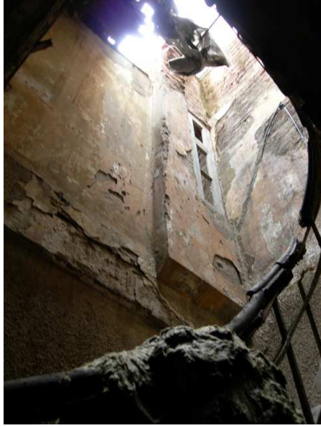
Şekil C.68. ZK21; merdiven holündeki yarım dönel merdiven
