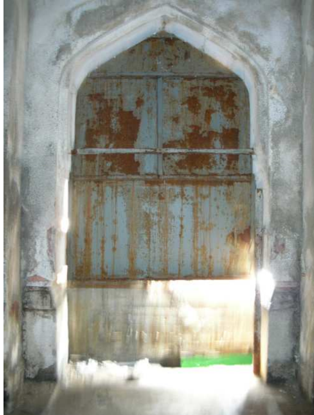
Şekil C.83. ZK28; yolcu çıkış holündeki ZKA07 kapısı
