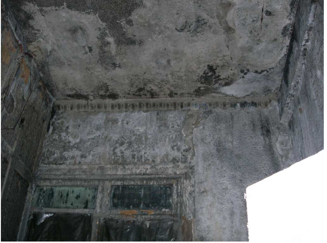
Şekil C.40. ZK10; memur odasının tavanındaki mukarnalı koltuk silmesi
