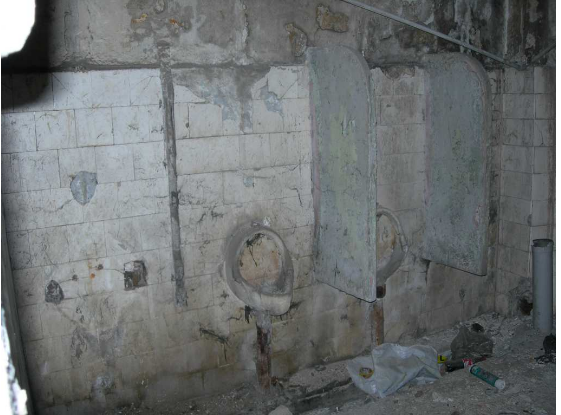
Şekil C.49. ZK16; WC' nin güney duvarı üzerindeki pisuar bölmeleri
