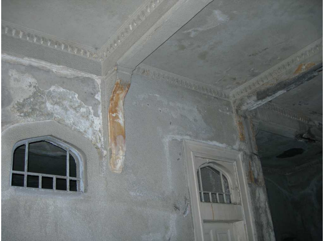
Şekil C.13. ZK02; güney duvarı üzerindeki ZPA03 penceresi ve ZKC01 kapısı arasındaki alçı konsol
