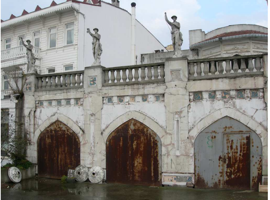
Şekil C.87. BK01; terasta bulunan betonarme heykeller
