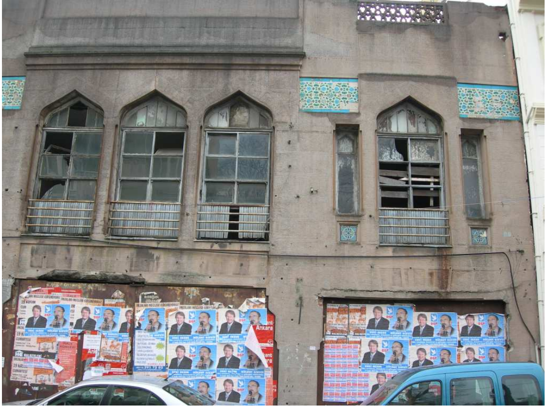
Şekil C.140. Batı cephesi; profilli saçak silmesi
