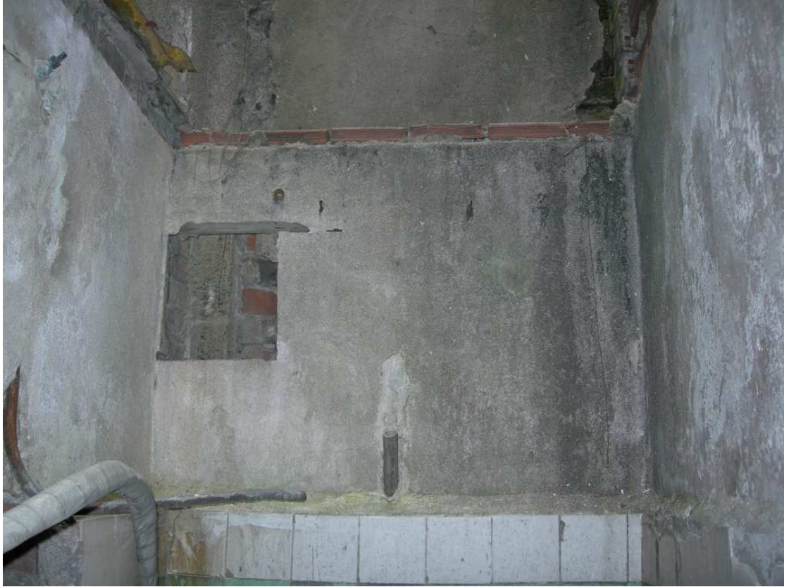
Şekil C.27. ZK07; mekanı güney yönünde sınırlayan duvar
