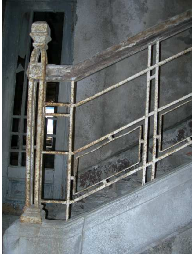
Şekil C.46. ZK12; merdiven holünde bulunan özgün merdivenin ahşap küpeştesi
