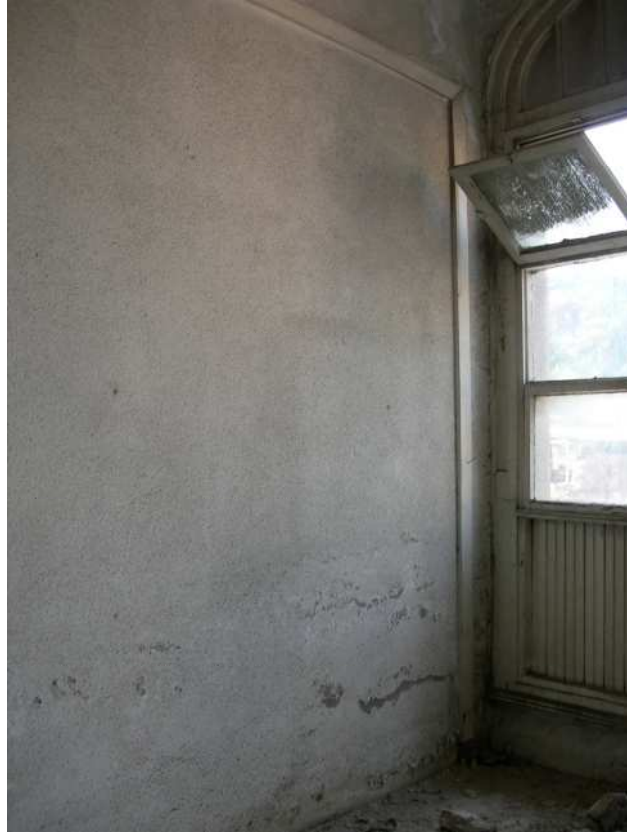
Şekil C.117. BK11; ofisin BPG02 penceresi ve güney duvarındaki doğrama izi
