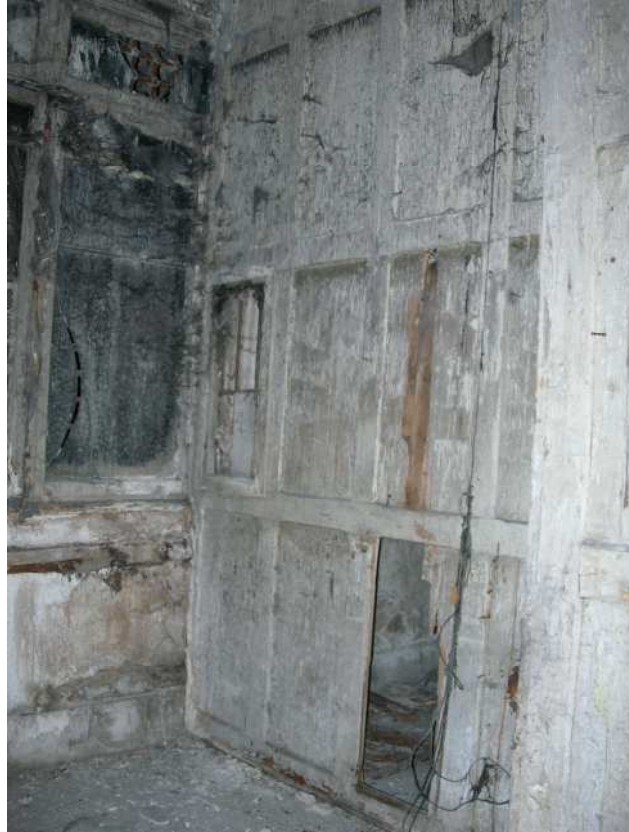
Şekil C.35. ZK09; memur odasında ZPB01 penceresi ve ahşap bölme
