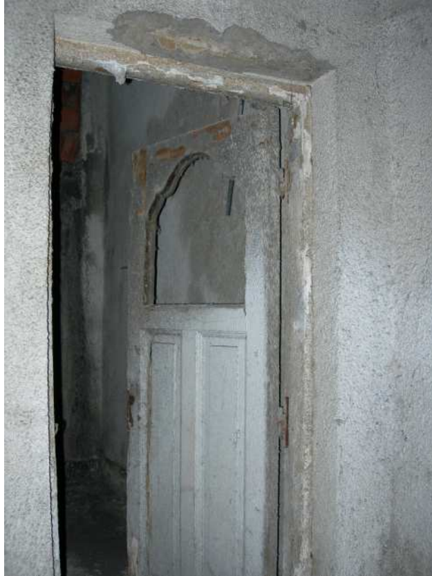
Şekil C.21. ZK05; doğu duvarı üzerinde ZK08 mekanına giriş kapısı ZKD02
