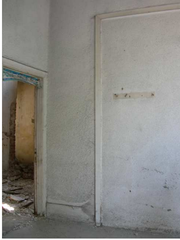
Şekil C.116. BK11; ofisin BKE03 kapısı ve güney duvarındaki ahşap doğrama izi
