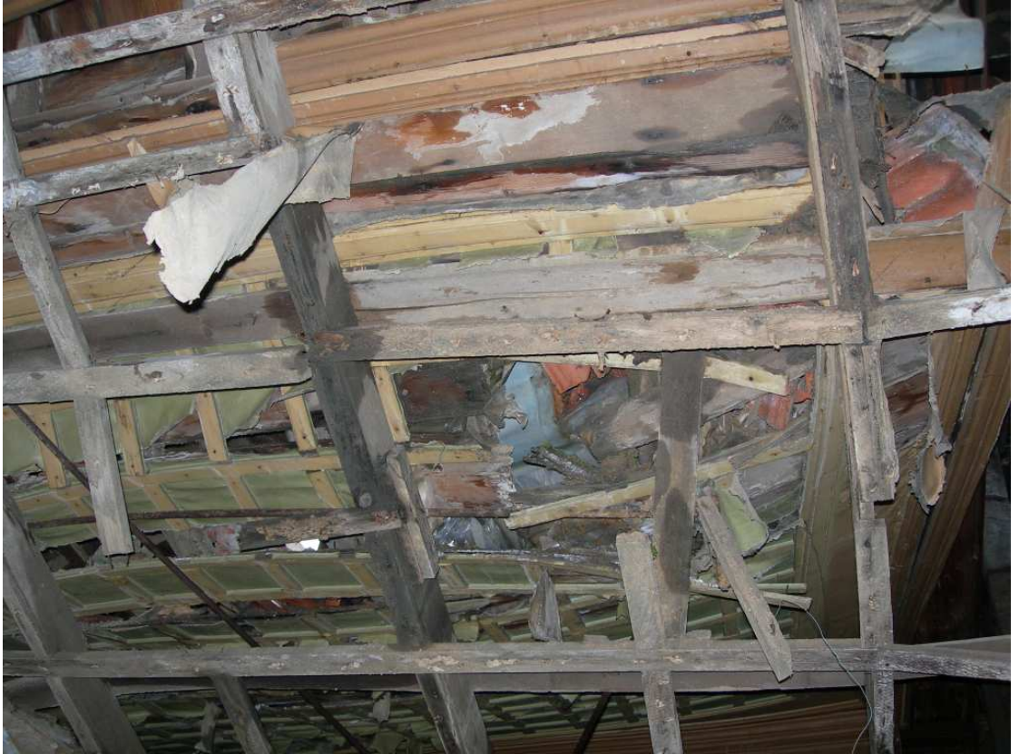
Şekil C.107. BK07; holün ahşap çıtalı özgün tavanı
