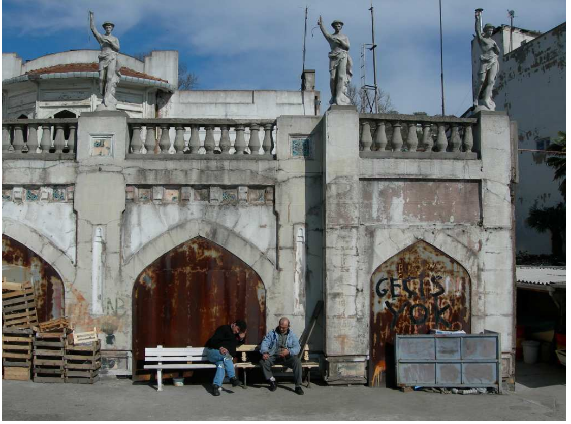
Şekil C.147. Doğu cephesi; betonarme korkuluk ve heykeller
