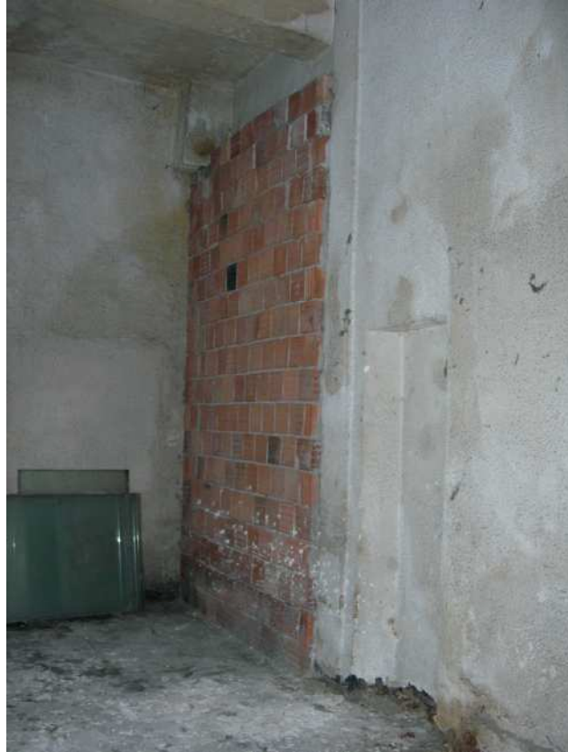
Şekil C.79. ZK27; dükkanın doğu duvarındaki kapı ZKO01
