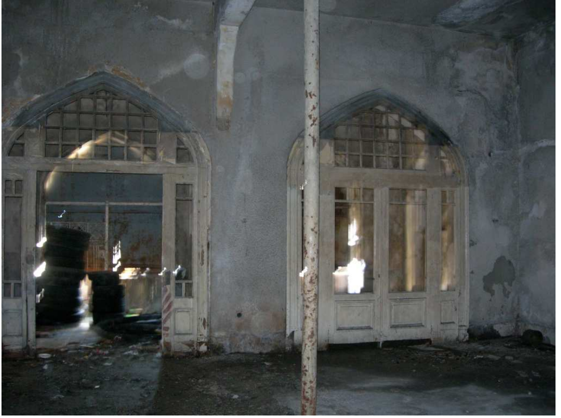
Şekil C.16. ZK03; mekanın ortasındaki sonradan eklenmiş çelik kolon
