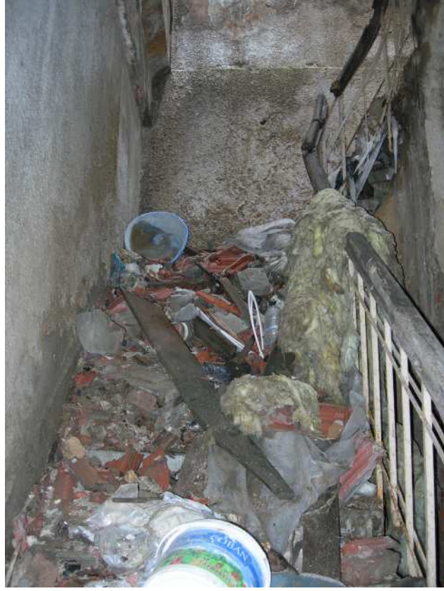
Şekil C.66. ZK21; merdiven holündeki yarım dönel merdiven
