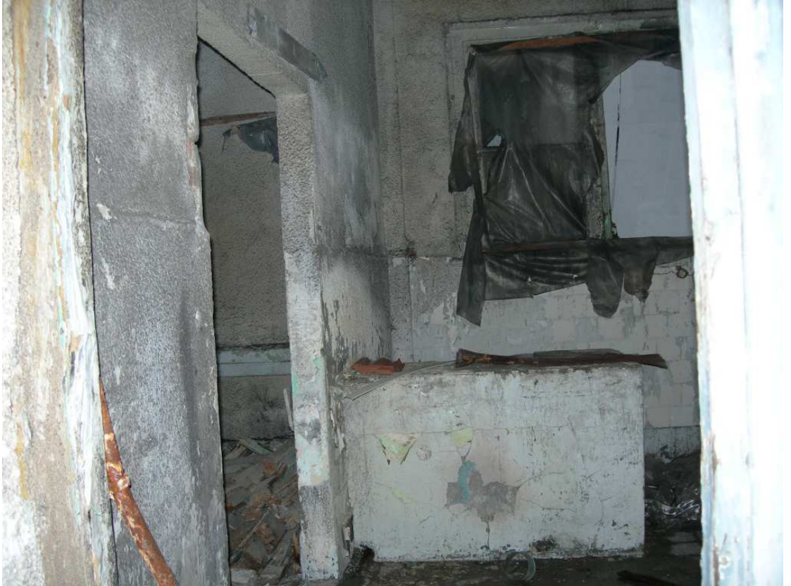
Şekil C.63. ZK20; dükkanda taş tezgah ve sonradan açılmış ZKJ01 kapısı
