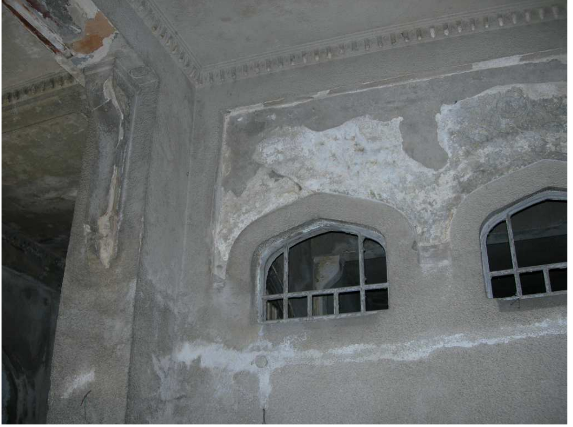
Şekil C.10. ZK02; holdeki kiriş ve alçı konsol
