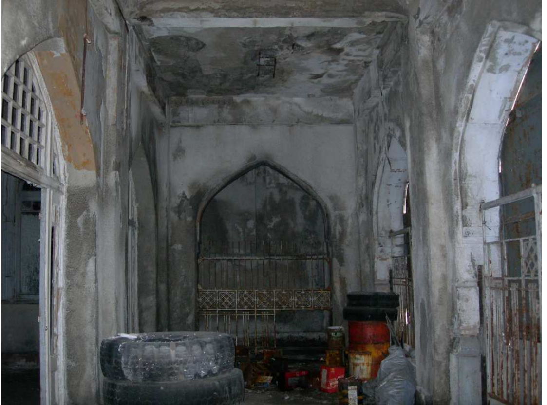
Şekil C.9. ZK01; kuzey duvarı
