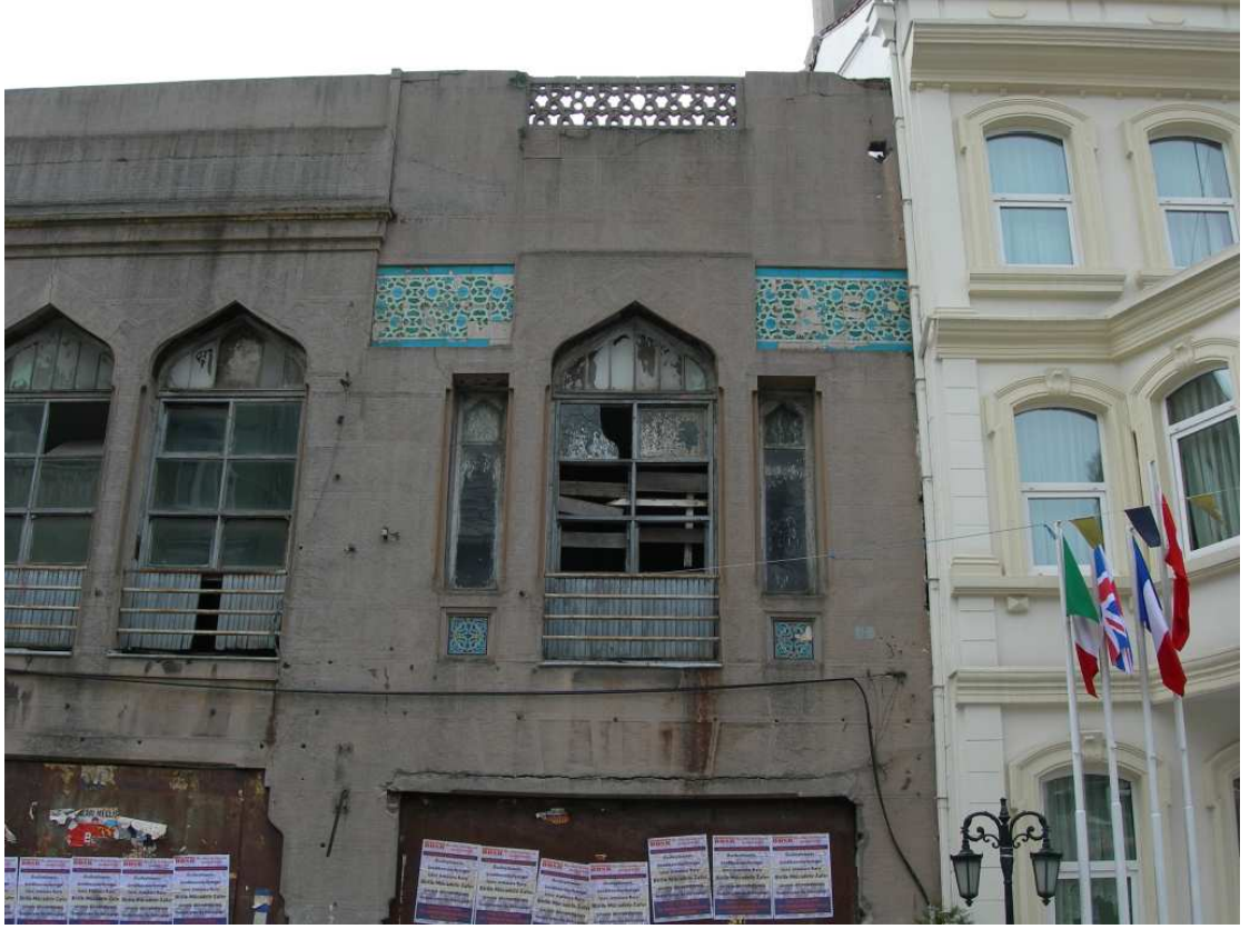
Şekil C.143. Batı cephesi; çini levhalardan görünüş
