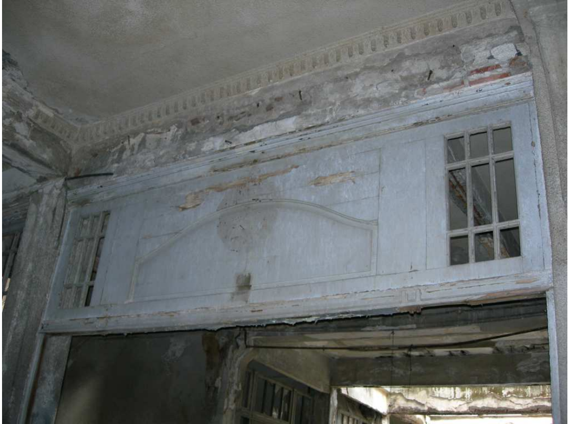
Şekil C.23. ZK05; ZKG01 özgün ahşap kapısının mevcut tepe penceresi
