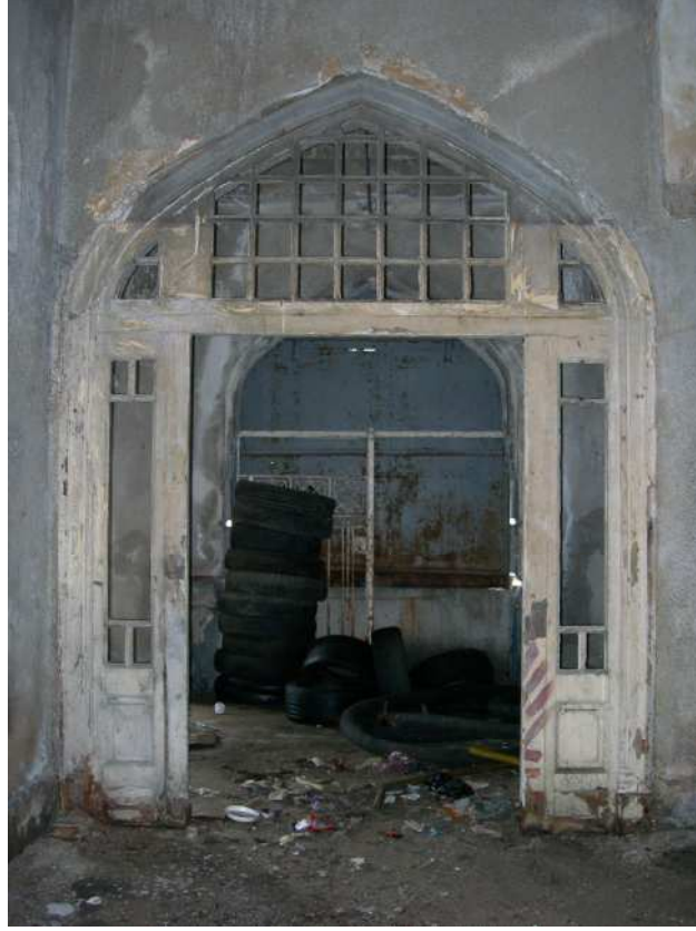
Şekil C.18. ZK04; doğu duvarı üzerindeki özgün ahşap ZKB04 kapısı
