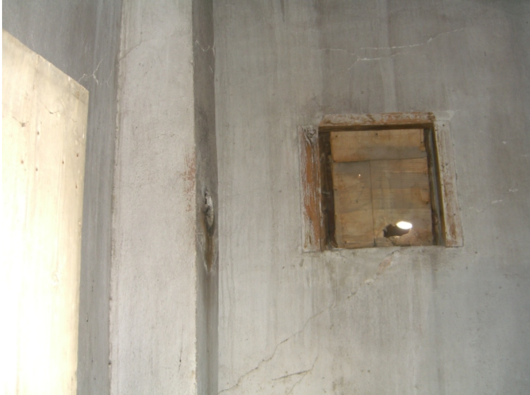
Şekil A.111: 108 mekânının güney duvarındaki pencere
