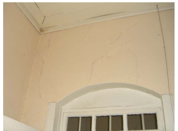
Şekil A.51: Z06 mekânının duvarlarındaki boya dökülmesi ve çatlaklar
