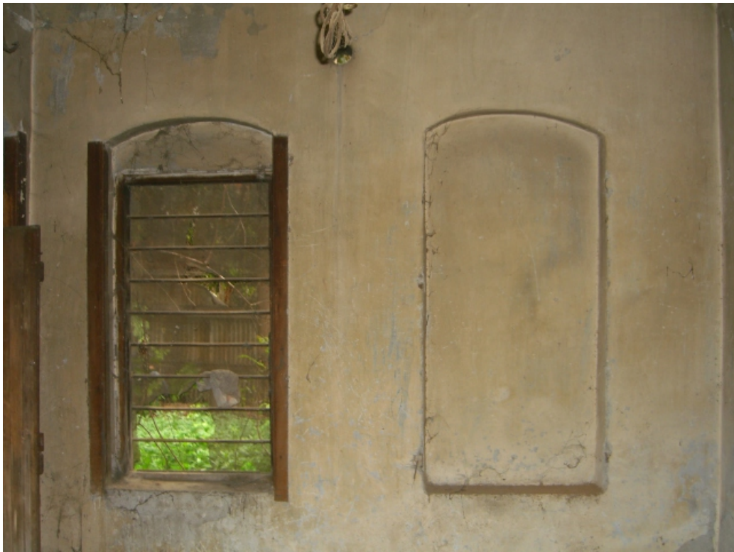
Şekil A.67: Z10 mekânının güney duvarındaki pencereler
