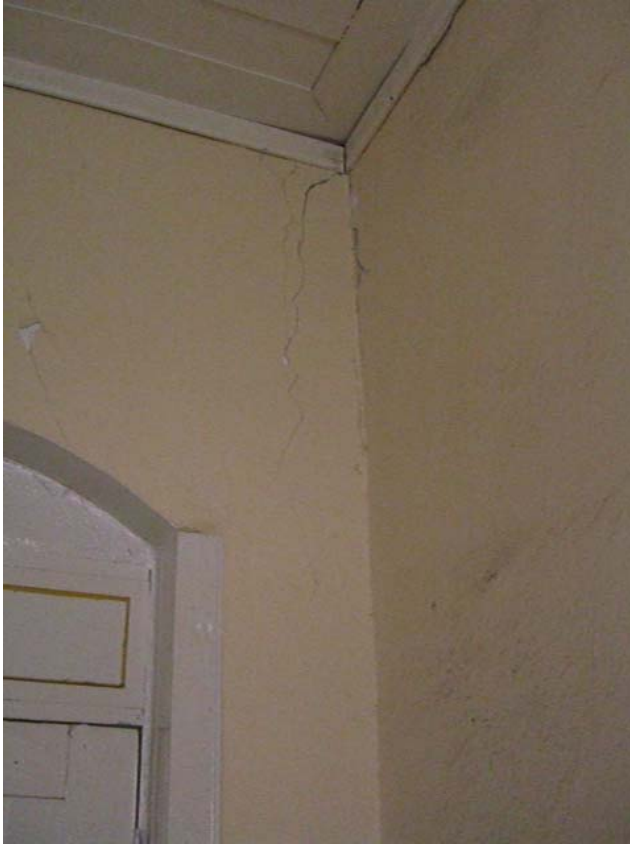
Şekil A.45: Z04 mekânının tavanı
