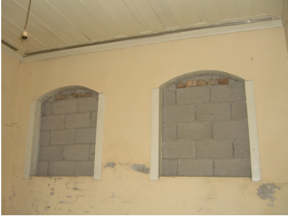
Şekil A.40: Z04 mekânının doğu duvarındaki pencereler
