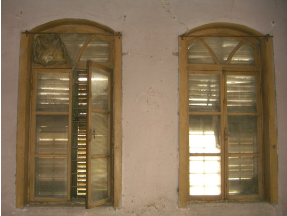
Şekil A.97: 105 mekânının doğu duvarındaki pencereler
