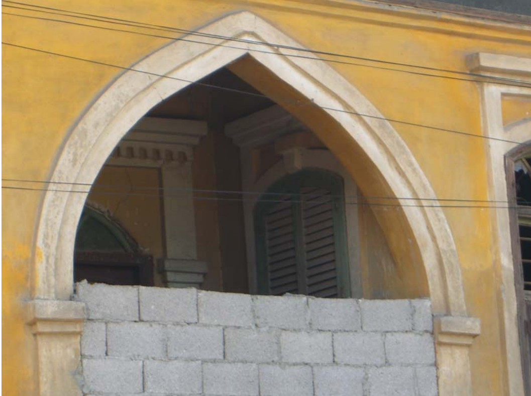
Şekil A.123: Yapının doğu cephesindeki sivri kemer ve niş şeklinde içeri doğru çekilmiş giriş mekânı
