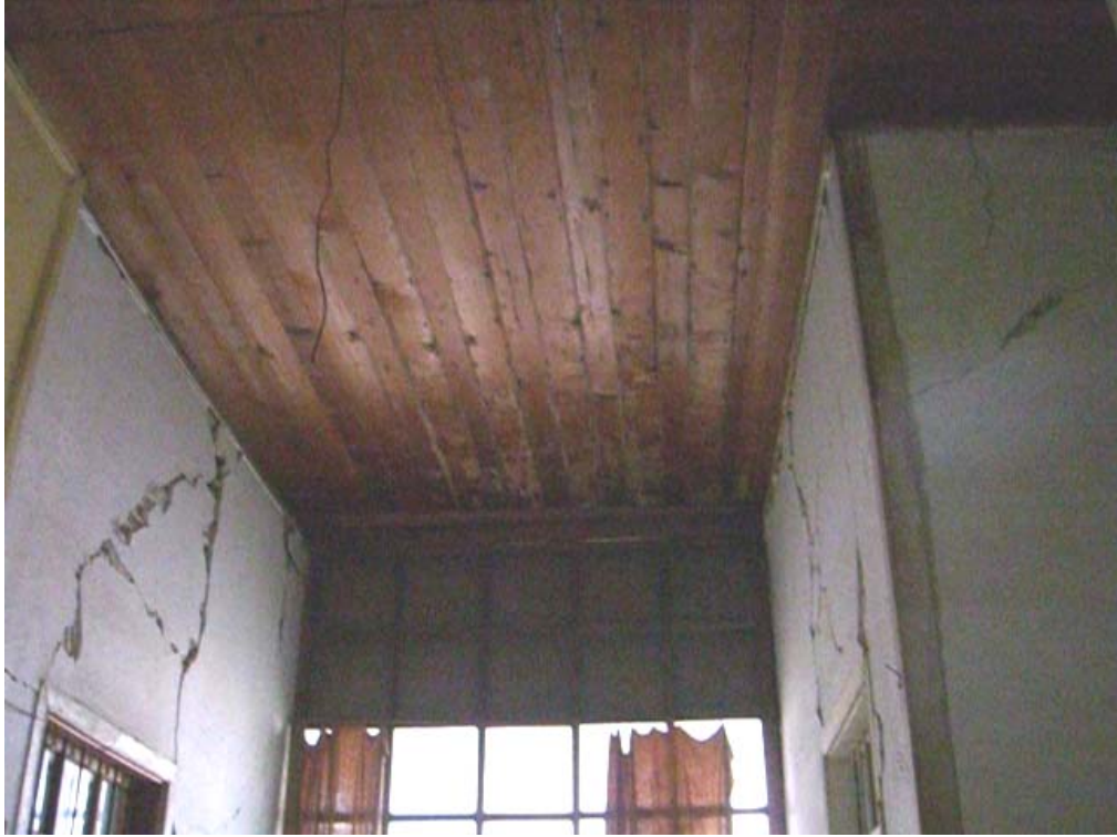
Şekil A.77: 101 mekânının tavanı
