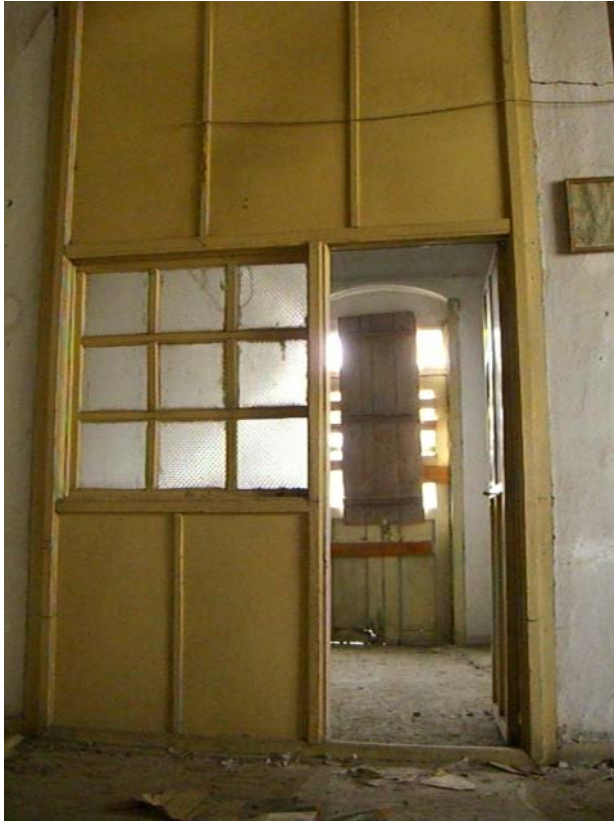
Şekil A.101: 106 mekânının giriş kapısının da içinde yer aldığı ahşap bölücü
