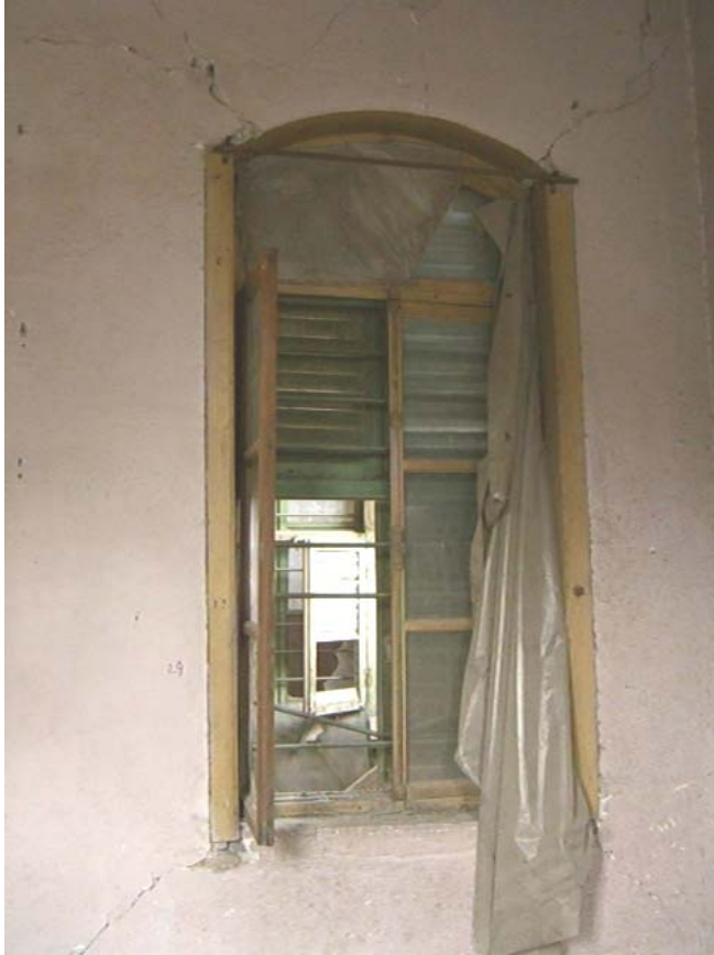
Şekil A.99: 105 mekânının kuzey duvarındaki pencere
