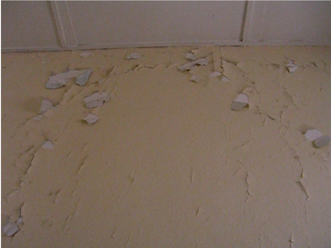
Şekil A.27: Z01 mekânının giriş holü bölümünün batı duvarı ve tavan kaplaması
