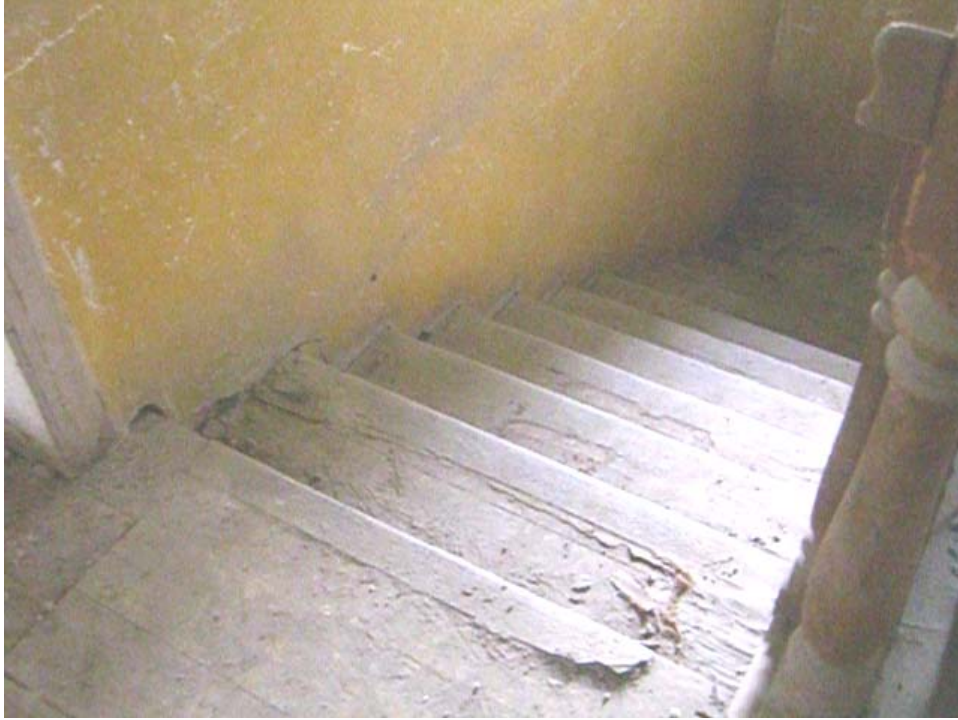
Şekil A.85: 103 mekânındaki ahşap merdiven
