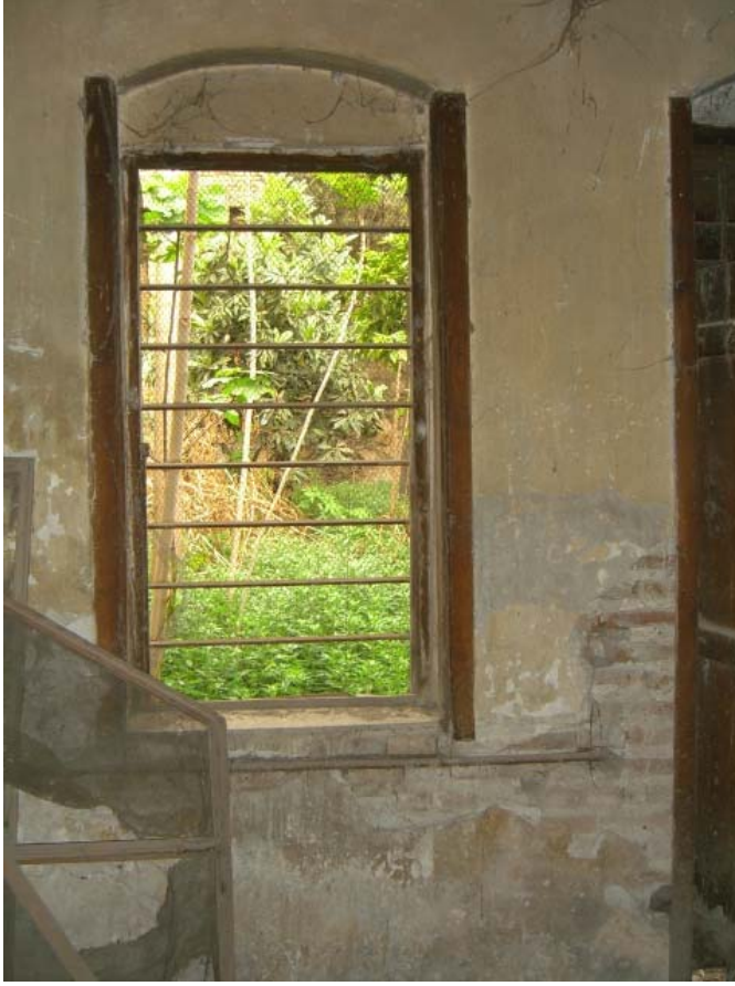
Şekil A.68: Z10 mekânının doğu duvarındaki pencere
