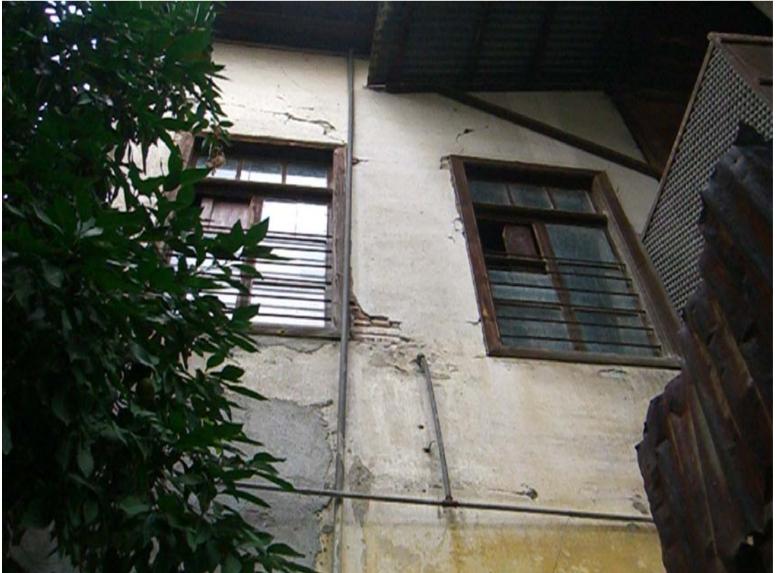
Şekil A.135: 102 (mutfak) mekânının batı yönündeki pencereler
