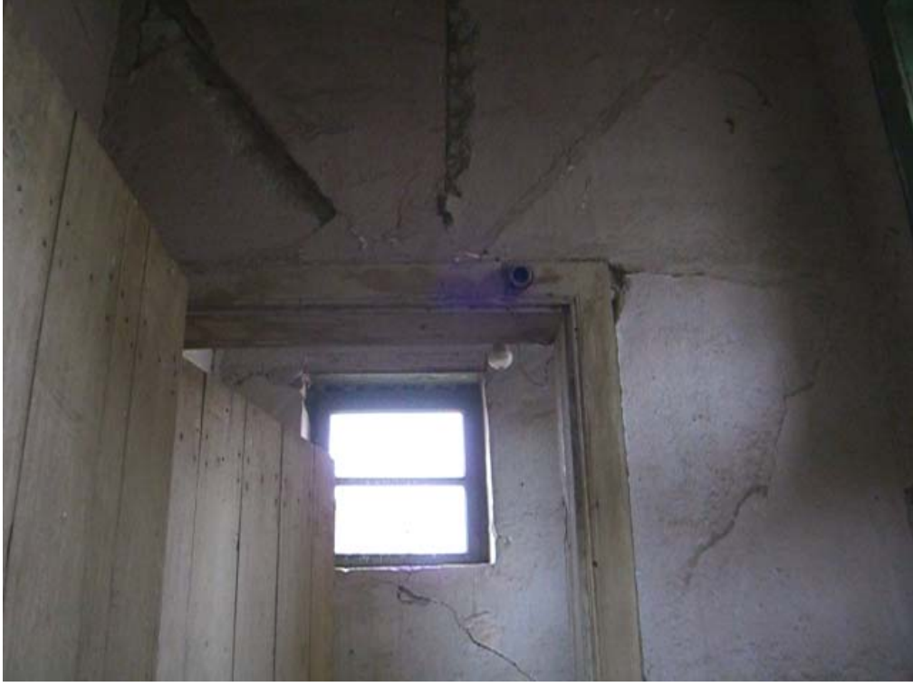
Şekil A.118: 109 mekânının güney duvarında yer alan pencere
