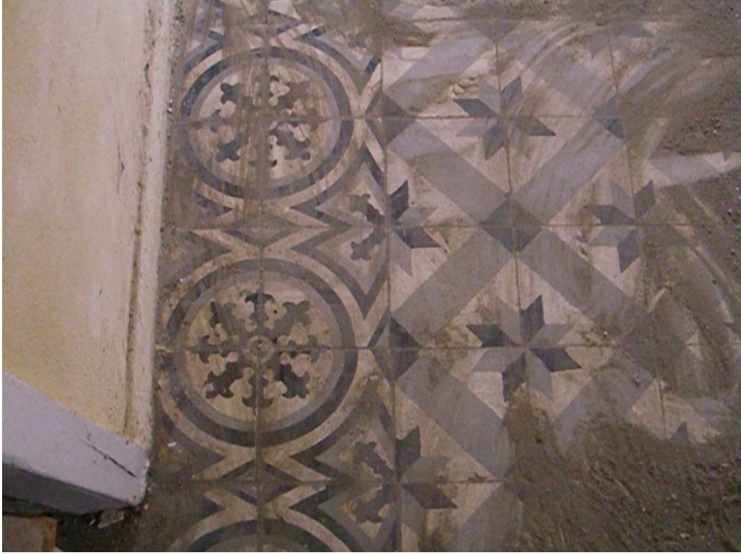
Şekil A.26: Z01 mekânının döşeme malzemesi olarak karosiman
