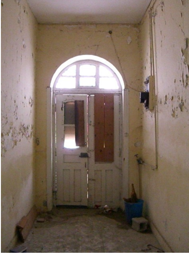
Şekil A.24: Zemin kat ana giriş kapısının içten görünümü
