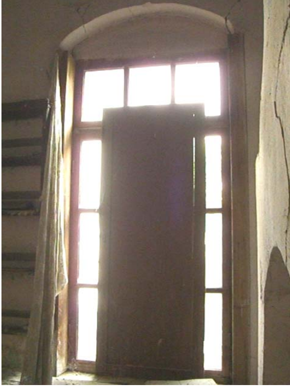
Şekil A.80: 102 mekânının batı duvarındaki pencere (kuzey duvarına yakın)
