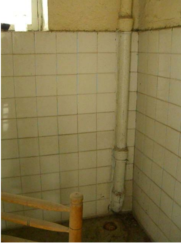
Şekil A.58: Z08 mekânının duvarları
