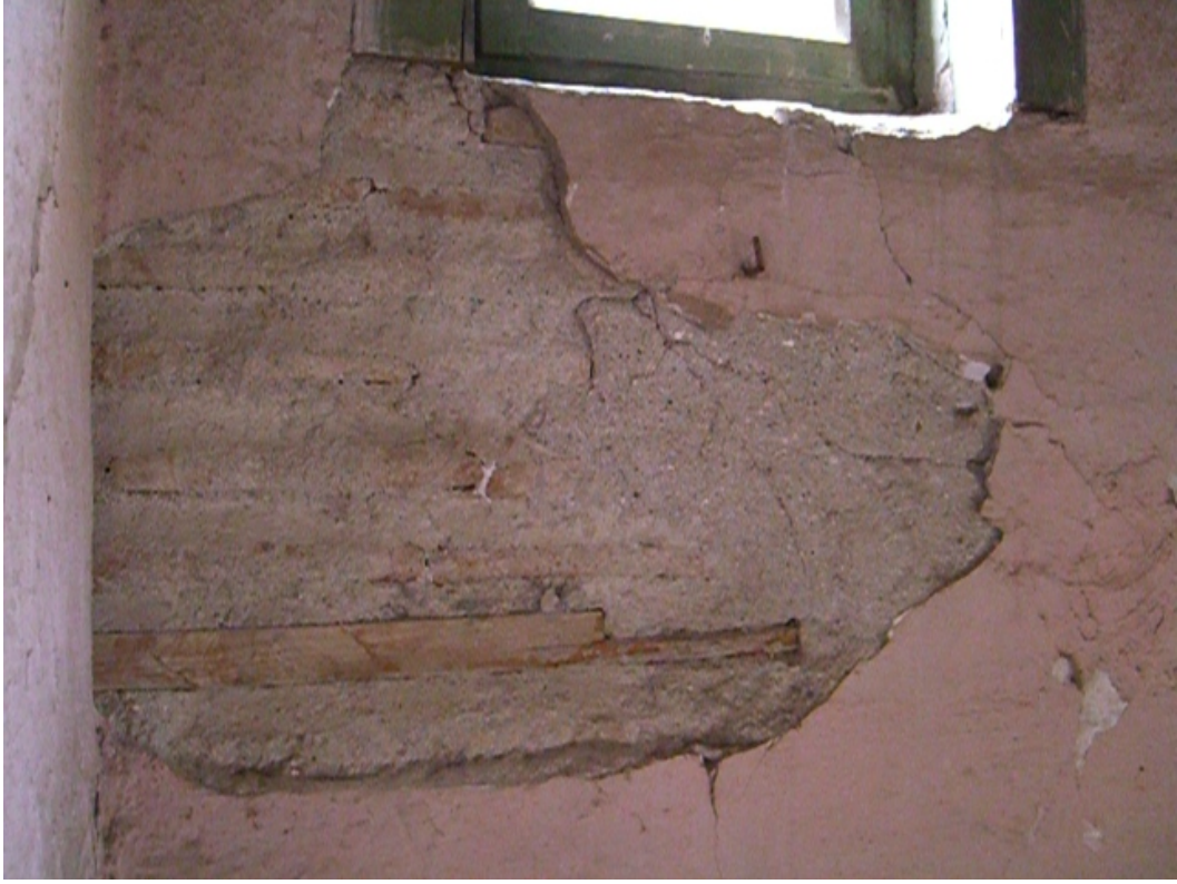
Şekil A.150: 109 mekânının batı duvarında görülen ahşaplar
