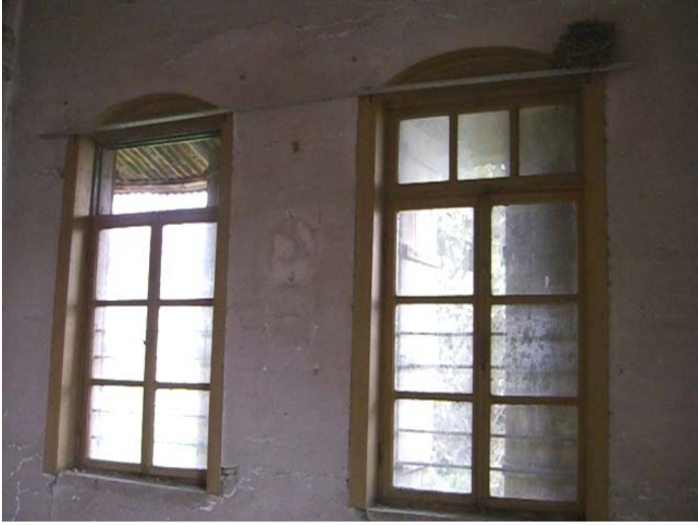
Şekil A.92: 104 mekânının kuzey duvarındaki pencereler
