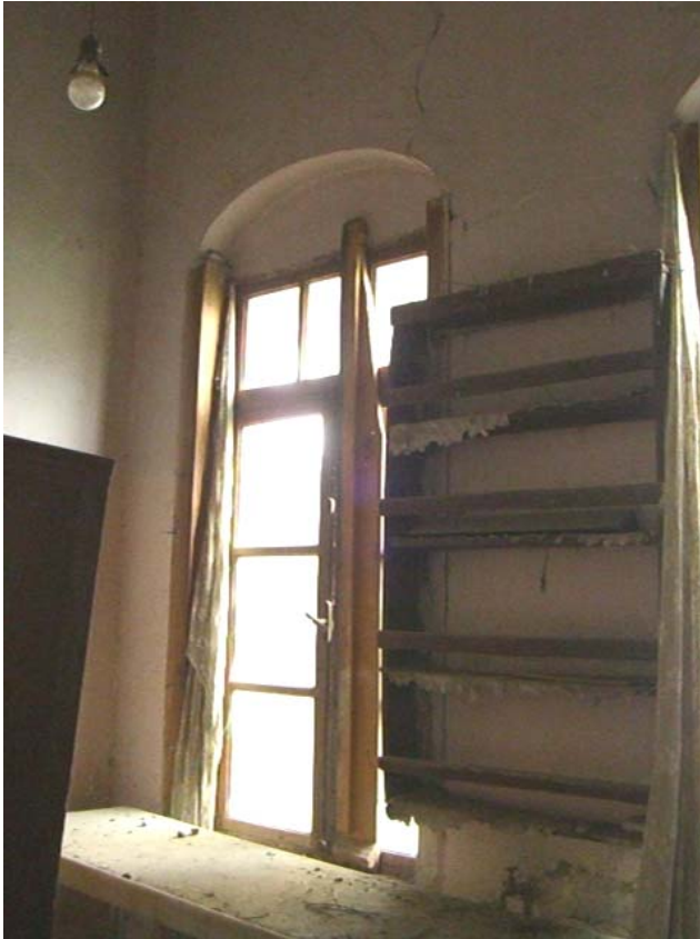
Şekil A.79: 102 mekânının batı duvarındaki pencere (güney duvarına yakın)
