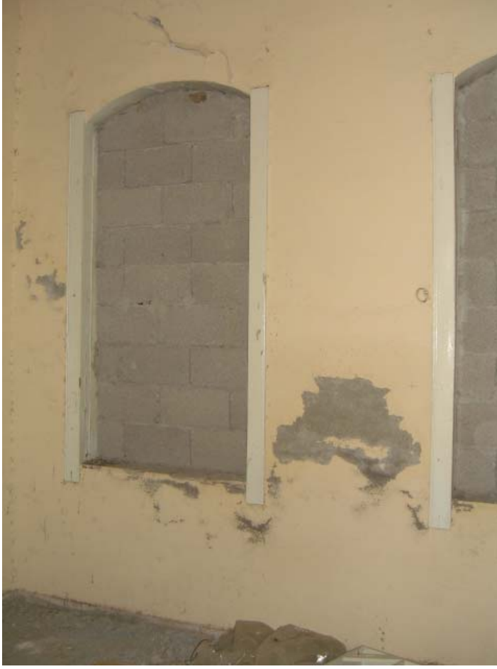
Şekil A.50: Z06 mekânının güney duvarındaki pencereler
