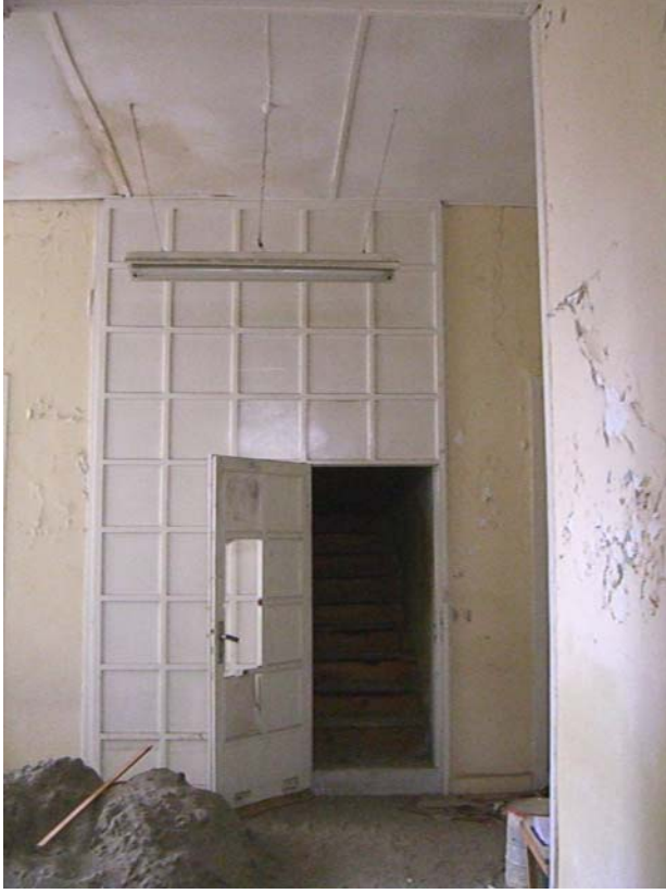
Şekil A.38: Z03 mekânının güney yönüne sonradan eklenmiş olan ahşap bölücü
