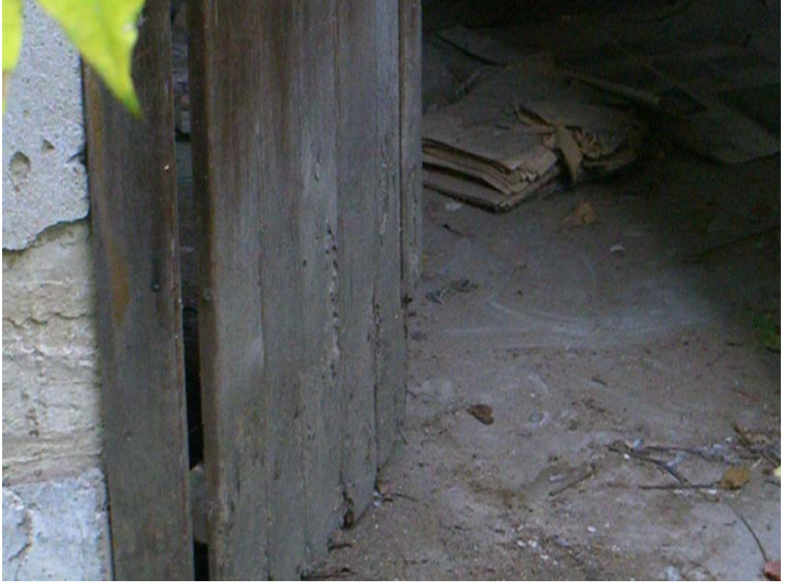
Şekil A.146: Z10 mekânının zemini (şap)
