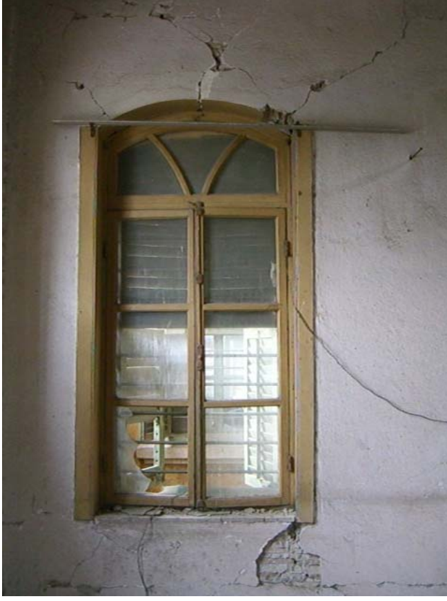
Şekil A.94: 104 mekânının güney duvarındaki pencere
