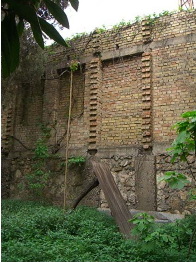
Şekil A.71: Z11 mekânının doğu yönündeki duvarlar
