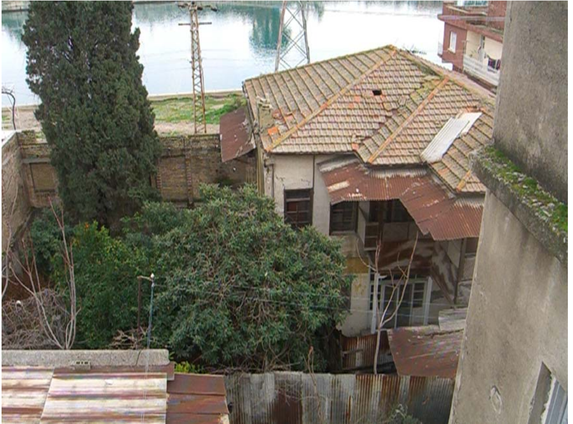
Şekil A.137: Dr. S. Haluk Uygur Evi'nin batı cephesi kısmi görünümü
