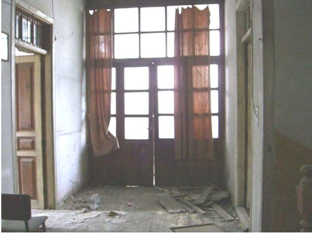
Şekil A.76: 101 mekânını balkona bağlayan dört kanatlı ahşap kapı
