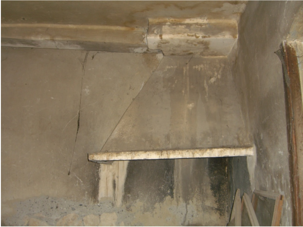
Şekil A.69: Z10 mekânının kuzeydoğu köşesinde yer alan davlumbaz
