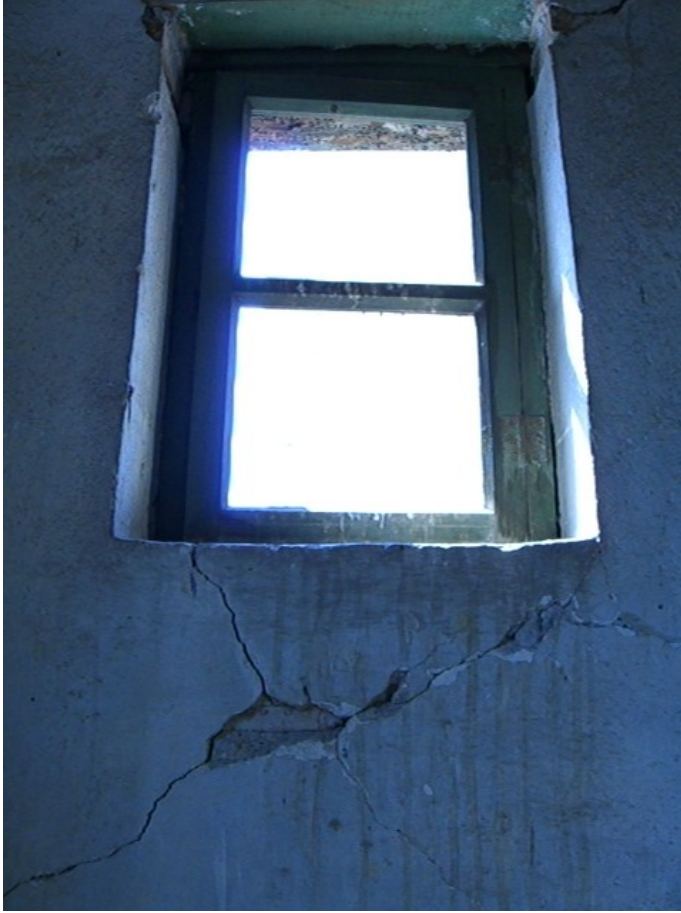
Şekil A.119: 109 mekânının helâ bölümünün batı duvarındaki pencere
