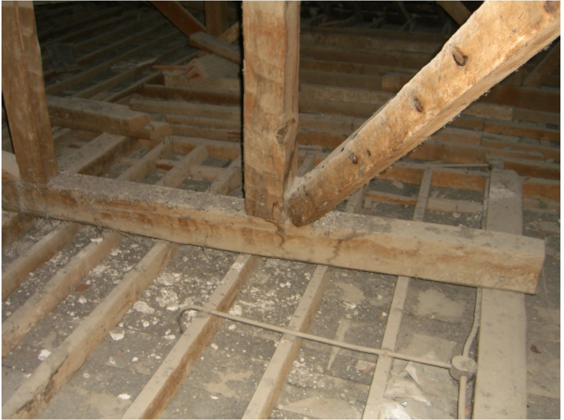
Şekil A.147: Çatı arası mekânında görülen döşeme sistemi
