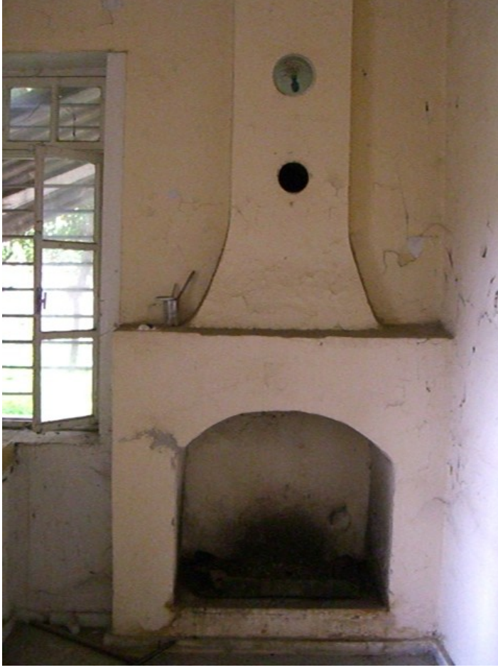
Şekil A.30: Z02 mekânının kuzey duvarında yer alan ocak
