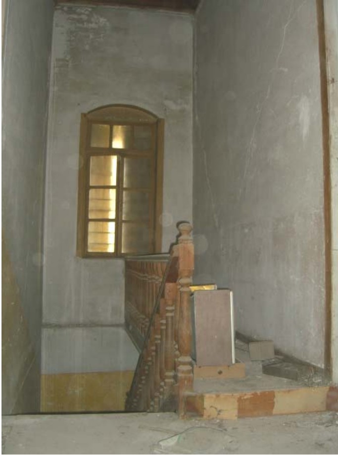
Şekil A.87: 103 mekânının kuzey duvarındaki pencere
