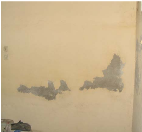
Şekil A.51: Z06 mekânının duvarlarındaki boya dökülmesi ve çatlaklar
