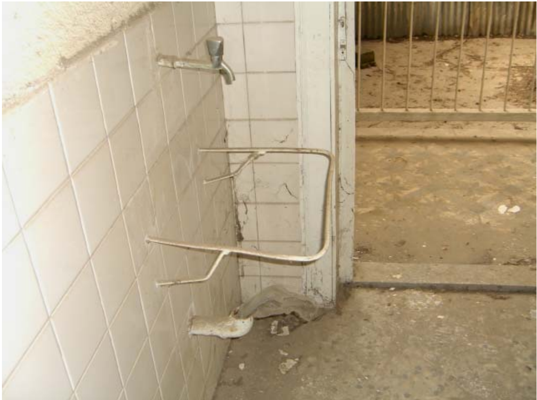
Şekil A.63: Z09 mekânının duvarları
