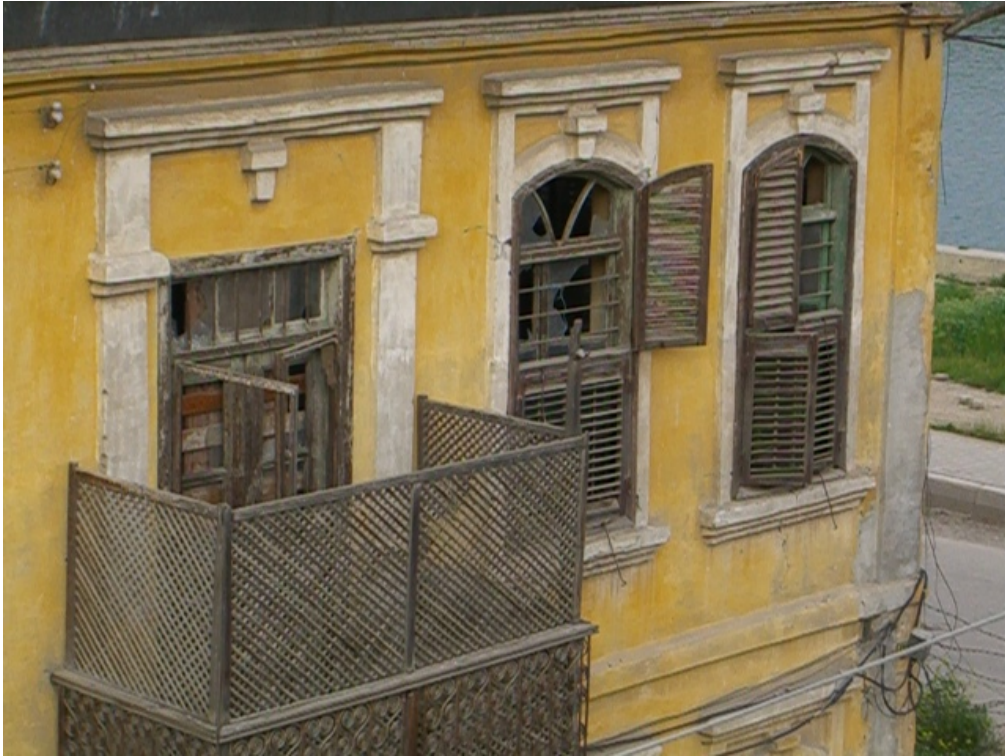
Şekil A.131: 106 mekânının güney yönündeki balkon kapısı
