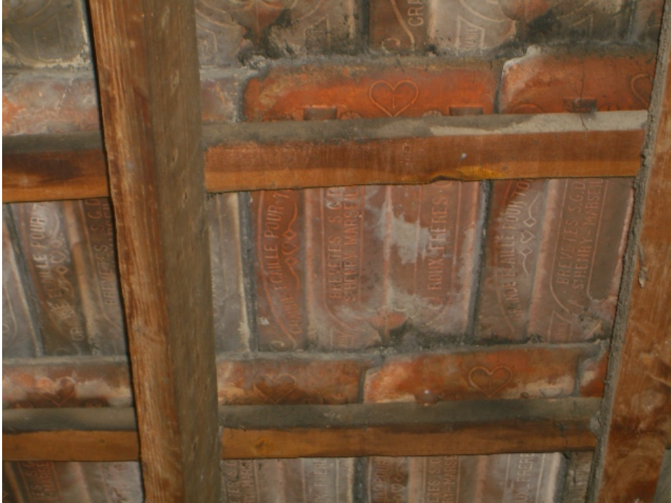
Şekil A.149: Çatıda kullanılan -özgün- Marsilya kiremitlerinin yerleştirilme şekli
