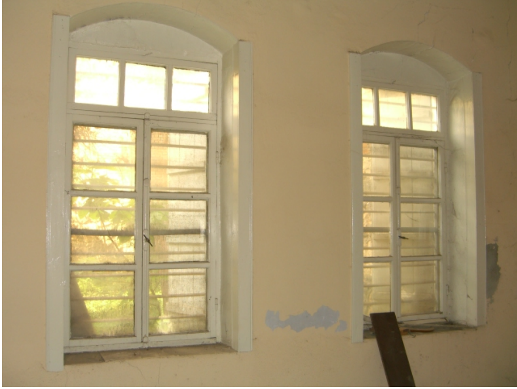
Şekil A.42: Z04 mekânının kuzey duvarındaki pencereler
