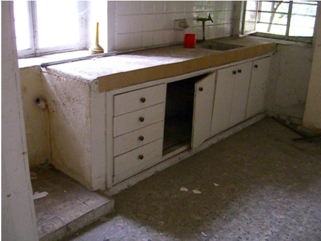
Şekil A.29: Z02 mekânının batı ve kuzey duvarlarında yer alan pencereler
