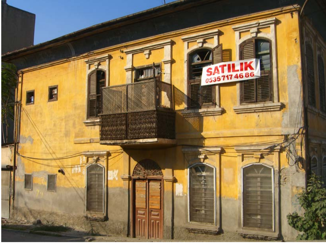
Şekil A.22: Dr. S. Haluk Uygur Evi'nin güney cephesi ve zemin kata ait ana giriş kapısı
