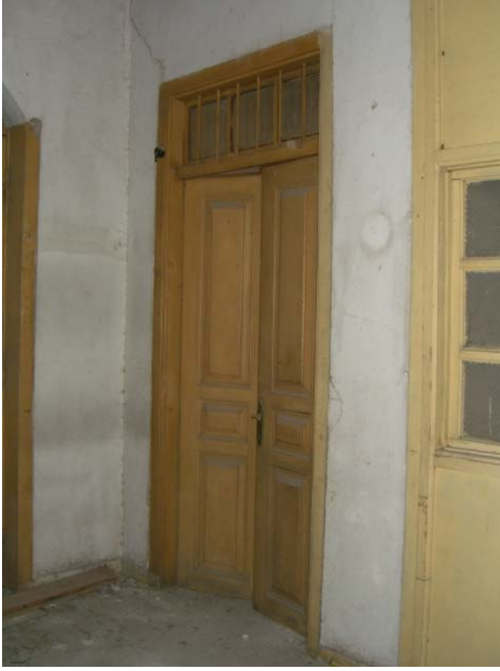
Şekil A.96: 105 mekânının giriş kapısı
