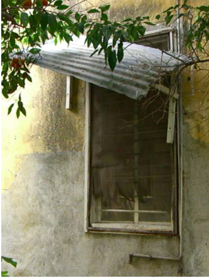
Şekil A.139: Z02 (mutfak) mekânının kuzey yönündeki penceresi
