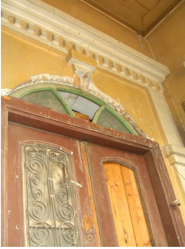
Şekil A.74: Birinci kat ana giriş kapısı
