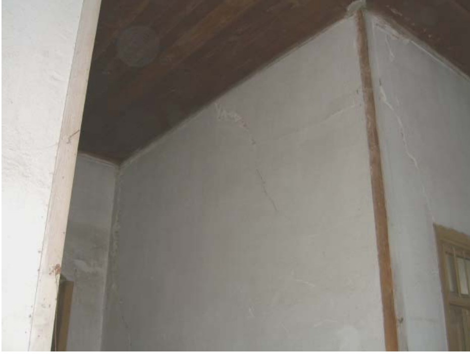
Şekil A.90: 103 mekânının tavanı
