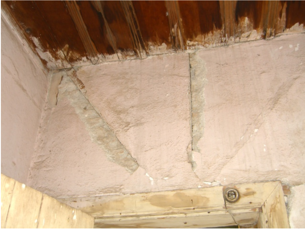
Şekil A.145: 109 mekânını ikiye bölen iç duvarın yapısı (ahşap karkas + tuğla dolgu)
