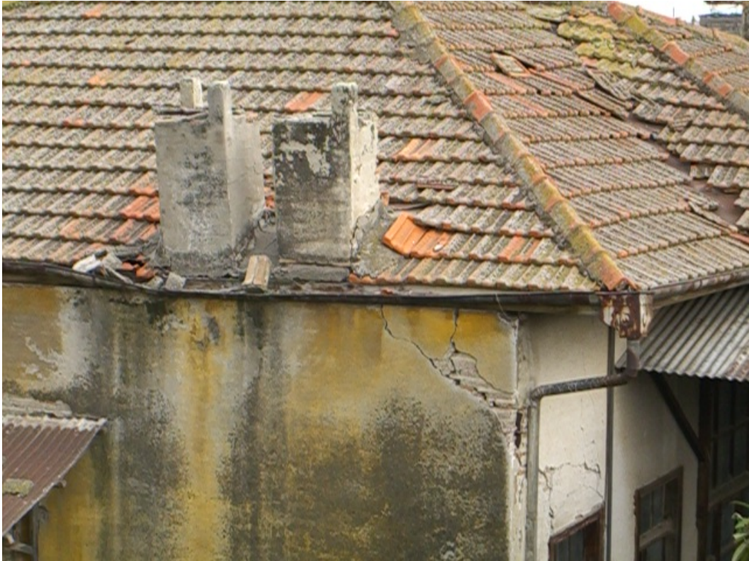
Şekil A.143: Kuzey cephesinden görülebilen bacalar
