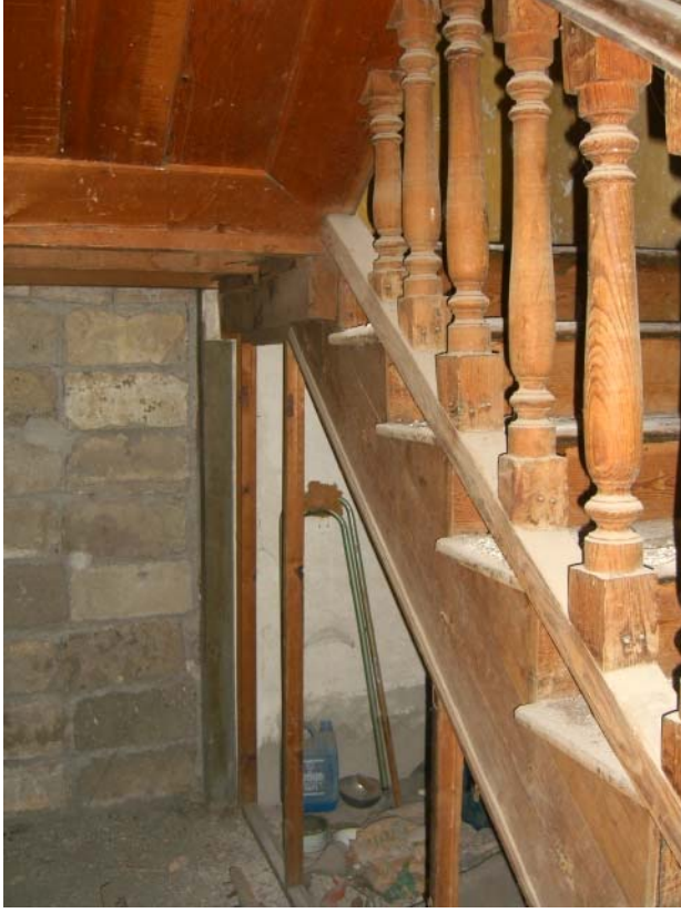
Şekil A.36: Z03 mekânında yer alan -kapatılmış- bahçeye çıkış kapısı
