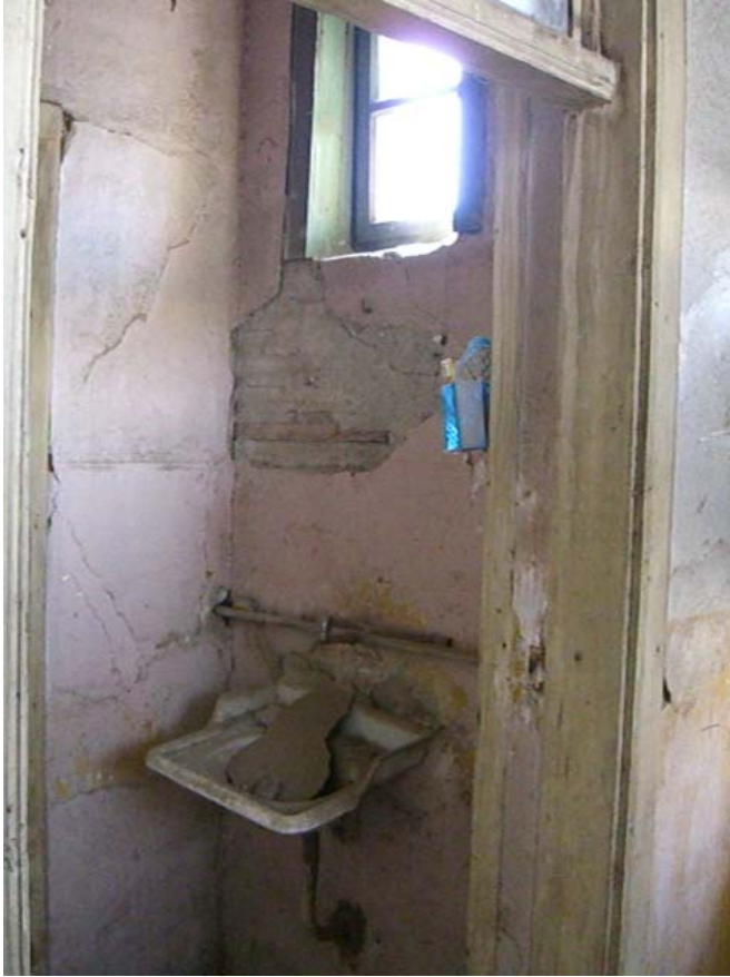
Şekil A.115: 109 mekânının giriş bölümünün batı duvarındaki pencere
