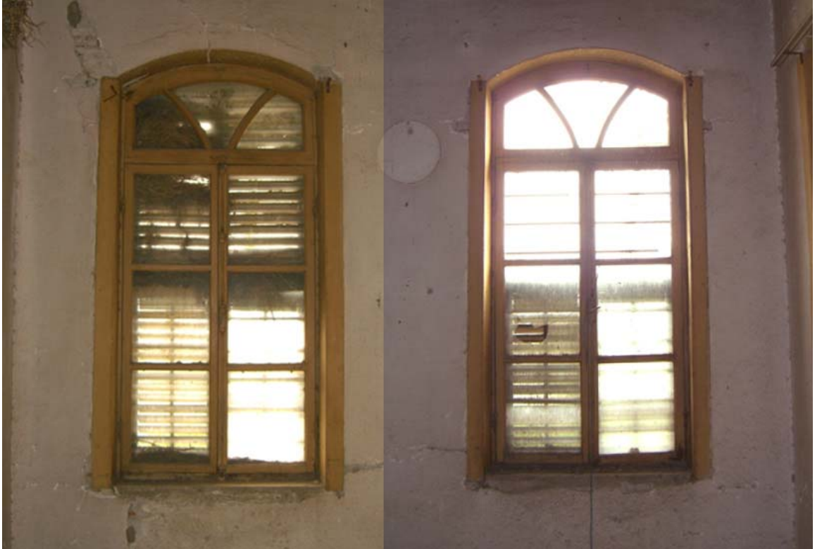
Şekil A.93: 104 mekânının doğu duvarındaki pencereler
