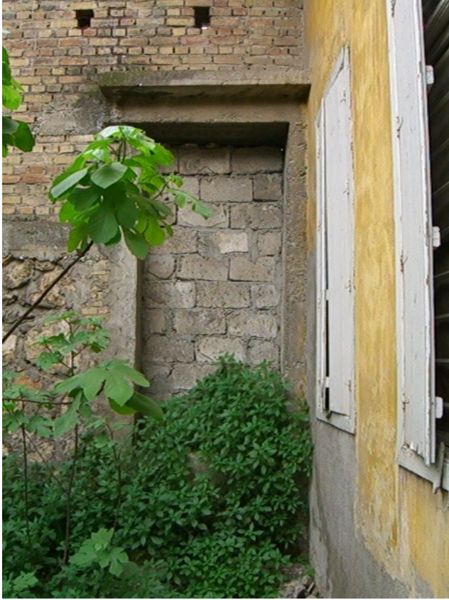
Şekil A.73: Z11 mekânının doğu yönündeki -kapatılmış- bahçe kapısı
