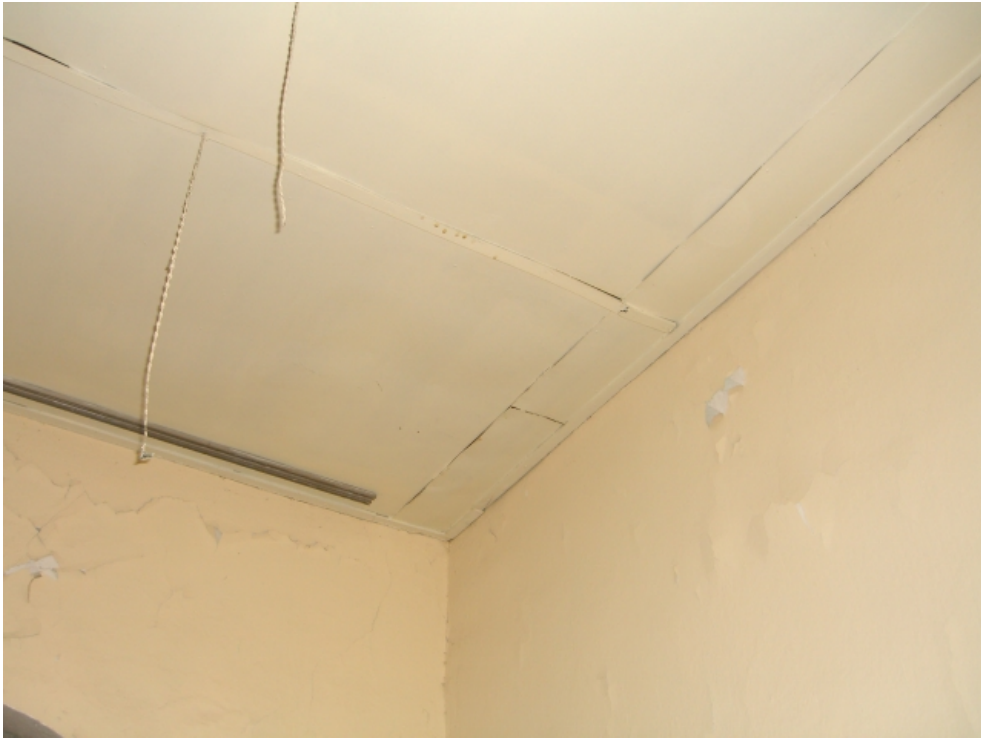
Şekil A.55: Z07 mekânının tavanı
