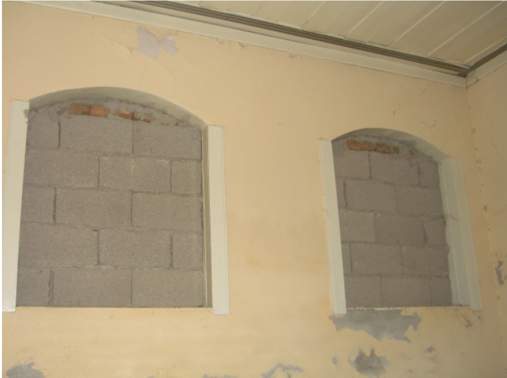
Şekil A.49: Z06 mekânının doğu duvarındaki pencereler
