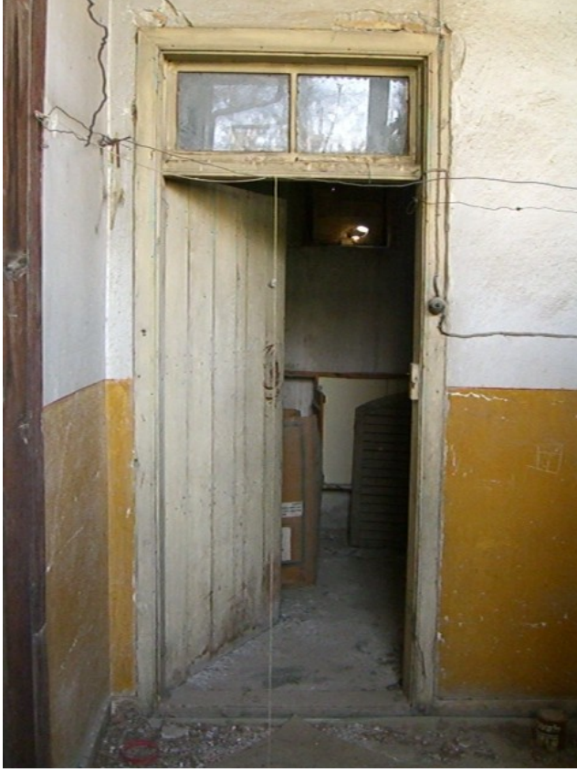
Şekil A.108: 108 mekânının giriş kapısı
