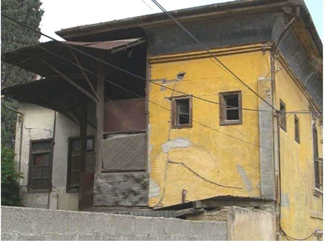
Şekil A.132: Dr. S. Haluk Uygur Evi'nin batı cephesi (8 Sokak'tan görünüm)
