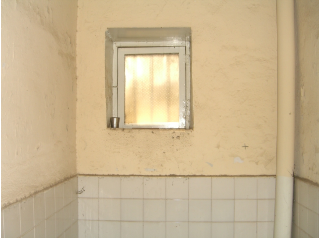
Şekil A.64: Z09 mekânının güney duvarındaki pencere
