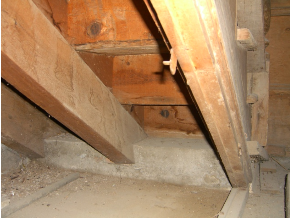
Şekil A.35: Z03 mekânından başlayan ahşap merdivenin ilk basamağı ve taşıyıcıları
