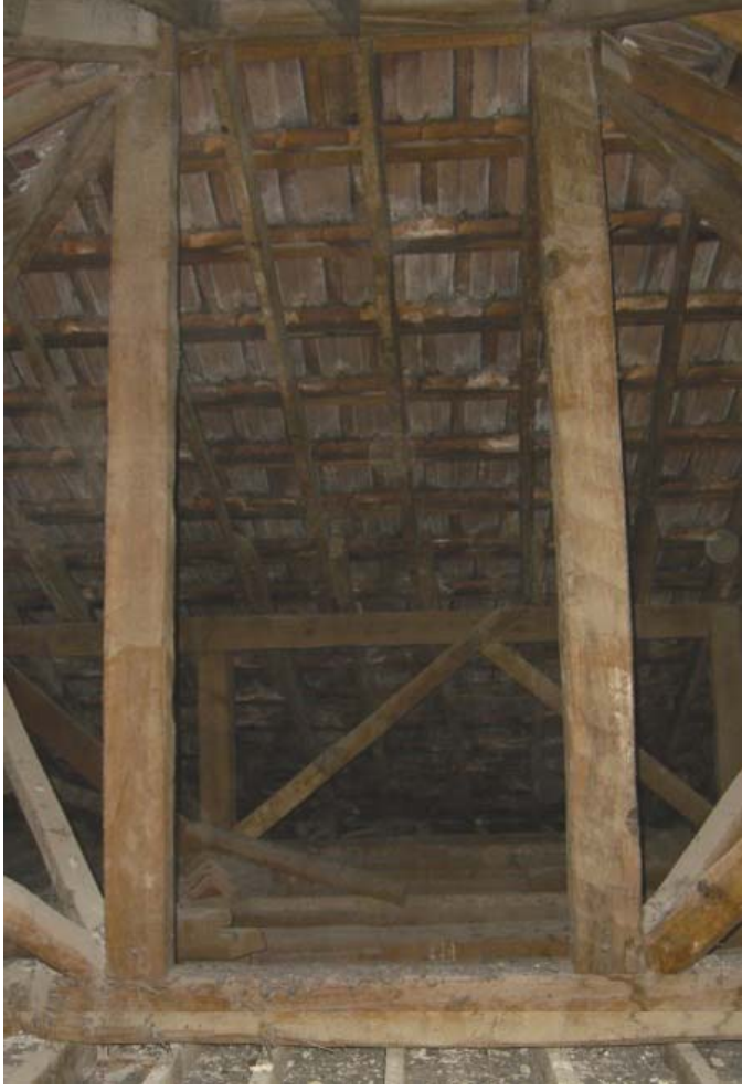
Şekil A.148: Çatının ahşap taşıyıcıları
