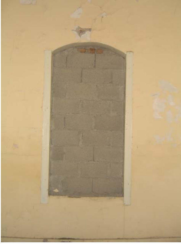
Şekil A.54: Z07 mekânının güney duvarındaki pencere
