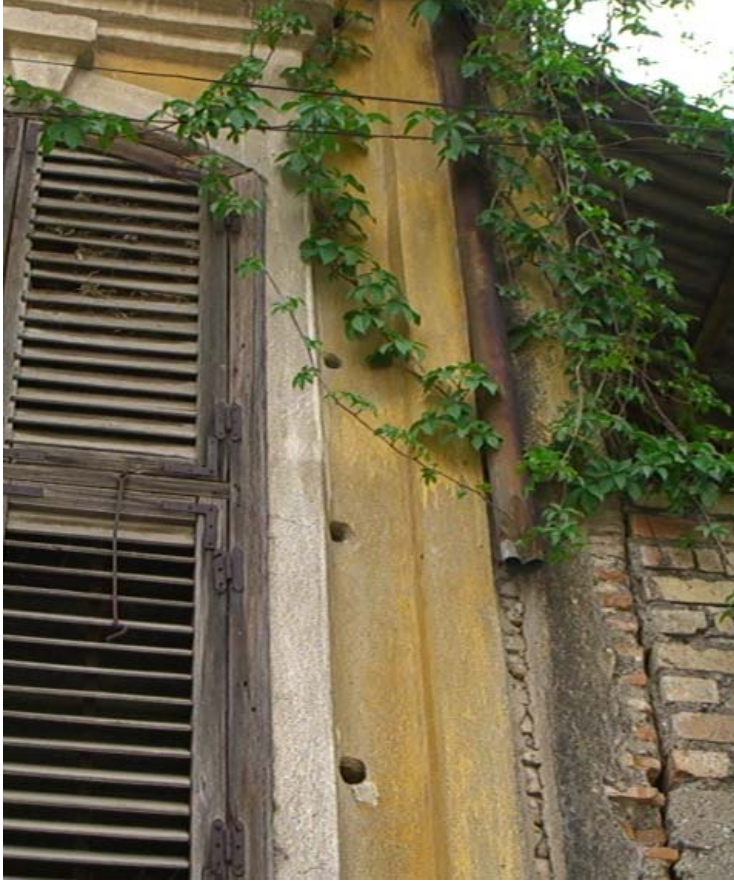
Şekil A.144: Yapıda kullanılan yassı tuğlalar (3 x 24 cm.) ve bahçeyi çevreleyen duvarlarda kullanılan dolu tuğlalar (6 x 21.5 cm.)
