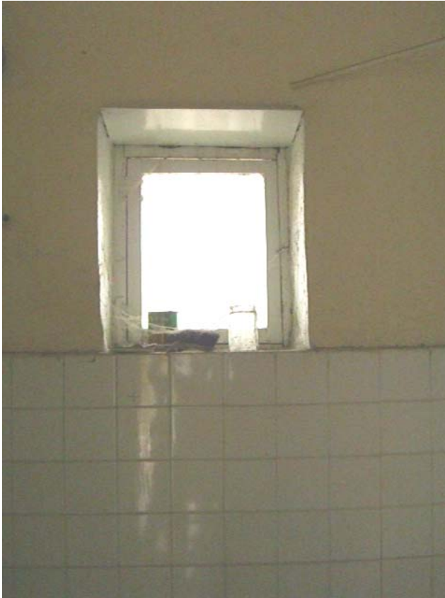
Şekil A.59: Z08 mekânının güney duvarındaki pencere
