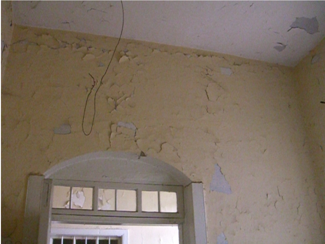
Şekil A.33: Z02 mekânının tavanı
