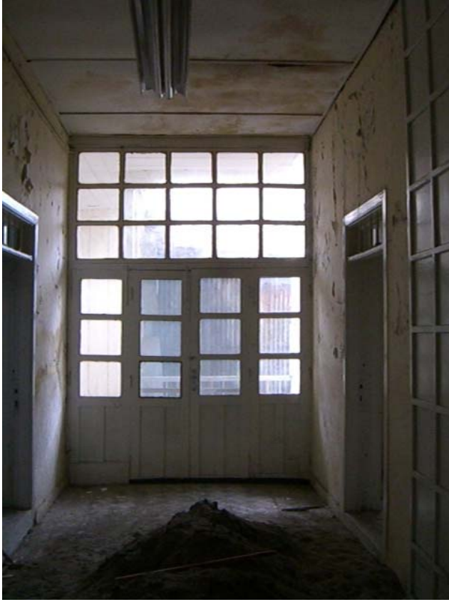
Şekil A.25: Z01 mekânının balkona açılan dört kanatlı ahşap kapısının içten görünümü
