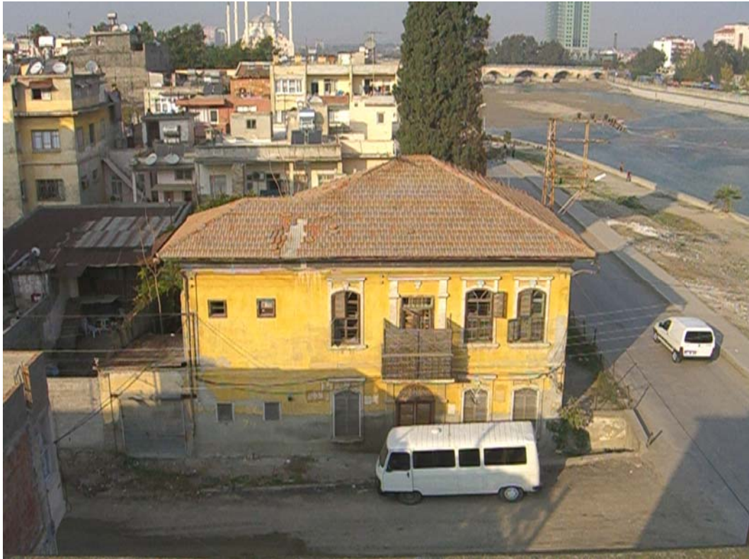
Şekil A.127: Şubat 2006'da yapılan yeni kaldırım döşemesinden önce çekilmiş bir fotoğrafta 8 Sokak'ın asfalt zemini (Aralık 2005'te yapılan tüm ölçümler bu zemin üzerinde belirlenen giriş kotu baz alınarak yapılmıştır.)
