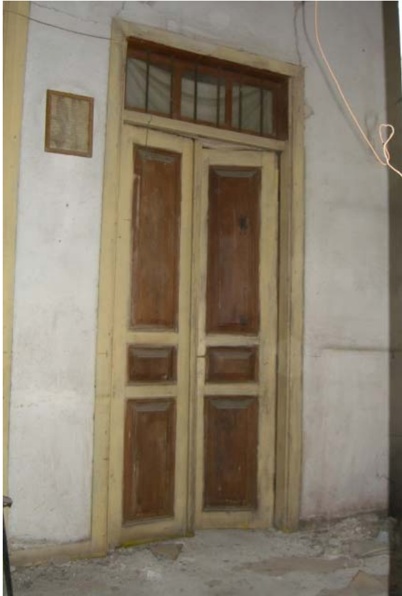
Şekil A.105: 107 mekânının giriş kapısı
