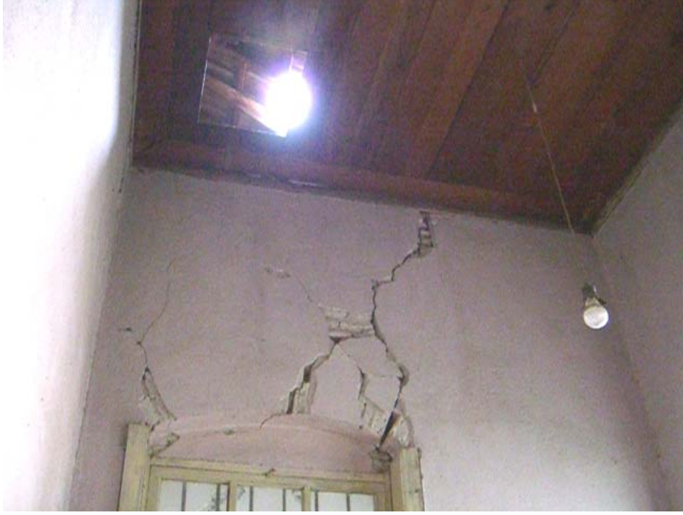
Şekil A.84: 102 mekânının tavanında yer alan çatı arasına çıkmayı sağlayan boşluk
