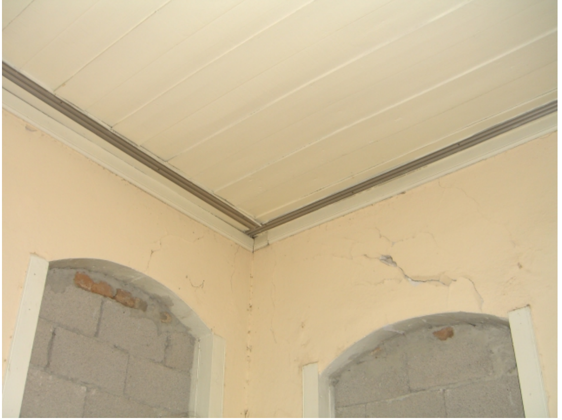
Şekil A.52: Z06 mekânının tavanı
