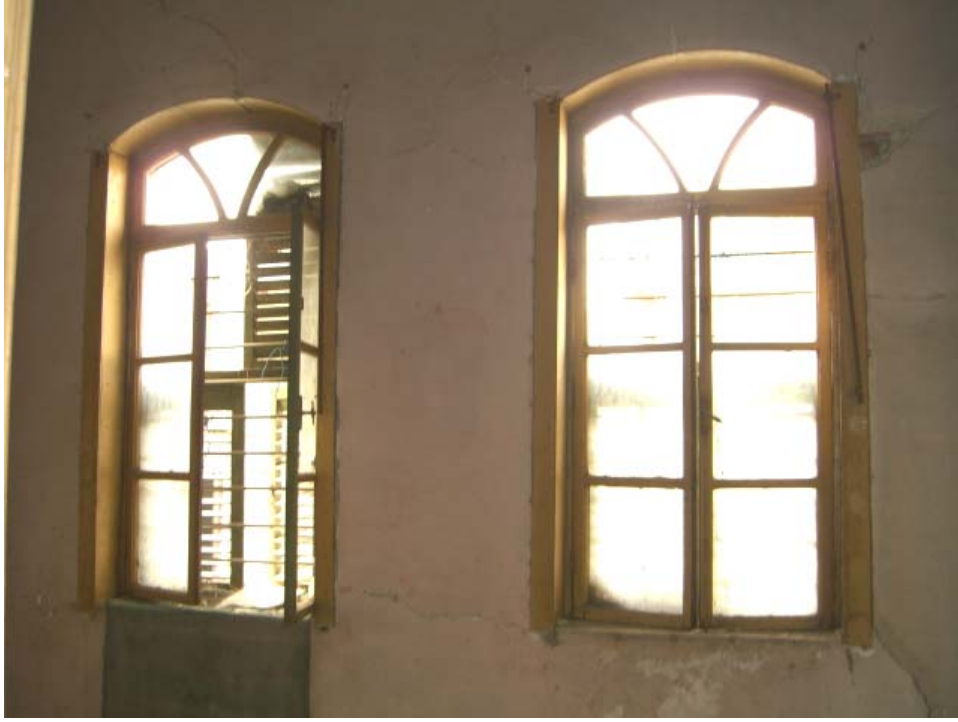
Şekil A.98: 105 mekânının güney duvarındaki pencereler
