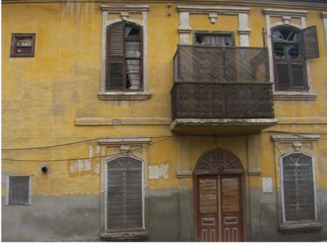
Şekil A.126: Güney cephesinde kesilen kat silmesi
