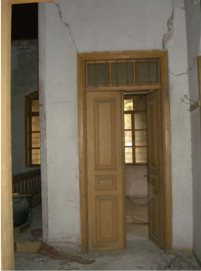
Şekil A.91: 104 mekânının giriş kapısı
