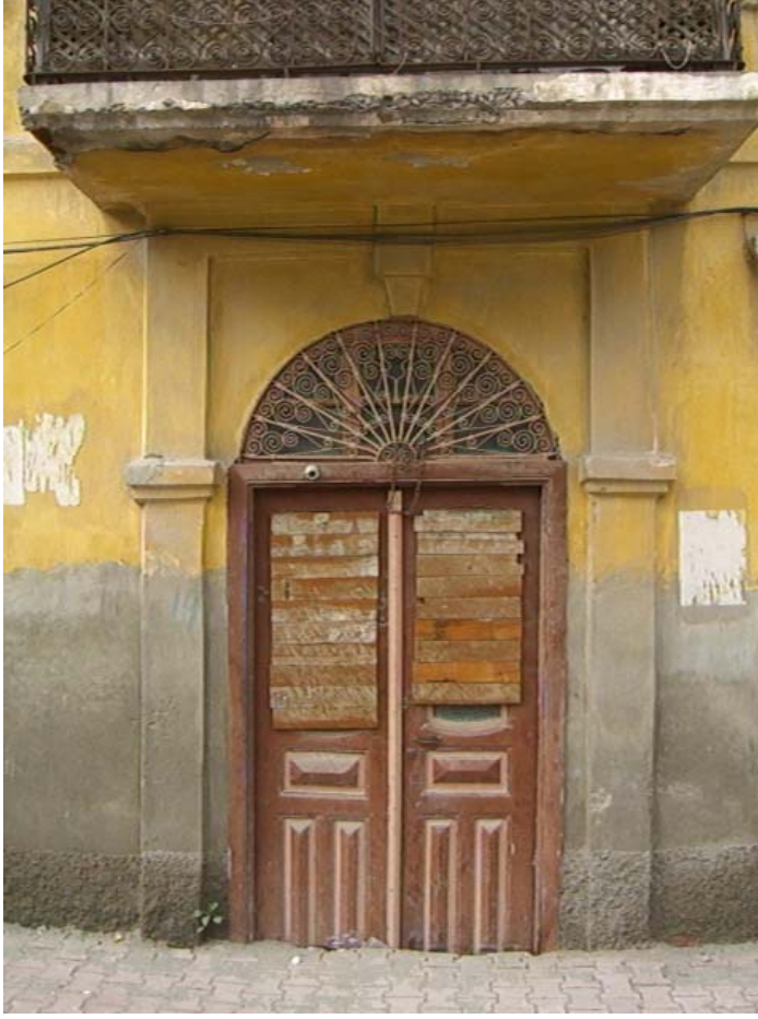
Şekil A.130: Güney cephesinde yer alan -özgün- giriş kapısı
