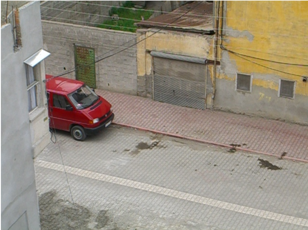
Şekil A.129: Şubat 2006’da yapılan yeni kaldırım döşemesine göre asma kilidi kullanılamaz hale gelen bahçe kapısı
