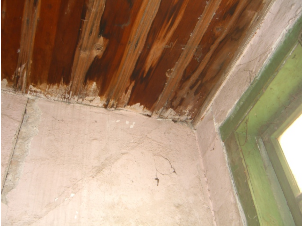
Şekil A.114: 109 mekânının giriş bölümündeki ahşap tavan
