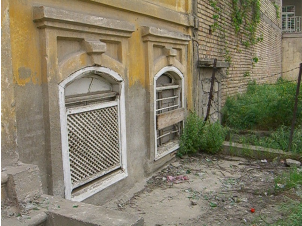
Şekil A.41: Z04 mekânının doğu duvarındaki pencerelerin cepheden görünüşü
