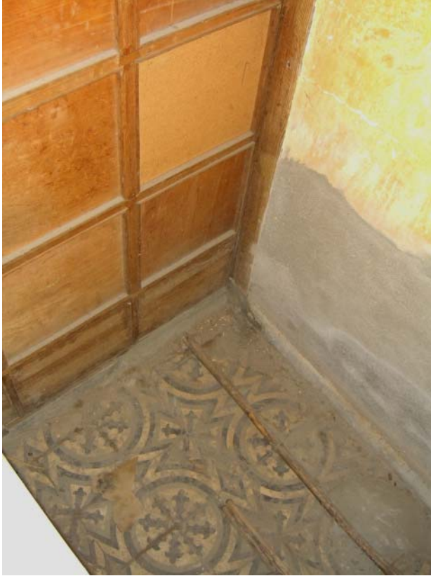
Şekil A.37: Z03 mekânının döşeme malzemesi karosimanlar
