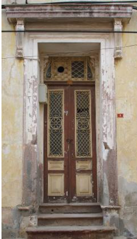
Şekil B.83: Selamet Caddesi no. 9'daki tepe pencereli, camlı kapı
