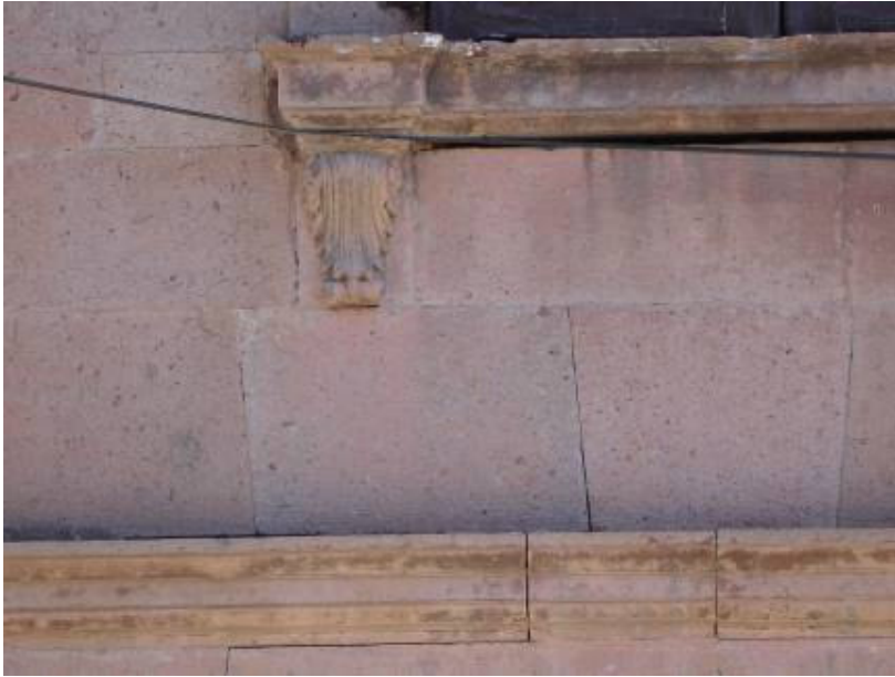
Şekil B.132: Yanaşık derzli kesme sarmısak taşı blokları
