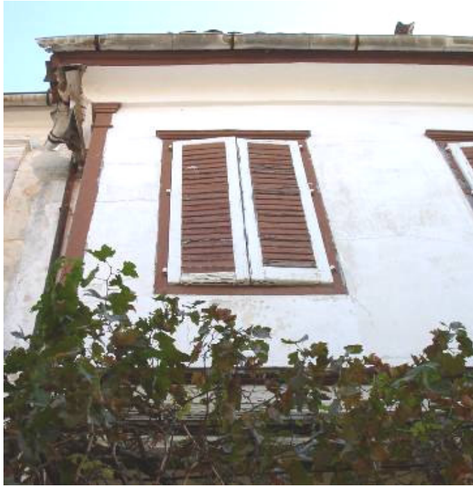
Şekil B.139: Ahşap karkas sistemde inşa edilmiş üst kat ve çıkma örneği (Gayret Sokak no. 32)
