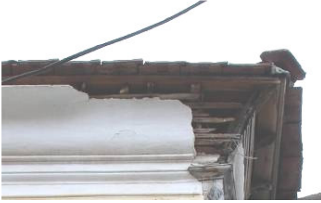
Şekil B.129: Bağdadi çıtalı, üstü sıvanmış silme
