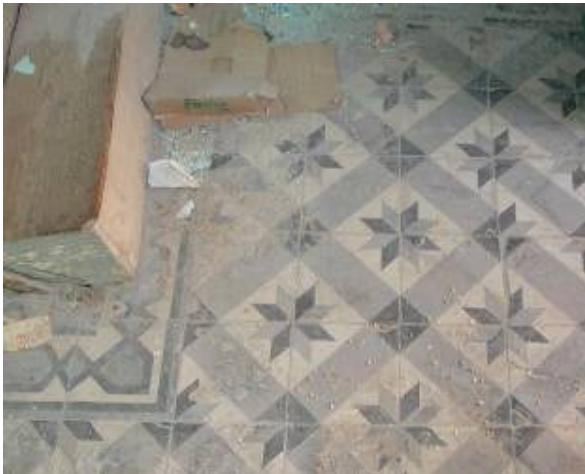
Şekil B.145: Terazzo zemin kaplaması (Şeref Sokak no. 24)
