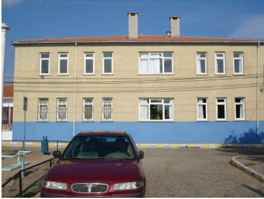
Şekil B.36: Nuri Zarplı İlkokulu ek binası
