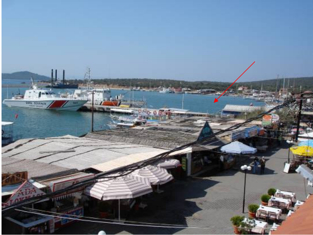
Şekil B.175: Balıkçı barınağı ve çekek yeri
