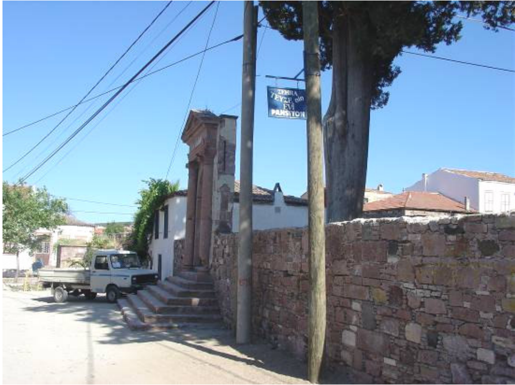
Şekil B.190: Taksiyarhis Kilisesi avlu duvarı, tipik kesme taş duvar
