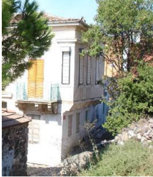
Şekil B.64: Tepebaşı Sokak no. 13'deki yapının doğu cephesindeki köşe çıkma ve düz çıkma
