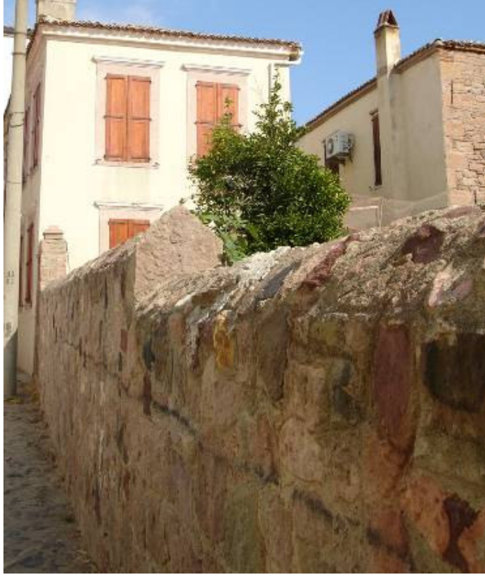
Şekil B.195: Üçgen harpuştalı duvar
