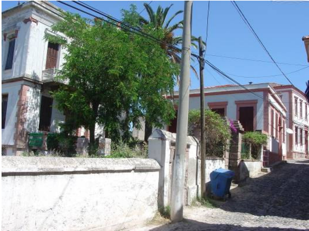
Şekil B.194: Üçgen harpuştalı duvar
