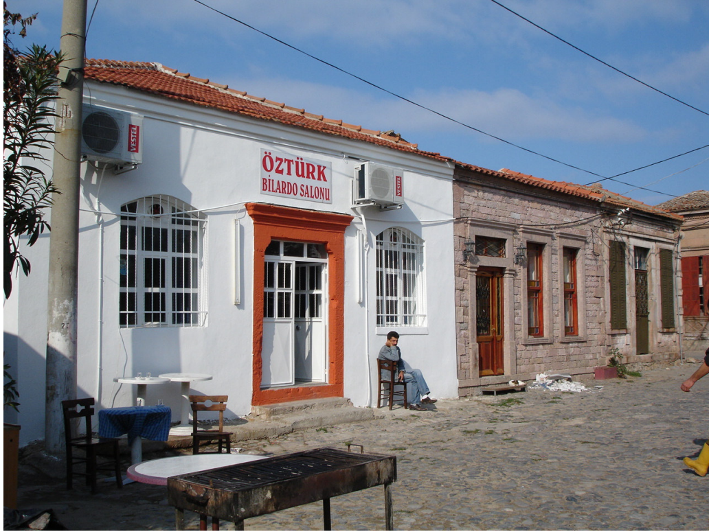
Şekil 4.8: Hayat Caddesi no. 7-9 ve Ayvalık Caddesi no. 9’daki dükkanların mevcut durumu
