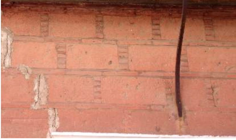
Şekil B.143: Taş+tuğla almaşık örgü sistemi (Selamet Caddesi no. 64)
