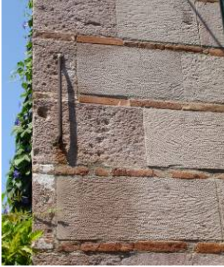
Şekil B.144: Taş+tuğla almaşık örgü sistemi (Hacılar Sokak no. 19)
