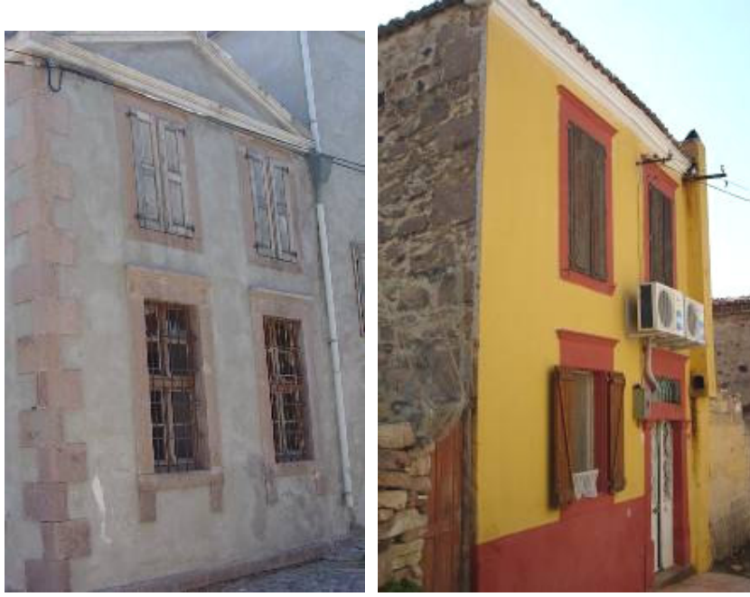
Şekil B.101: Farklı pencere boyutlarına sahip yapılar
