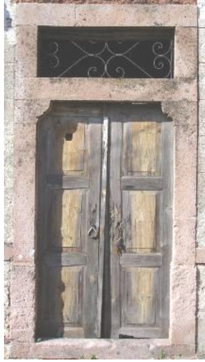
Şekil B.80: Şeref Sokak no. 16 ve 41'deki tepe pencereli, masif kapılar
