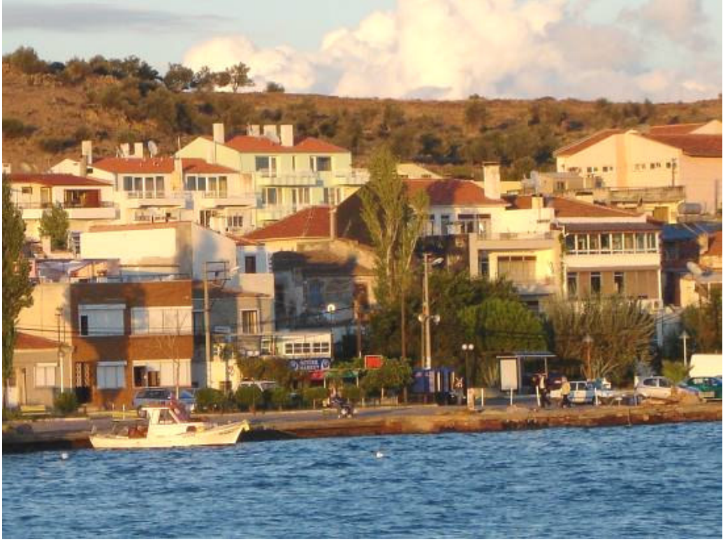
Şekil C.3: Sahildeki kaçak katlar, teras çatılar
