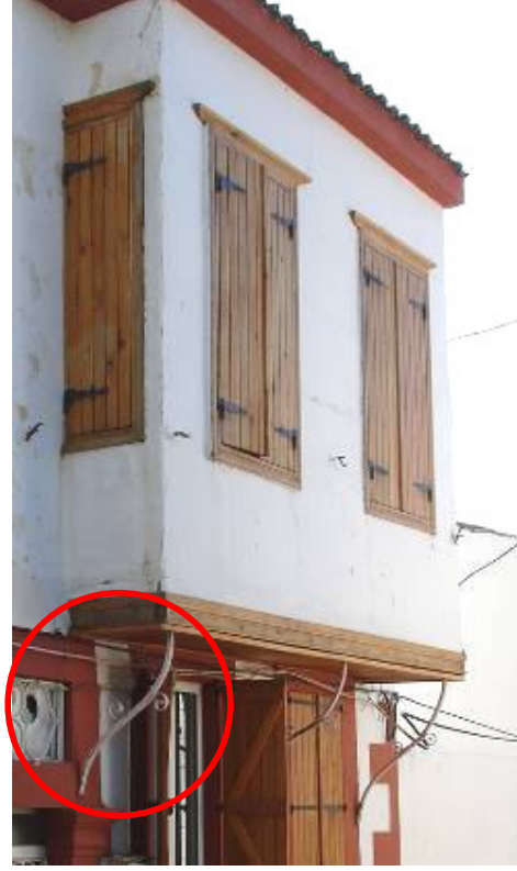
Şekil B.74: Cumhuriyet Caddesi no. 24 ve Uzun Sokak no. 22'deki metal konsollar
