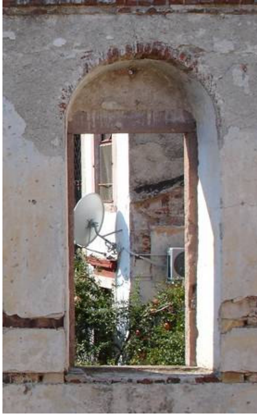
Şekil B.102: Kemerli pencere ve düz atkılı sövesi
