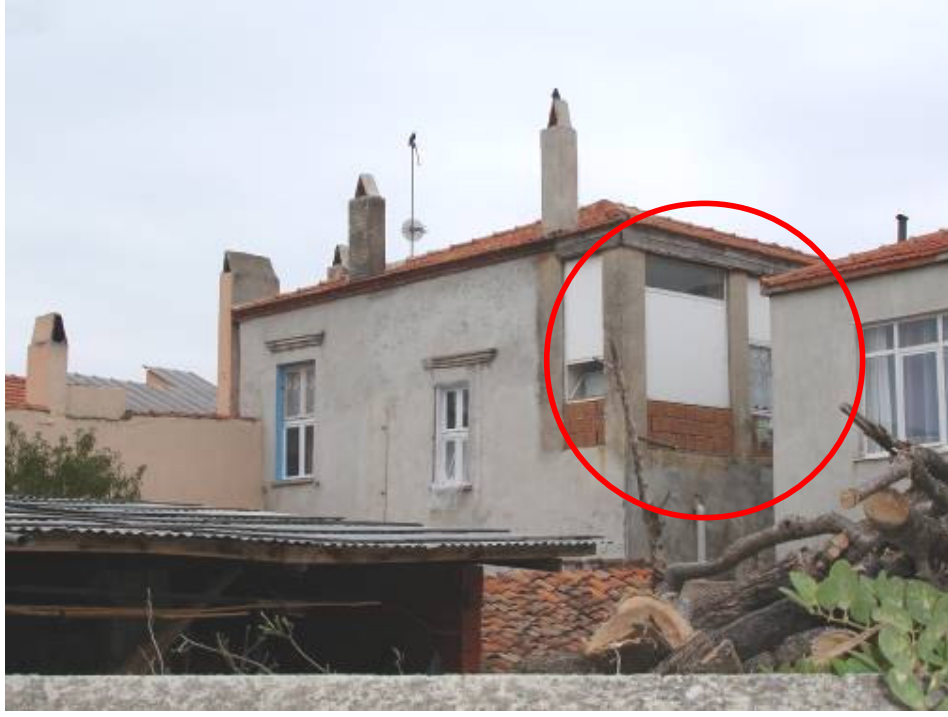
Şekil C.9: Selamet Caddesi no. 64'teki yapının kapatılmış balkonu
