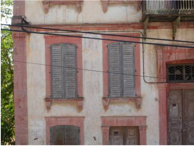
Şekil B.125: Kat silmesi (Şeref Sokak no. 5)
