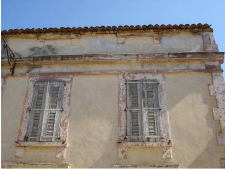
Şekil B.124: Kat silmesi (Selamet Caddesi no. 20)
