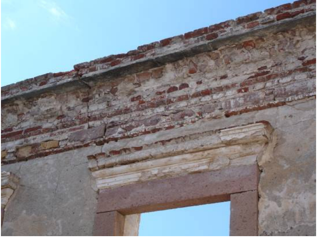
Şekil B.146: Saçak silmesini oluşturan tuğla sıraları
