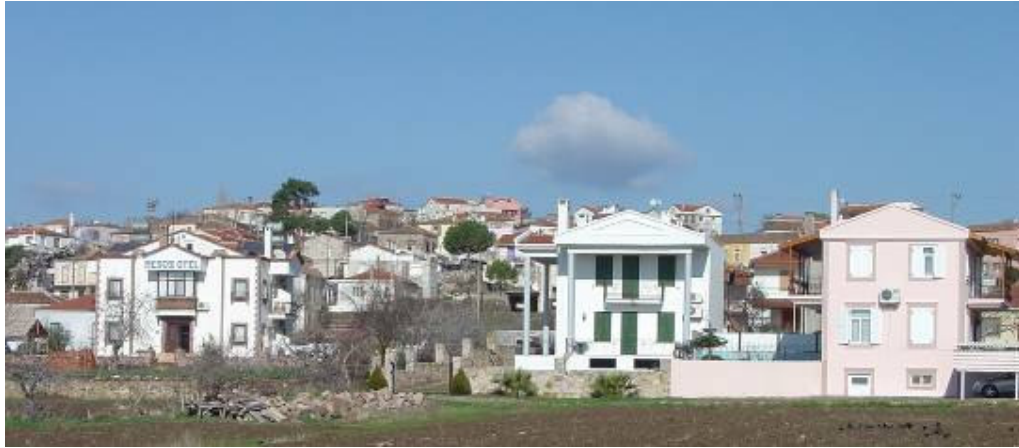
Şekil D.6: Yapılaşma koşullarına göre yapılan yeni yapılar
