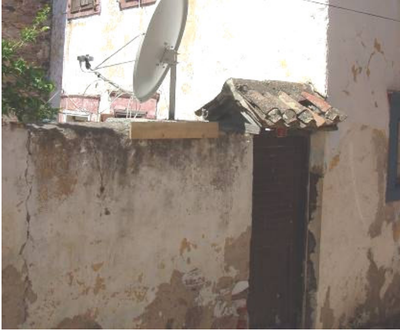
Şekil B.198: Sıvalı bahçe duvarı
