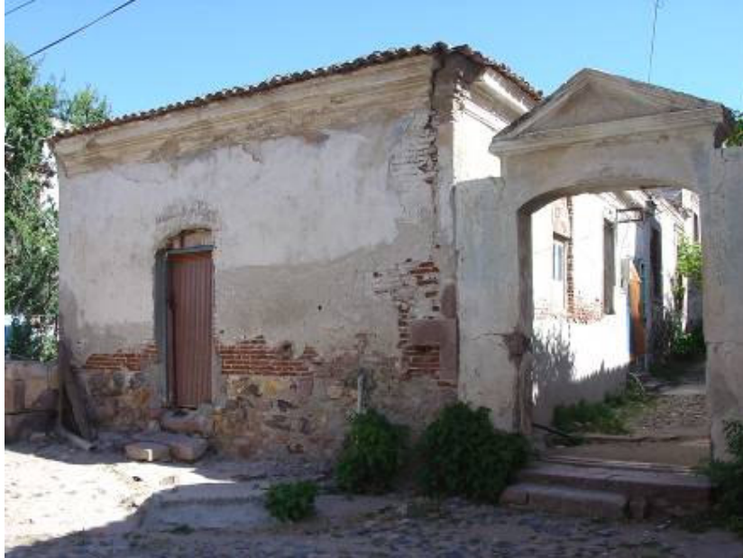
Şekil B.31: Taksiyarhis Kilisesi'nin kuzeyindeki yapılardan biri
