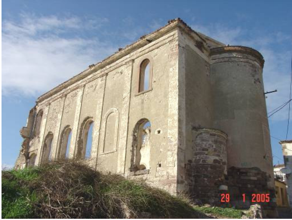
Şekil B.22: Panaya (Aya Triada) Kilisesi güney ve doğu cepheleri (Bayır Sokak'tan bakış)
