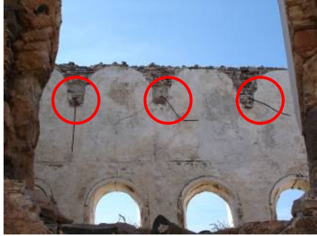
Şekil B.25: Panaya (Aya Triada) Kilisesi'ndeki metal berkitme elemanları
