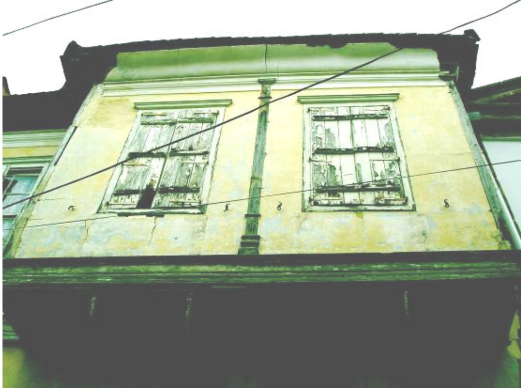
Şekil B.138: Ahşap karkas sistemde inşa edilmiş üst kat ve çıkma örneği (Cumhuriyet Caddesi no. 24)
