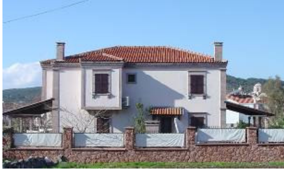
Şekil D.5: Yapılaşma koşullarına göre yapılan yeni yapılar
