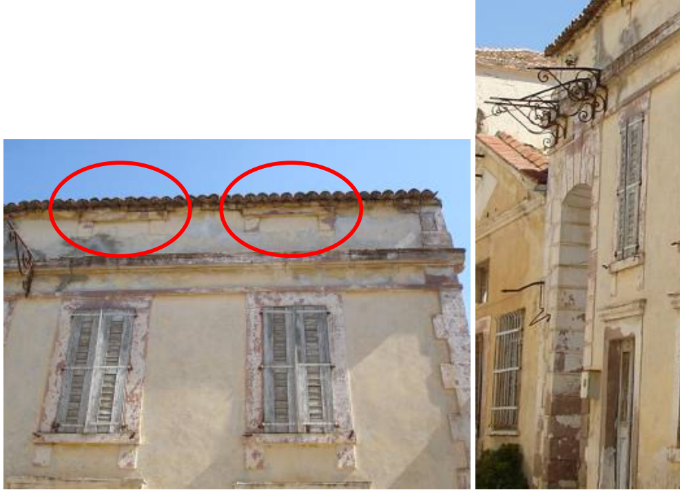
Şekil D.19: Selamet Caddesi no. konutun yokolmuş üst katının ve balkonunun izleri
