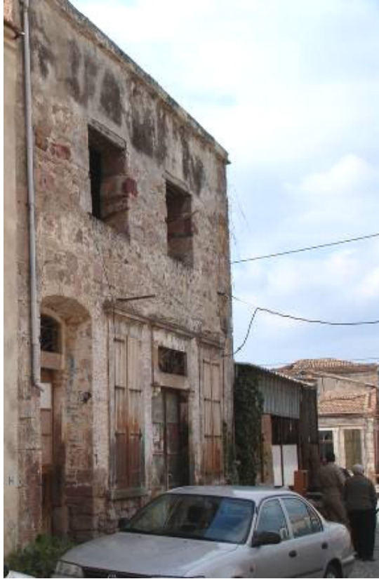
Şekil C.14: Teras çatı ve değişmiş üst kat pencereleri
