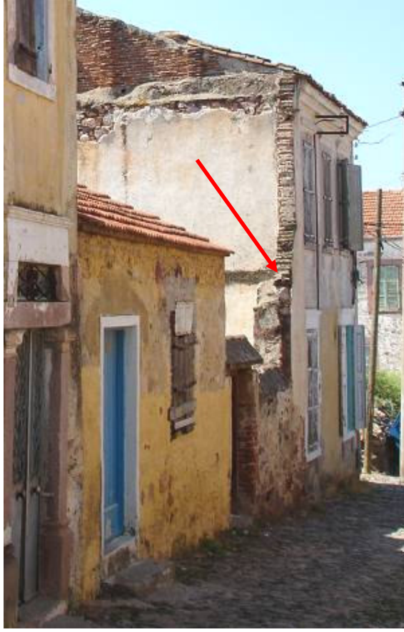
Şekil D.24: Şeref Sokak 2. Geçit no. 6'daki yapının yanındaki duvar kalıntısı
