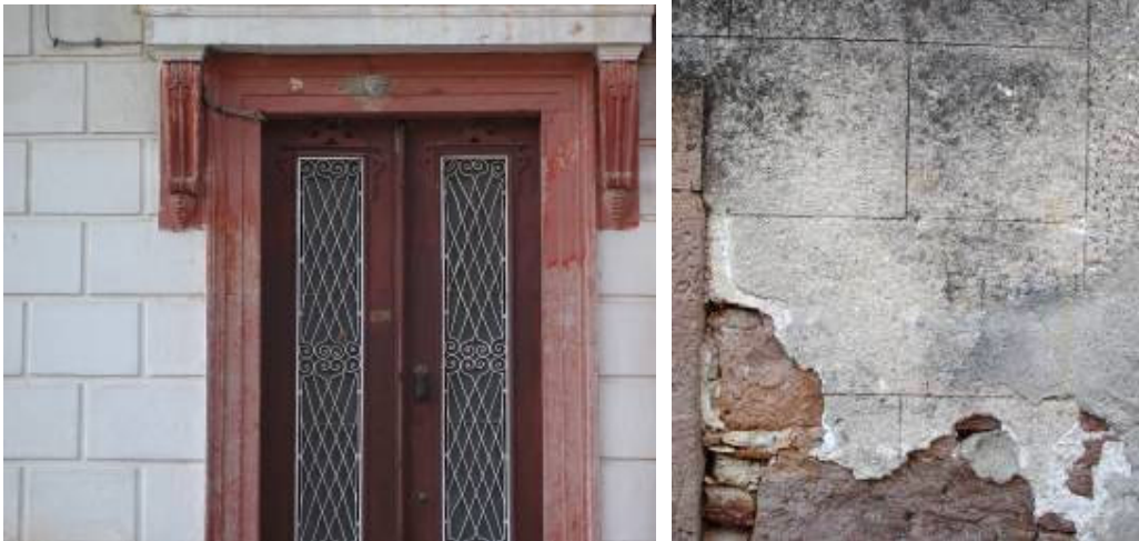
Şekil B.142: Kesme taş görünümlü derzleme tekniği
