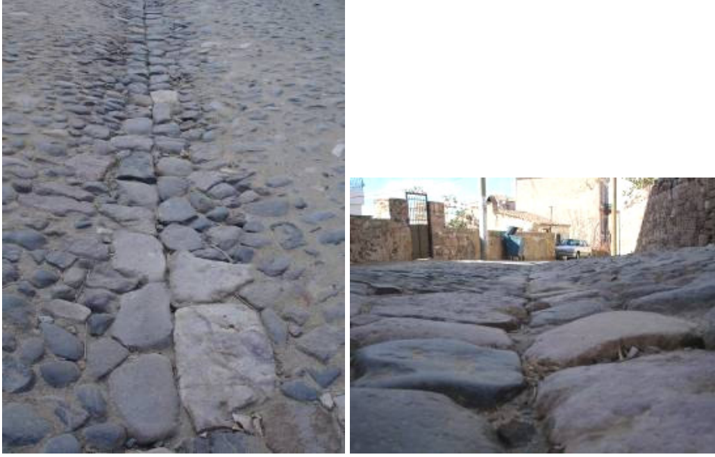
Şekil B.186: Geleneksel taş kaplama ve oluk sistemi
