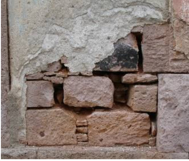
Şekil B.140: Sıvanmış taş duvar
