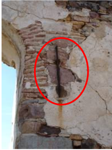
Şekil B.25: Panaya (Aya Triada) Kilisesi'ndeki metal berkitme elemanları
