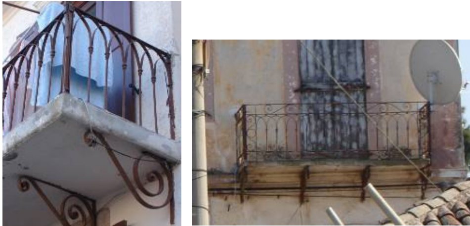
Şekil B.73: Hayat Caddesi no. 43 ve Orta Sokak no. 48'deki ferfoje balkon konsolları
