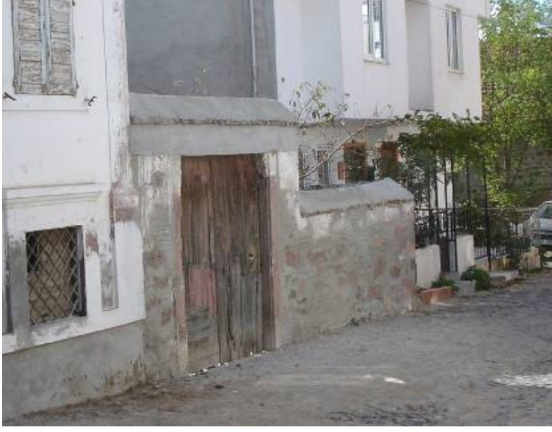
Şekil B.197: Sıvalı bahçe duvarı
