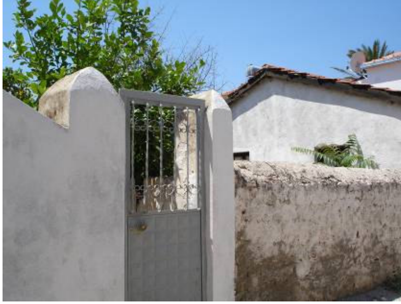
Şekil B.199: Sıvalı bahçe duvarı
