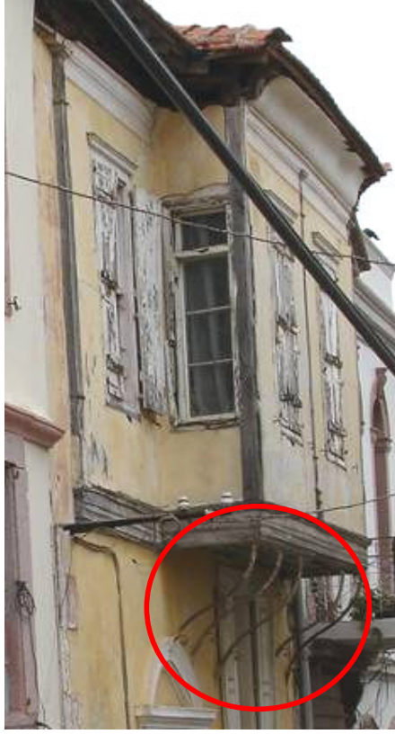
Şekil B.74: Cumhuriyet Caddesi no. 24 ve Uzun Sokak no. 22'deki metal konsollar
