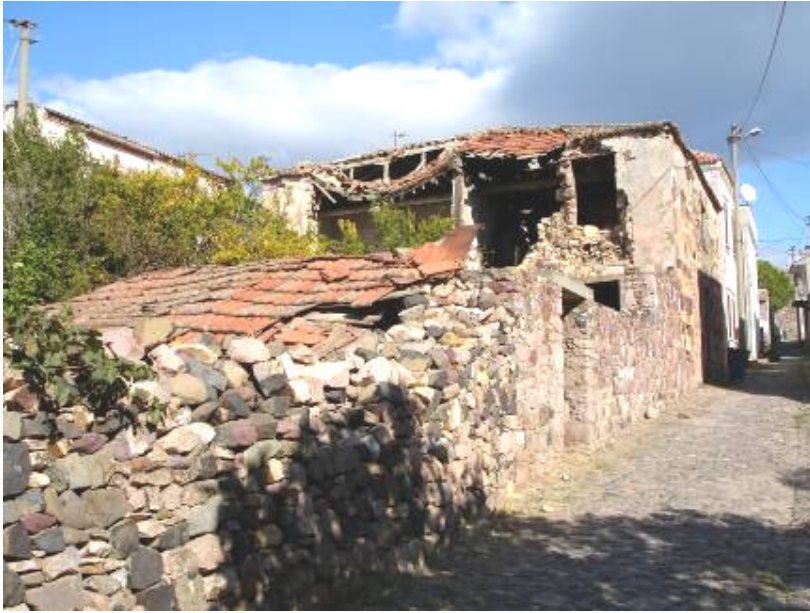
Şekil B.192: Moloş taş duvarlar
