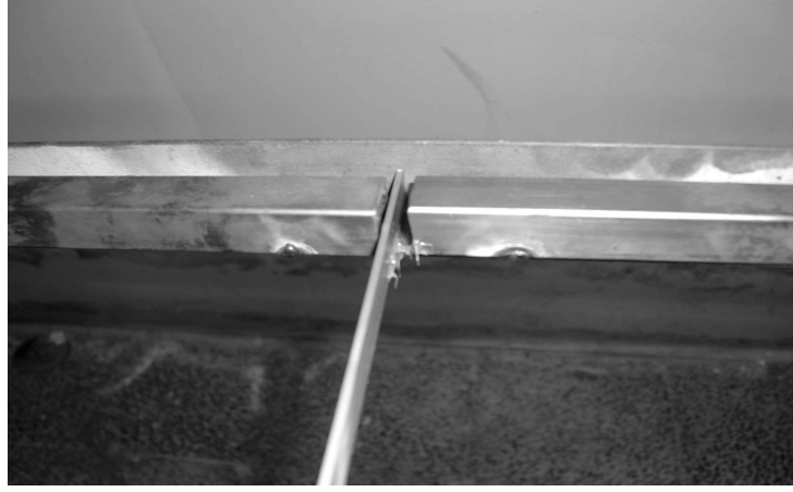
Şekil 3.23 Enine elemanların bağlantıları.
