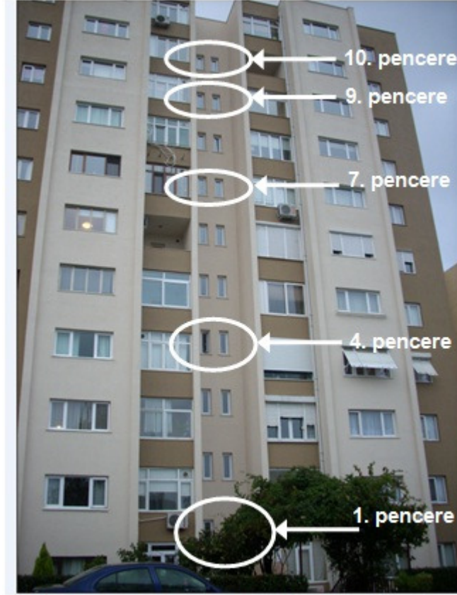
Şekil 7.14 : Bina-3 üzerinde test yapılan merdiven boşluğu alanı ve birimlerin yerleştirildiği pencereler.
