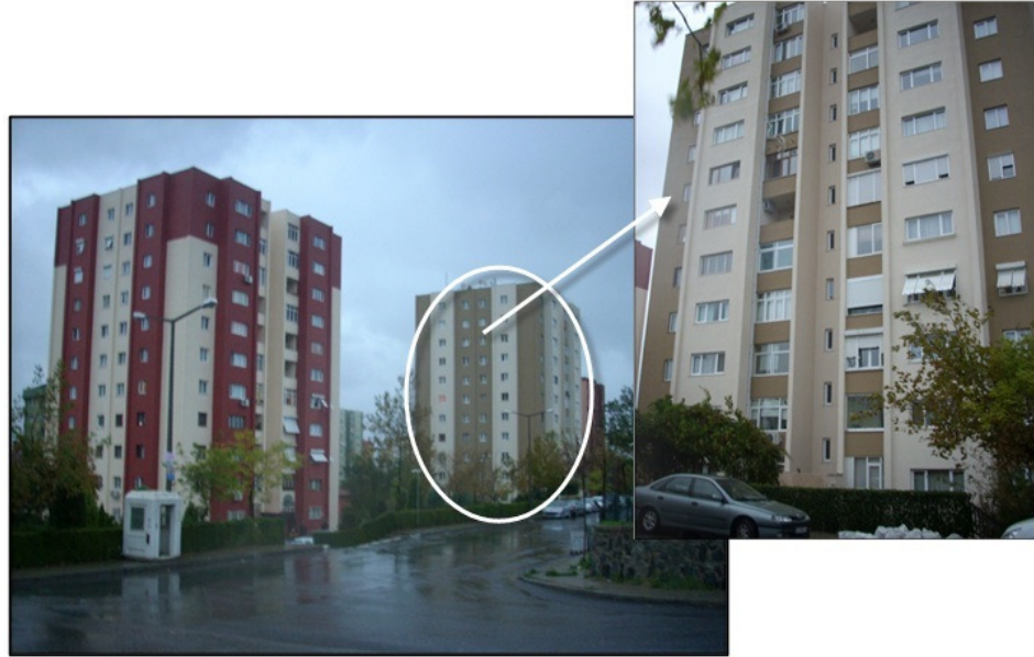
Şekil 7.3 : Toplu konut içinde test yapılan blok (Bina-3) ve ölçüleri.
