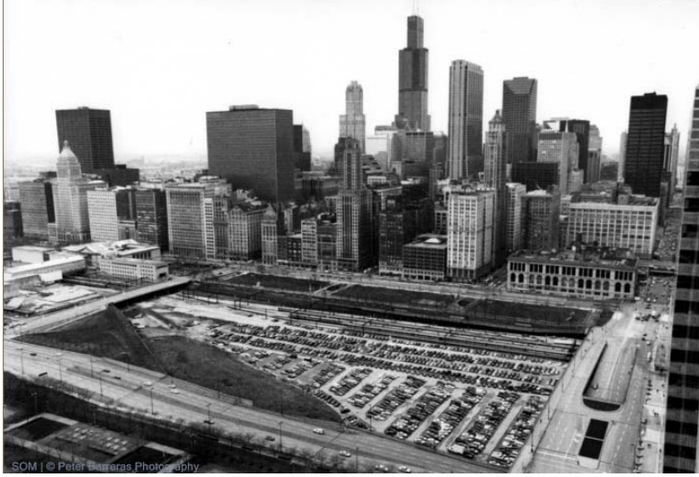
Şekil 5.23 : Park alanının dönüşümden önceki durumu.
