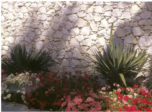
Şekil 2. 19 Taş duvar örneği
