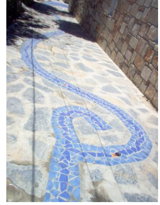
Şekil 3. 49 Su Hotel'e giden yol döşemesi (Fotograf:Alev Hindistan)
