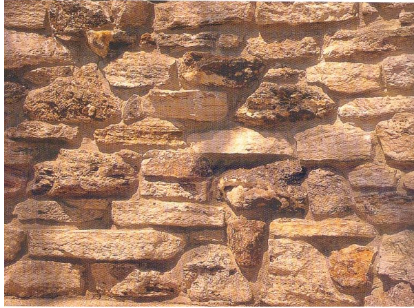
Şekil 2. 18 Taş duvar örneği
