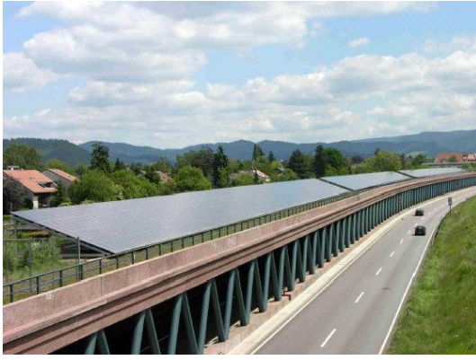
Şekil 2.29: Yapay gürültü perdesi-solar enerji eldesi, B39 karayolu, Freiburg, Almanya (Url-8, 2010).
