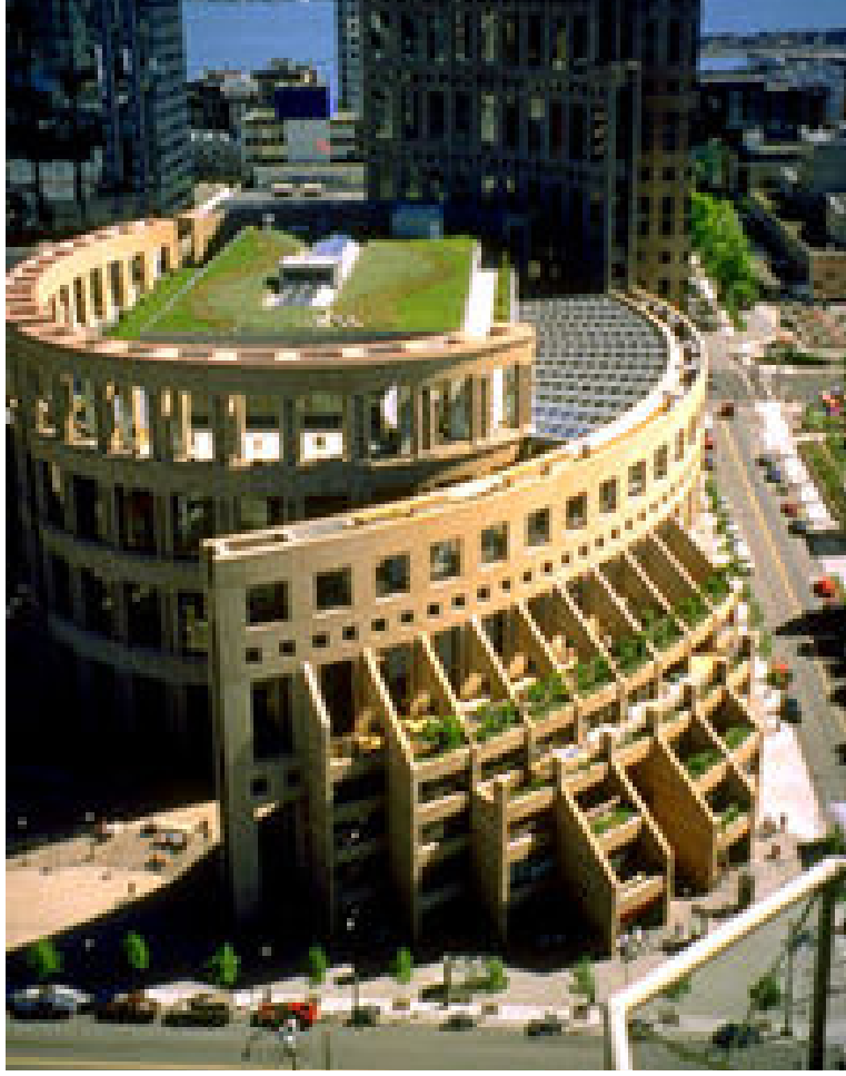
Şekil 4.2 : Vancouver kütüphane binası
